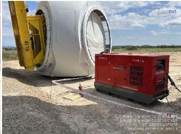
Extintor y material antiderrame junto grupo electrógeno, MR1-3 y MR1-1.
