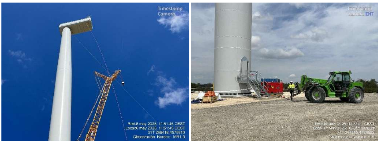
Imagen 1. Finalización de montaje de nacell en MR1-3 y finalización de trabajos en MR1-6.
