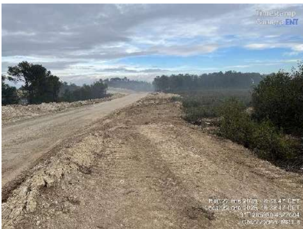
Paso de maquinaria sobre acopio de T.V. Revisión excavación zanjas en MR1-6 a vaguada.
