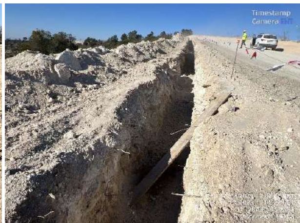
Limpieza y retirada de restos vertido de hormigón en MR1-1. Tablones instalados en zanjas para evitar atrapamiento de fauna.
