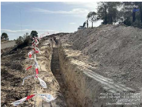
Apertura de zanja para tendido de media tensión. Vertido de hormigón en MR1-1.
