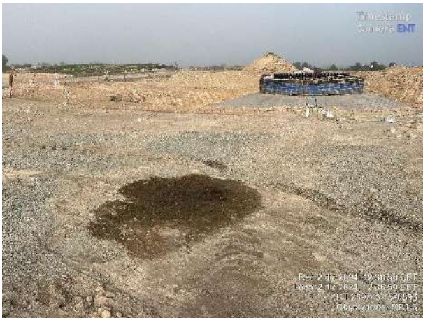
Derrame de aceite/hidráulico en MR1-3. Correcta instalación de generadores y presencia de extintores.
