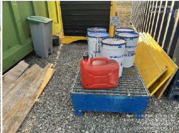
Entorno de Punto Limpio despejado y ordenado. Pinturas y bidón de combustible sobre bandeja antiderrame.
