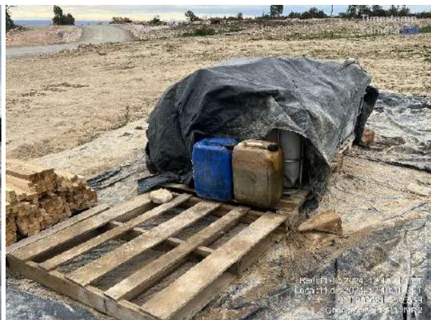
Acopio material para obras de drenaje. Bidones con aceite fuera de cubo antiderrame.
