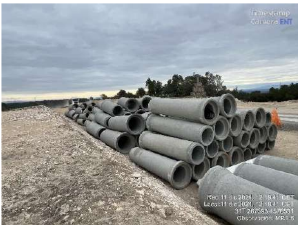
Acopio material para obras de drenaje. Bidones con aceite fuera de cubo antiderrame.
