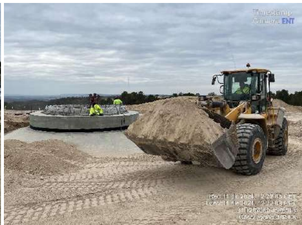
Mejoras en señalización vial. Trabajos de relleno de cimentación en MR1-6.
