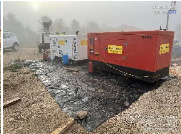
Derrame de aceite/hidráulico en MR1-3. Correcta instalación de generadores y presencia de extintores.
