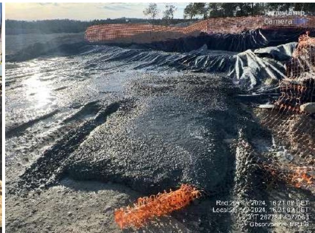
Finalización de hormigonado. Vertido de hormigón de camión bomba fuera de balsa.
