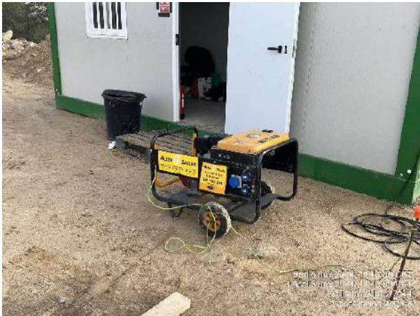
Afección a vegetación por retirada y acopio de bloques. Grupo electrógeno de pared simple sin bandeja.
