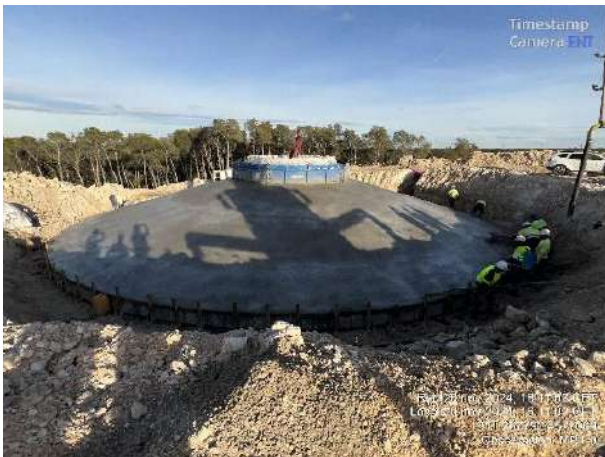
Finalización de hormigonado. Vertido de hormigón de camión bomba fuera de balsa.
