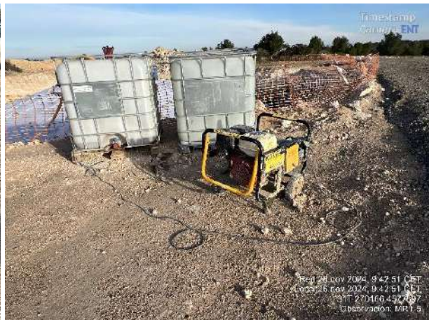
Derrame de aceite en MR1-5. Grupo electrógeno sin bandeja ni manta absorbente en MR1-5.
