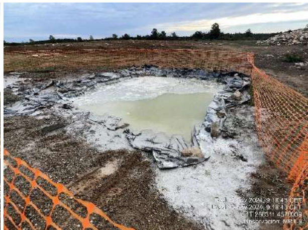
Lavado de cuba de hormigón. Estado de balsa en MR1-9 al finalizar trabajos de hormigonado.
