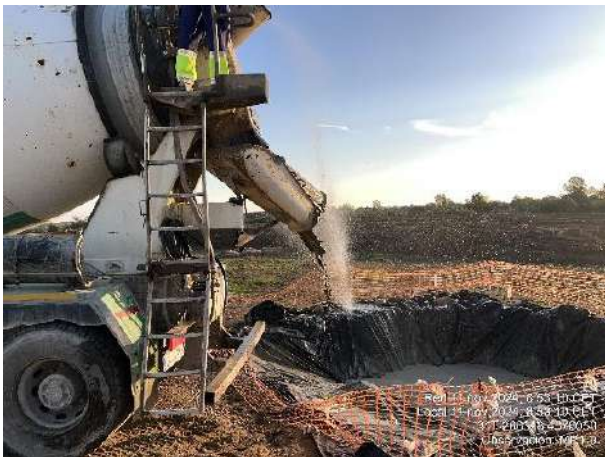
Lavado de cuba de hormigón. Estado de balsa en MR1-9 al finalizar trabajos de hormigonado.
