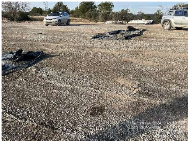
Derrame de aceite en MR1-5. Grupo electrógeno sin bandeja ni manta absorbente en MR1-5.
