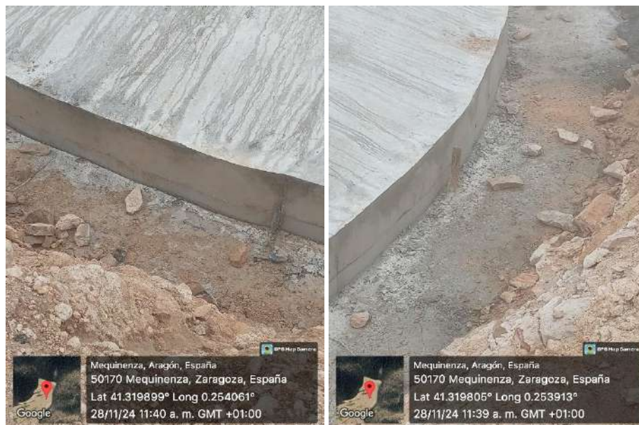
Limpeza en cimentación MR1-5.
