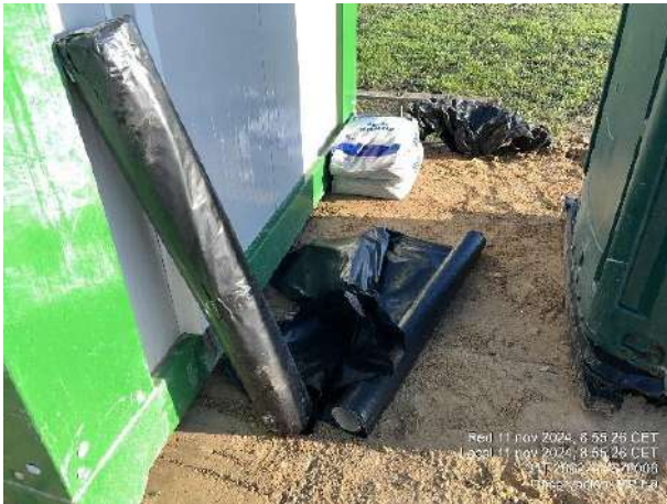
Material antiderrame junto a trabajos de hormigonado. Plásticos bajo hormigoneras y camión bomba.
