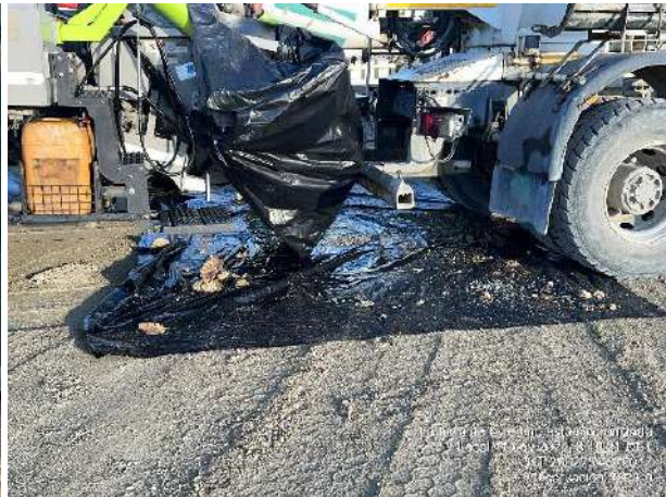
Material antiderrame junto a trabajos de hormigonado. Plásticos bajo hormigoneras y camión bomba.
