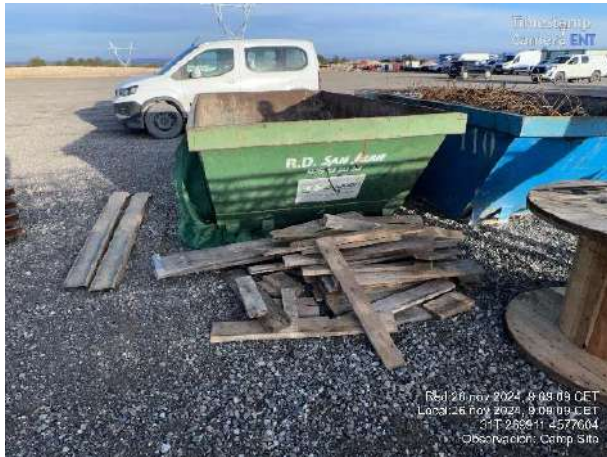
Residuos pendientes de clasificación. Acceso a depósito de R.P. bloqueado. Desorden.
