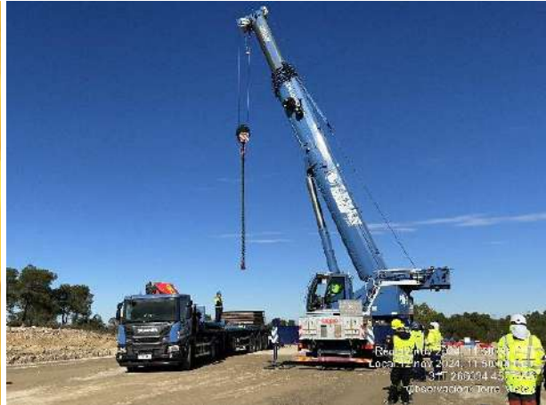
Estado contenedor 'Envases contaminados'. Montaje de grúa para elevación de torre meteorológica.
