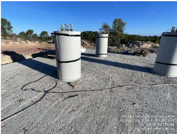
Toma de tierra en Torre Meteorológica. Ejemplo de señalización deteriorada.
