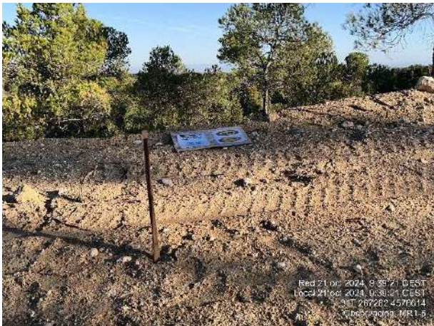
Toma de tierra en Torre Meteorológica. Ejemplo de señalización deteriorada.
