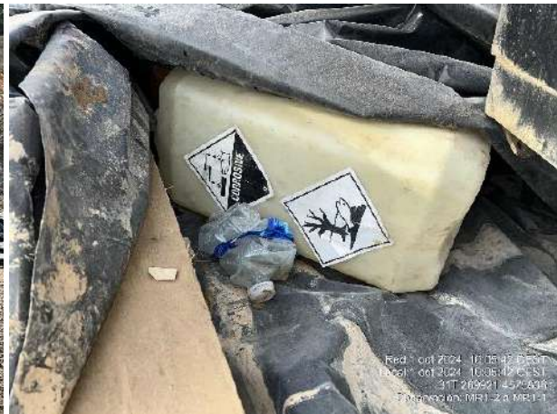
Balsa de lavado de cubas en MR1-3, impermeabilización y vallado deteriorados. Bidón con productos peligrosos fuera de cubo antiderrames.
