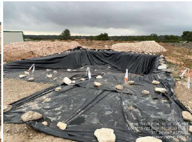
Instalación de toma de tierra en MR1-5. Corregida impermeabilización en balsa MR1-3.
