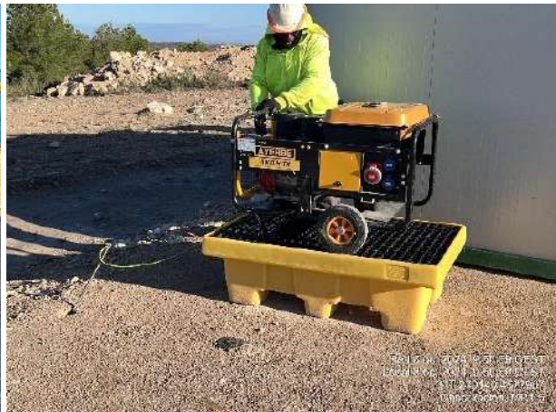
Focos con doble pared y extintor incorporado. Generador reubicado sobre bandeja antiderrame.
