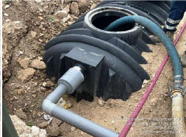
Impermeabilización temporal y aplicación de absorbente. Vaciado de depósito de aguas negras.
