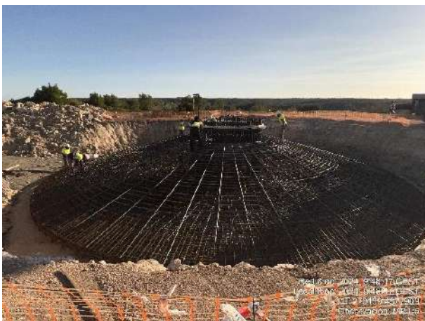
Trabajos de ferrallado en MR1-5. Acumulación de basura en MR1-1.
