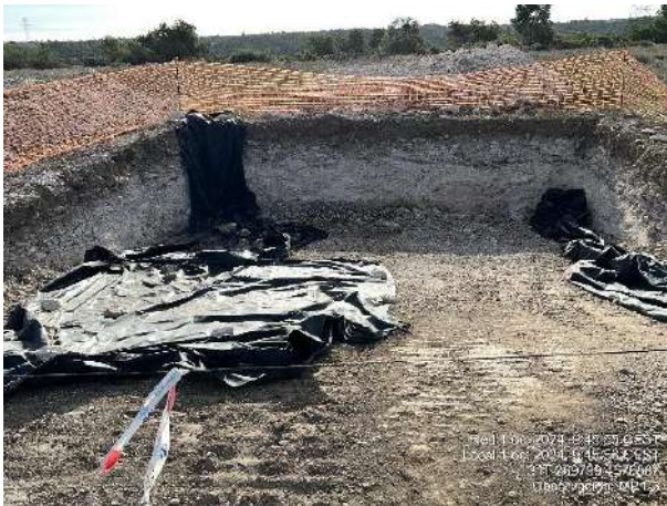
Balsa de lavado de cubas en MR1-3, impermeabilización y vallado deteriorados. Bidón con productos peligrosos fuera de cubo antiderrames.
