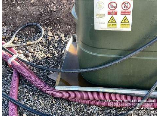
Estado contenedor 'Envases contaminados'. Cubeta antiderrame con agua y restos de gasoil
