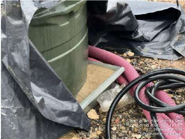
Impermeabilización temporal y aplicación de absorbente. Vaciado de depósito de aguas negras.
