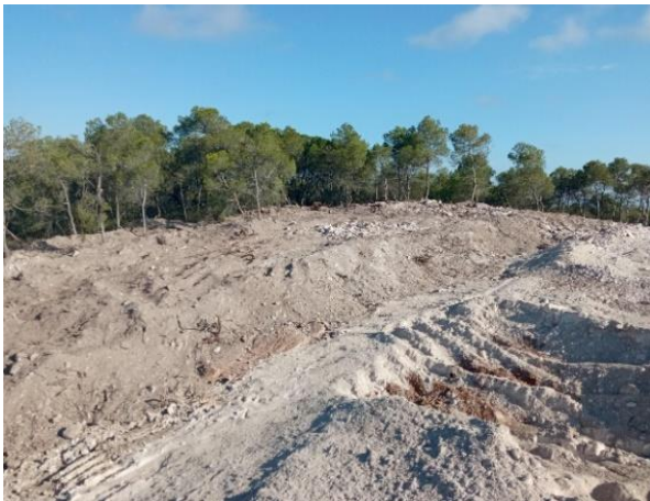
Acopio de materiales rebajados en MR1-7. Vegetación dañada durante rebajamiento de acopio.
