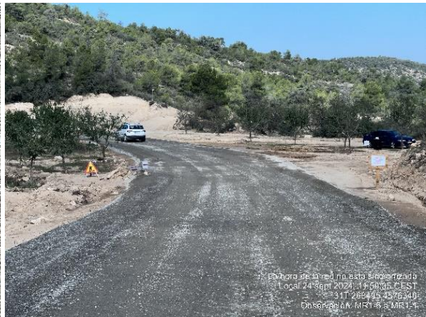
Vertido de hormigón fuera de plástico en MR1-2. Avances en la compactación con zavorra de viales.
