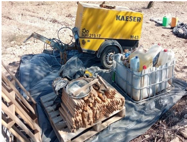
Productos peligrosos y compresor sobre plástico. Bidones fuera de cubo antiderrame.
