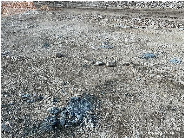
Vertido de hormigón fuera de plástico en MR1-2. Avances en la compactación con zavorra de viales.
