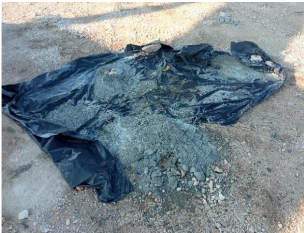
Vertido de hormigón fuera de plástico en MR1-2. Señalización del estado del vial.
