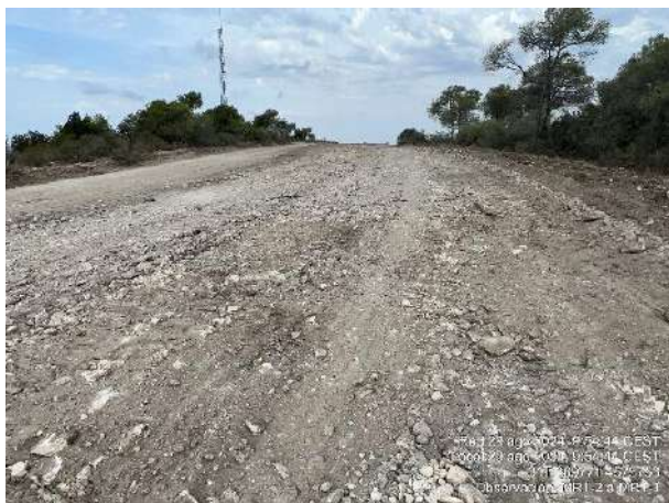
Retirada de tierra vegetal en vial MR1-1 a desvío proyectos. Deterioro momentáneo en estado de viales.
