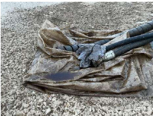
Fugas de aceite, con riesgo por lluvias. Maquinaria trabajando.
