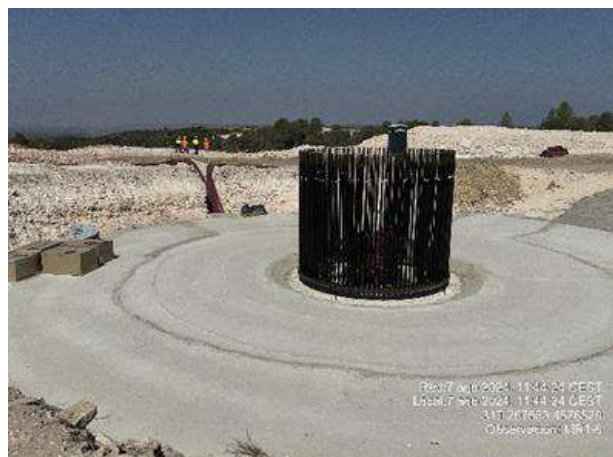
Corrección de la posición de manguitos. Instalación de pernos de fijación en MR1-6
