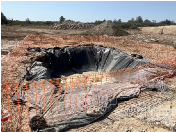
Balsa para limpieza de hormigones. Bandeja con restos de hidrocarburos sobre herramienta de obra.
