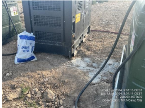
Pequeño derrame de gasoil y aplicación de sepiolita absorbente.
