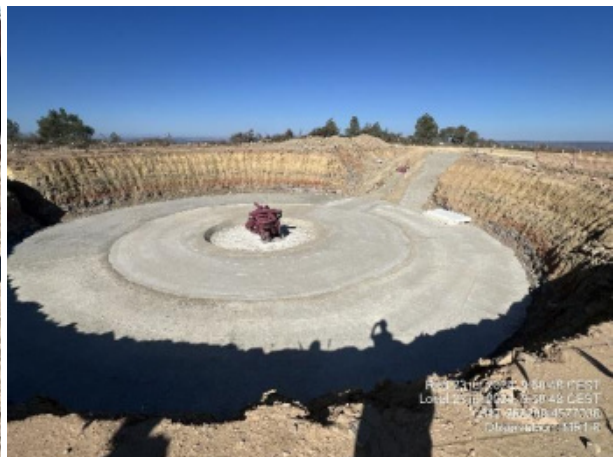
Manguitos hidráulicos sin bandeja antiderrame. Inicio de cimentaciones en MR1-8.
