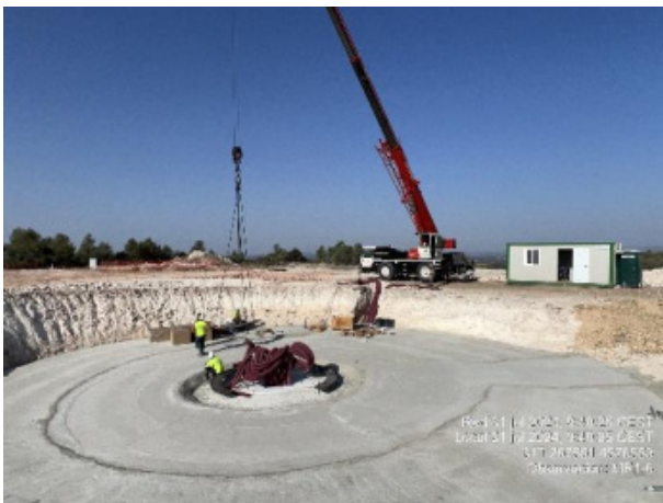
Instalación de pernos de fijación en MR1-6. Acopio en MR1-9 pendiente de escarificación.
