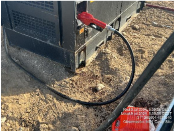
Pequeño derrame de gasoil y aplicación de sepiolita absorbente.
