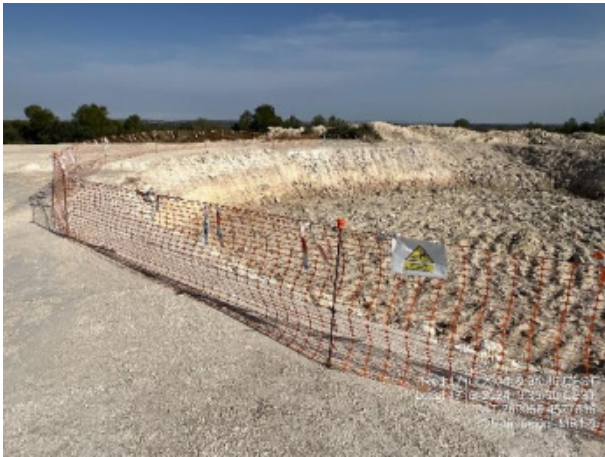
Señalización y medidas de seguridad en fosos. Acúmulo y emisión de polvo en viales.
