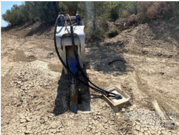
Bandeja antiderrame en martillo neumático. Cimentación lista para forjados en MR1-9
