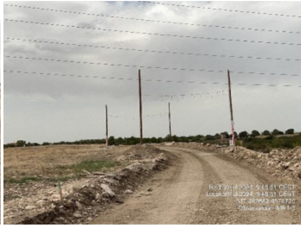
Riegos en vial de MR1-2. Instalación de gálibos en MR1-3
