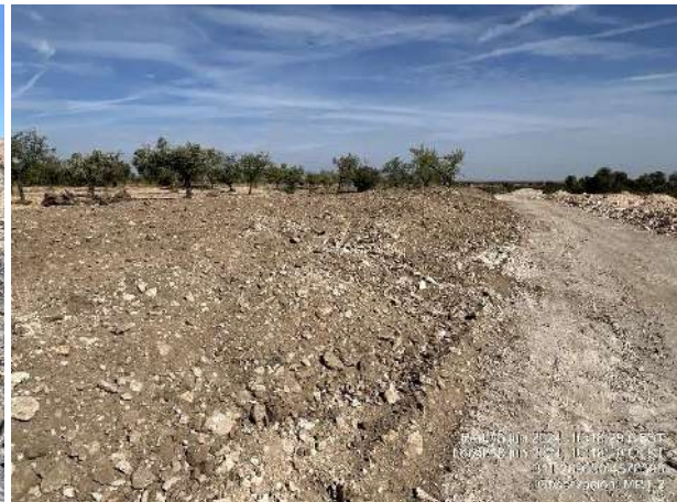
Corrección de acopios de tierra vegetal de altura excesiva.
