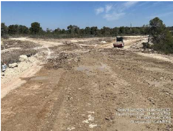
Realización de riegos y compactación de viales. Mejora en el estado de los viales.
