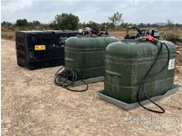
Depósitos con bandeja antiderrame y contenedores de residuos no peligrosos en el punto limpio.
