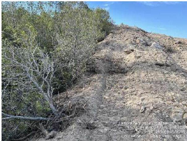
Corrección de acopios de tierra vegetal de altura excesiva.
