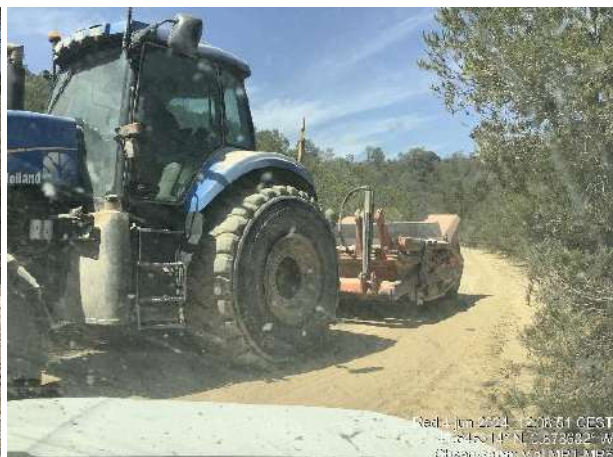
Estado de los viales previo a inicio de riegos. Mantenimiento y reducción de polvo mediante trailla.
