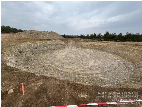
Hueco de cimentación en aerogenerador MR1-9. Mejora de señalización en vegetación HIC.
