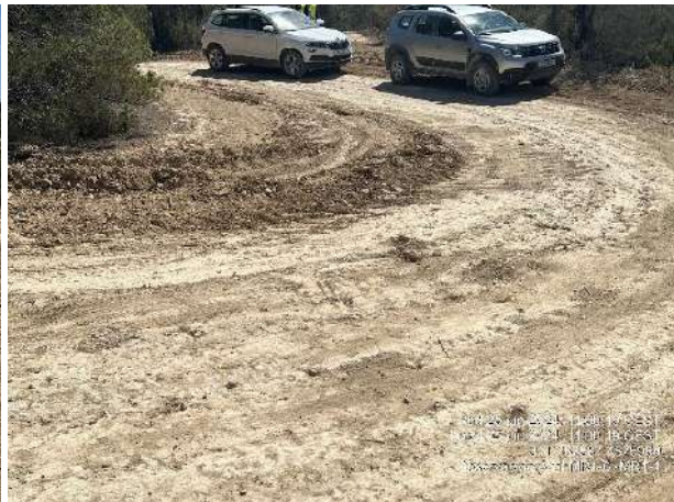
Realización de riegos y compactación de viales. Mejora en el estado de los viales.
