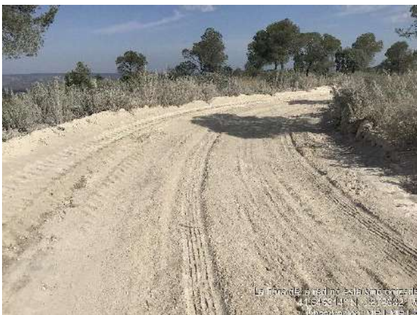
Estado de los viales previo a inicio de riegos. Mantenimiento y reducción de polvo mediante trailla.
