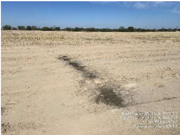
Mancha de aceite en acceso a MR1-2. Almacenaje irregular de productos peligrosos sobre suelo.
