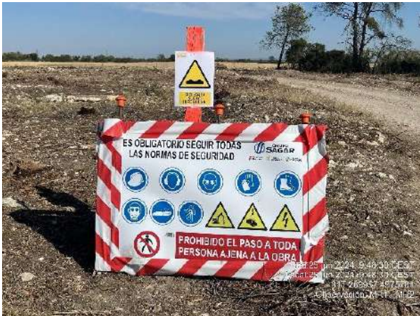
Mejora en señalización de obra. Medidas preventivas, antiderrame y antiincendios.
