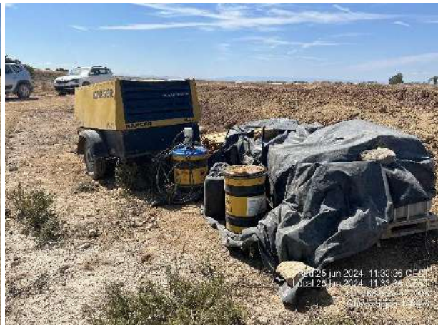
Mancha de aceite en acceso a MR1-2. Almacenaje irregular de productos peligrosos sobre suelo.
