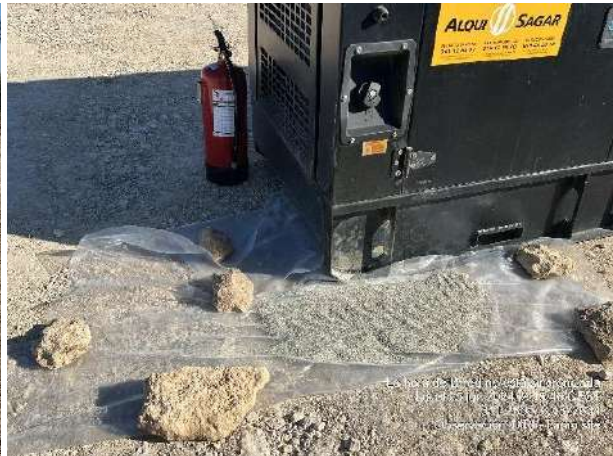
Mejora en señalización de obra. Medidas preventivas, antiderrame y antiincendios.
