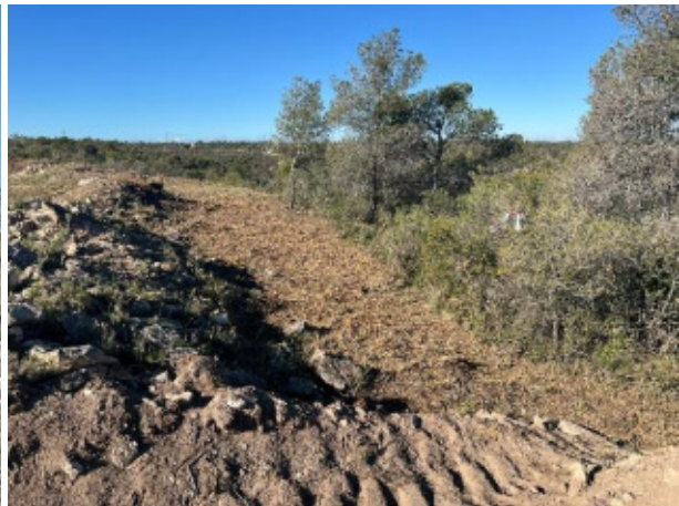
Trabajos de talas y desbroces en viales y accesos.
