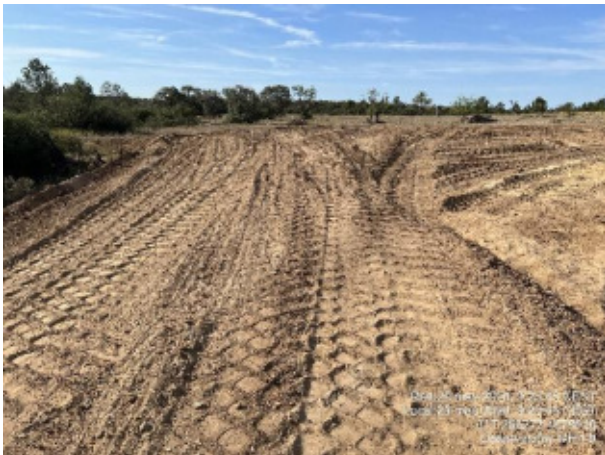
Acopios de tierra vegetal en MR1-9 y tierra vegetal parcialmente retirada en acceso a MR1-2.
