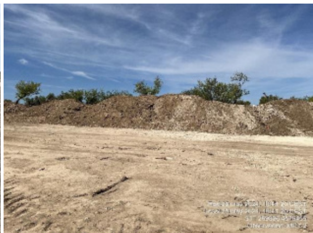
Acopio de altura reglamentaria, se aprecia compactación por paso de maquinaria, a subsanar. Acopio a corregir por altura excesiva.
