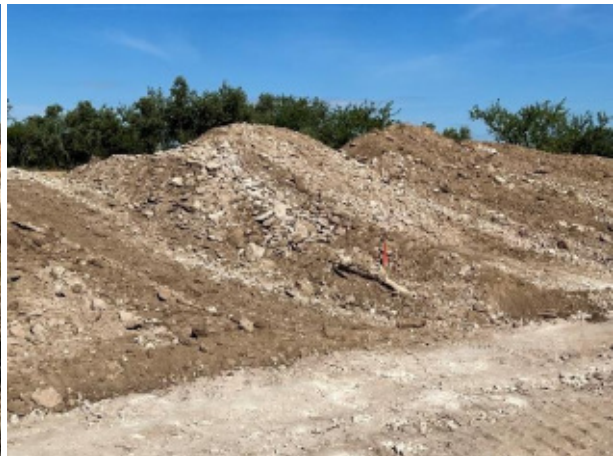
Tierra vegetal parcialmente retirada. Acopios de tierra vegetal de altura excesiva.
