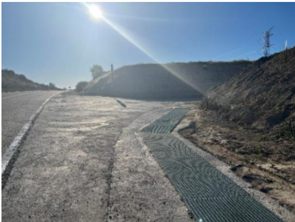
Ausencia de señalización de acceso a obra/salida de camiones y elementos patrimoniales sin balizar.
