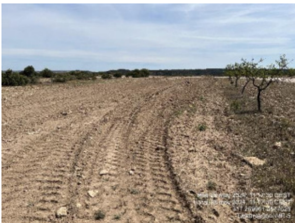
Acopio de altura reglamentaria, se aprecia compactación por paso de maquinaria, a subsanar. Acopio a corregir por altura excesiva.
