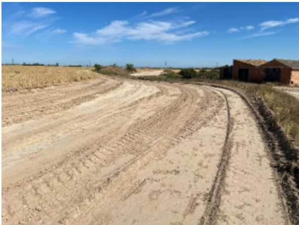
Tierra vegetal parcialmente retirada. Acopios de tierra vegetal de altura excesiva.
