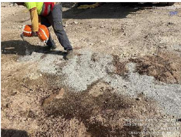
. Aplicación de sepiolita tras avería. Material antiderrame utilizado durante mantenimiento mecánico.
