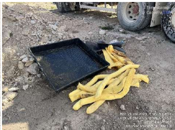
. Aplicación de sepiolita tras avería. Material antiderrame utilizado durante mantenimiento mecánico.
