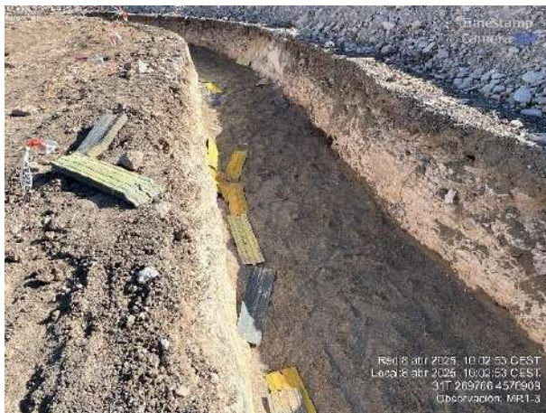
Placas de señalización eléctrica voladas en zanja MR1-3. Residuos pendientes de retirada.
