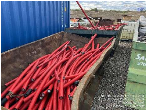
Recortes de cable eléctrico organizados en contenedor para su retirada. Bandejas vacías e instalación de mantas absorbentes.
