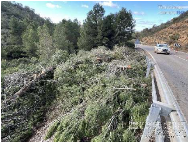
Restos de talas próximos a desmonte. Mantenimientos mecánicos sin protección del suelo.
