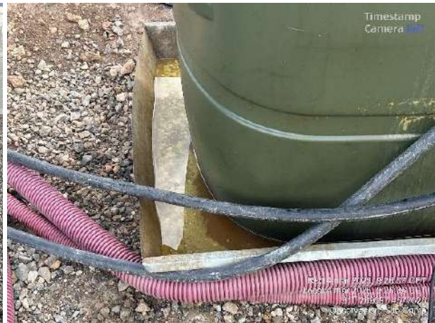
Residuos de material eléctrico. Estado bandeja antiderrame en depósito de combustible.
