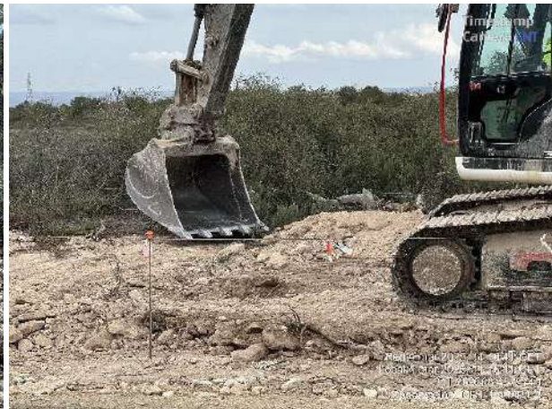
Zanja cubierta entre MR1-9 y MR1-8. Maquinista realiza relleno con cuidado y selección de material adecuado.
