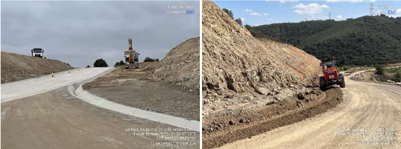
Imagen 1. Finalización de trabajos en entronque con N-211 y perfilado de cunetas.
