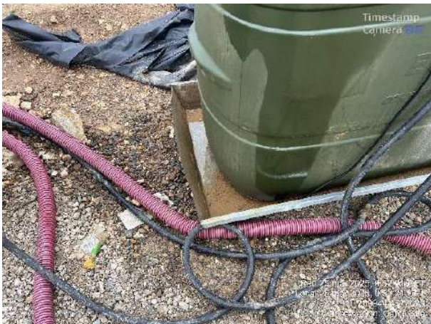
Estado bandeja antiderrame en depósito de combustible. Acopio rebajado en entronque.
