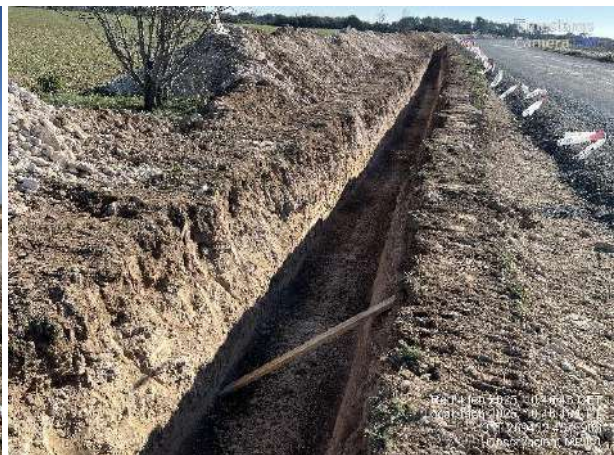
Revisión trazado de zanja sin elementos anti-atrapamiento de fauna. Limpieza y trazado de zanja en MR1-1.
