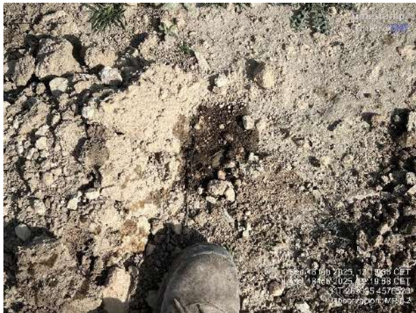
Pequeño derrame de aceite lubricante. Fugas en 'balsa' para grout en MR1-9.
