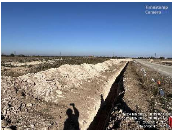
Revisión trazado de zanja sin elementos anti-atrapamiento de fauna. Limpieza y trazado de zanja en MR1-1.
