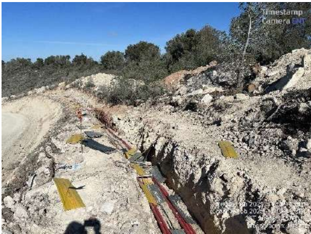
Tendido de cableado. Riegos en viales.
