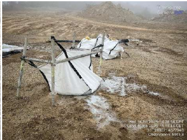
Pequeño derrame de aceite lubricante. Fugas en 'balsa' para grout en MR1-9.
