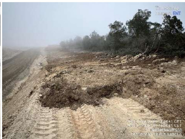
Sellado de bridas. Zanja correctamente tapada en acceso a MR1-6.
