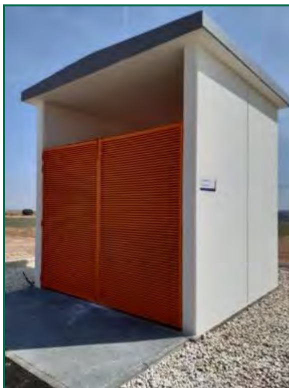
Fotografía 28. Almacén de residuos para gestor autorizado. Fuente: Repsol.
