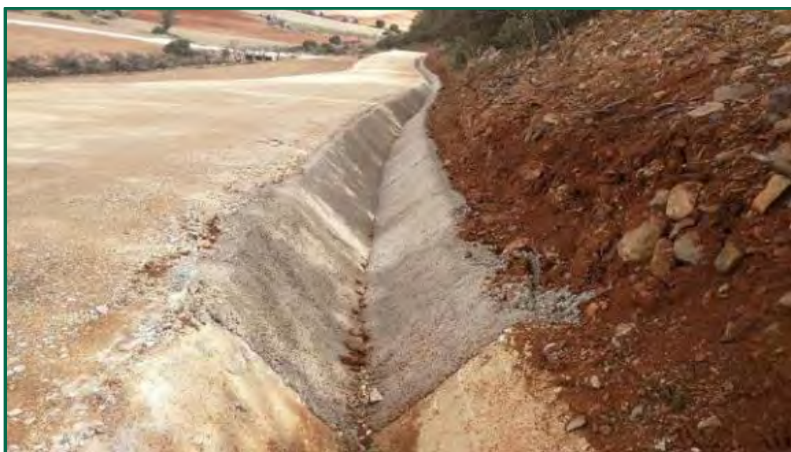
Fotografía 24. Tramo de cuneta hormigonado. (Después)
