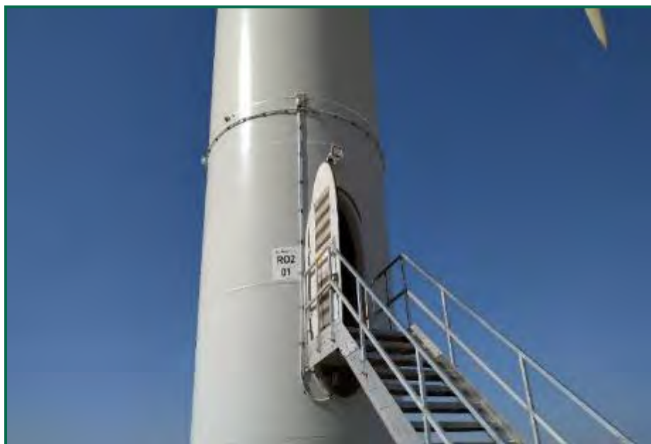
Fotografía 18. Nuevo sistema W4-D10, instalado.
