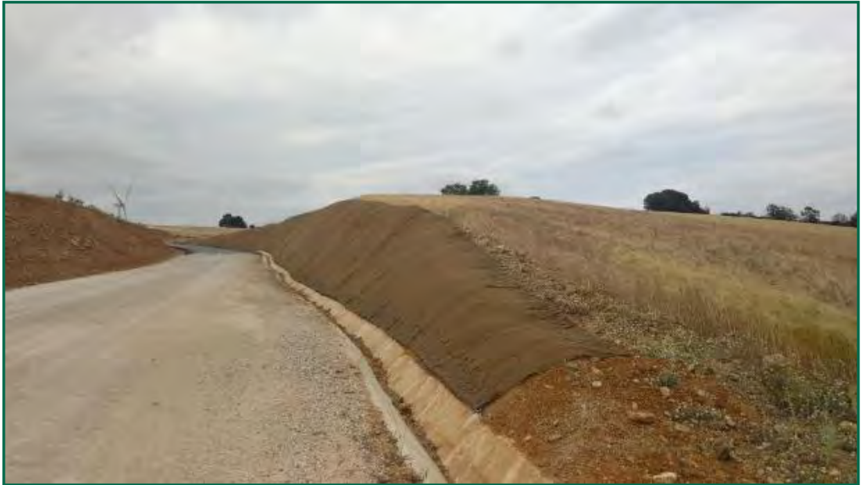
Fotografía 27. Talud cubierto con malla metálica y fibra de coco.
