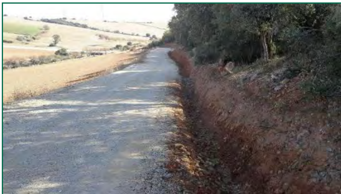
Fotografía 23. Limpieza de las cunetas. (Antes)
