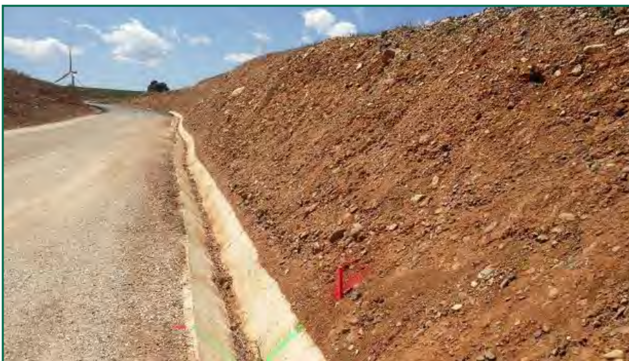
Fotografía 26. Talud en proceso de restauración y protección.
