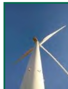
Fotografía 17. Sistemas de detección y disuasión instalados en aerogenerador.
