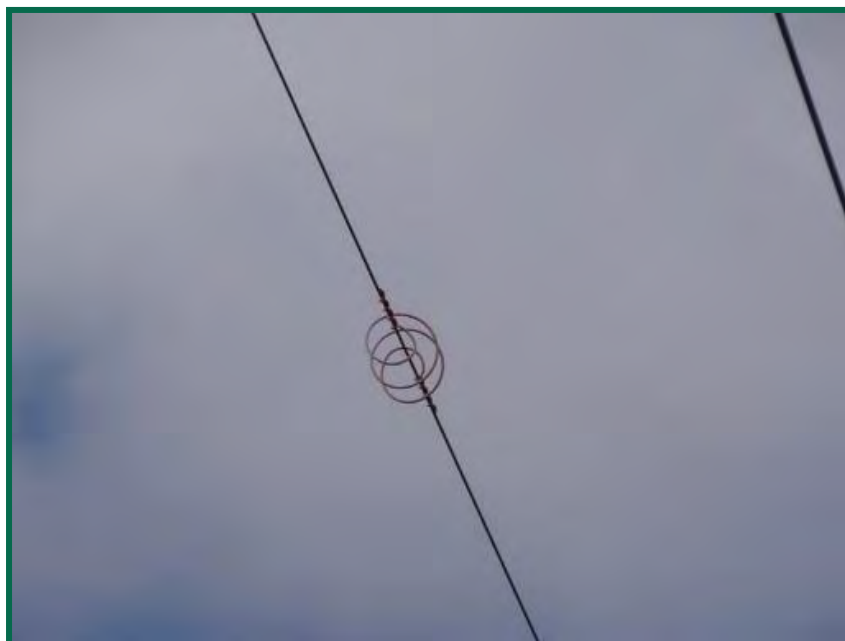
Fotografía 17. Detalle del sistema salvapájaros.
