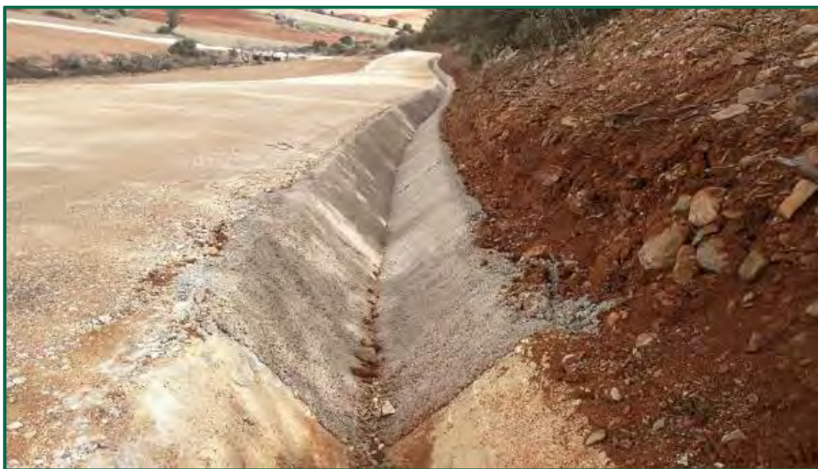
Fotografía 27. Tramo de cuneta hormigonado. (Después)
