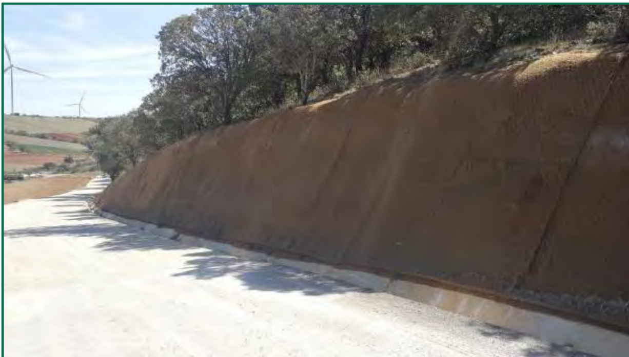
Fotografía 28. Fibra de coco y malla metálica en talud. (Después)
