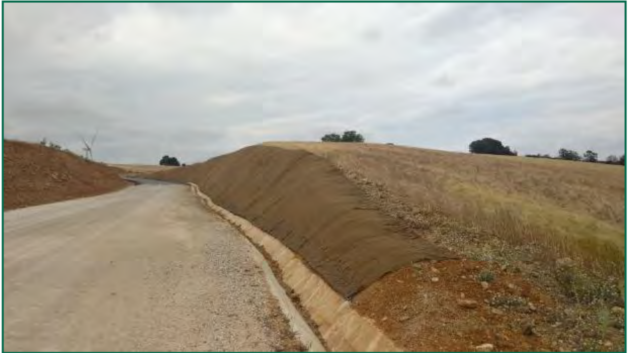
Fotografía 30. Talud cubierto con malla metálica y fibra de coco.
