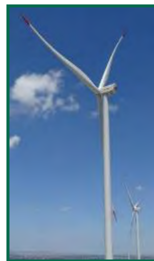
Fotografía 18. Pintado de palas en los aerogeneradores.
