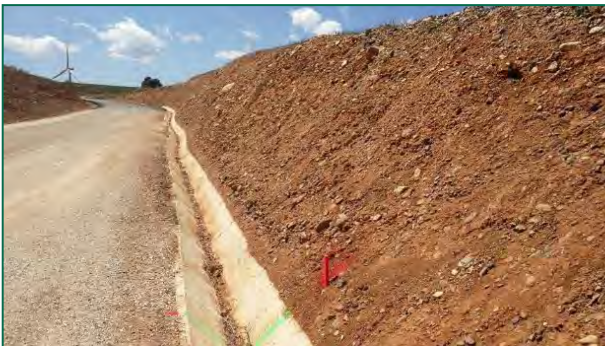
Fotografía 28. Talud en proceso de restauración y protección.
