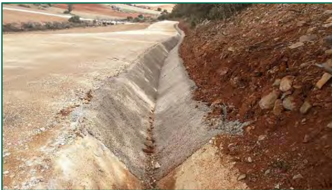
Fotografía 26. Tramo de cuneta hormigonado. (Después)
