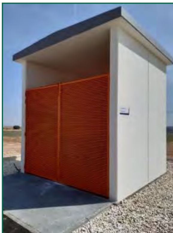
Fotografía 30. Almacén de residuos para gestor autorizado. Fuente: Repsol.
