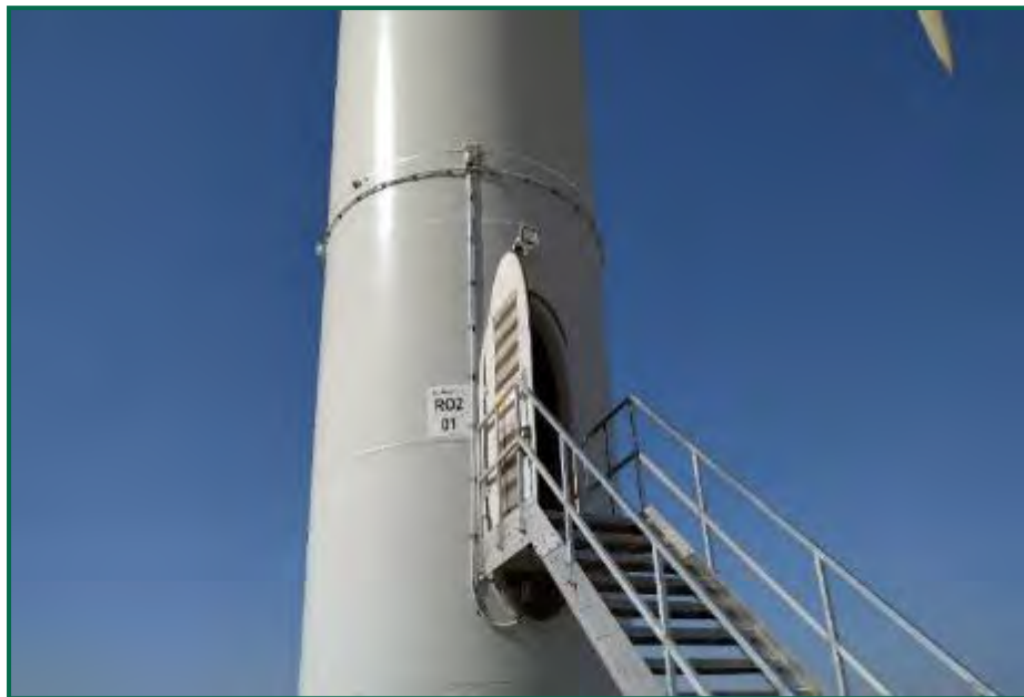
Fotografía 20. Nuevo sistema W4-D10, instalado.
