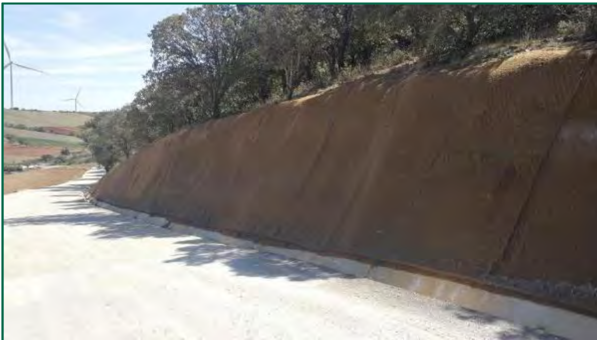
Fotografía 27. Fibra de coco y malla metálica en talud. (Después)
