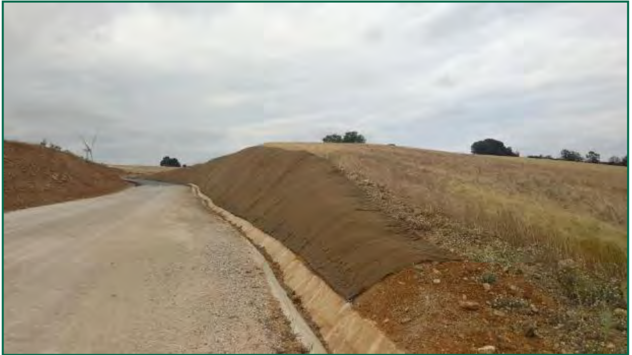
Fotografía 29. Talud cubierto con malla metálica y fibra de coco.
