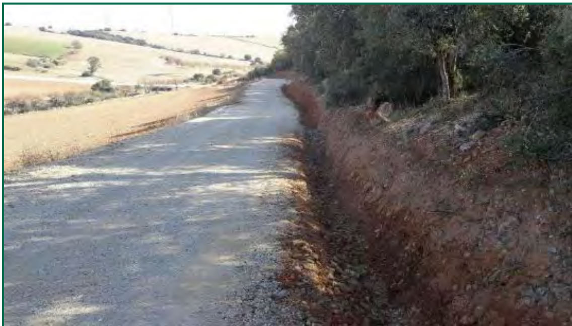
Fotografía 25. Limpieza de las cunetas. (Antes)
