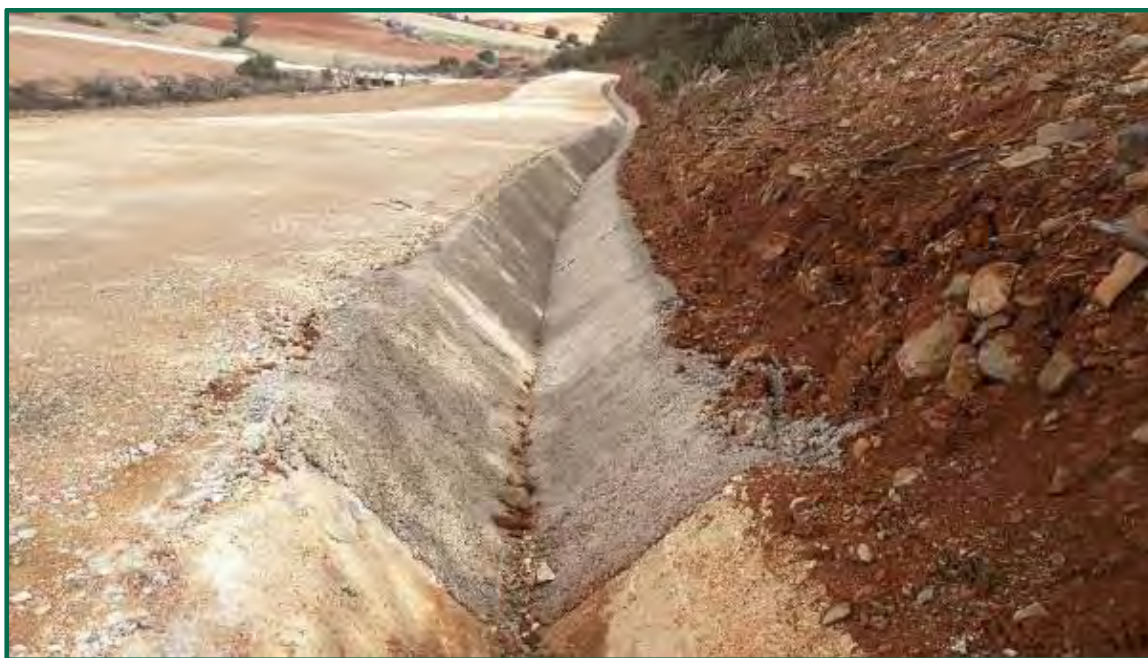
Fotografía 24. Tramo de cuneta hormigonado. (Después)
