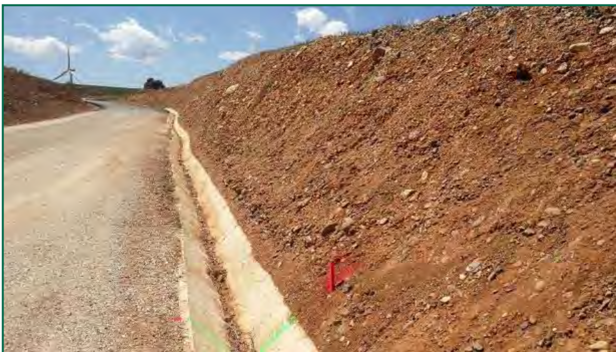
Fotografía 26. Talud en proceso de restauración y protección.
