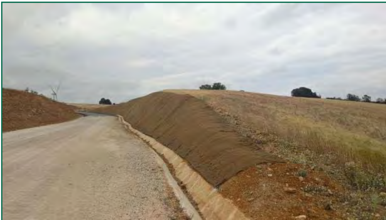
Fotografía 27. Talud cubierto con malla metálica y fibra de coco.
