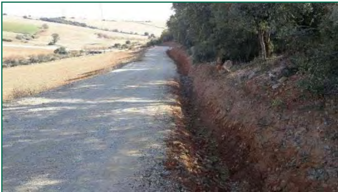
Fotografía 23. Limpieza de las cunetas. (Antes)
