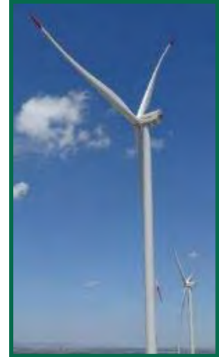
Fotografía 16. Pintado de palas en los aerogeneradores.
