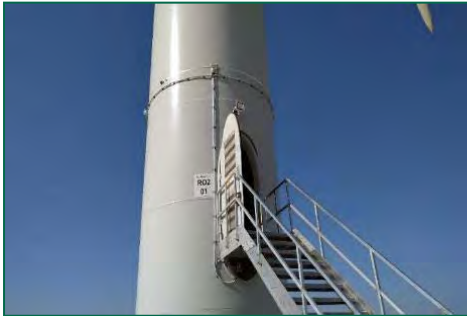
Fotografía 18. Nuevo sistema W4-D10, instalado.
