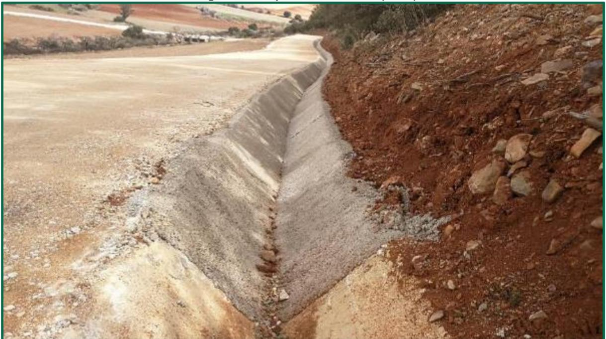
Fotografía 23. Tramo de cuneta hormigonado. (Después)
