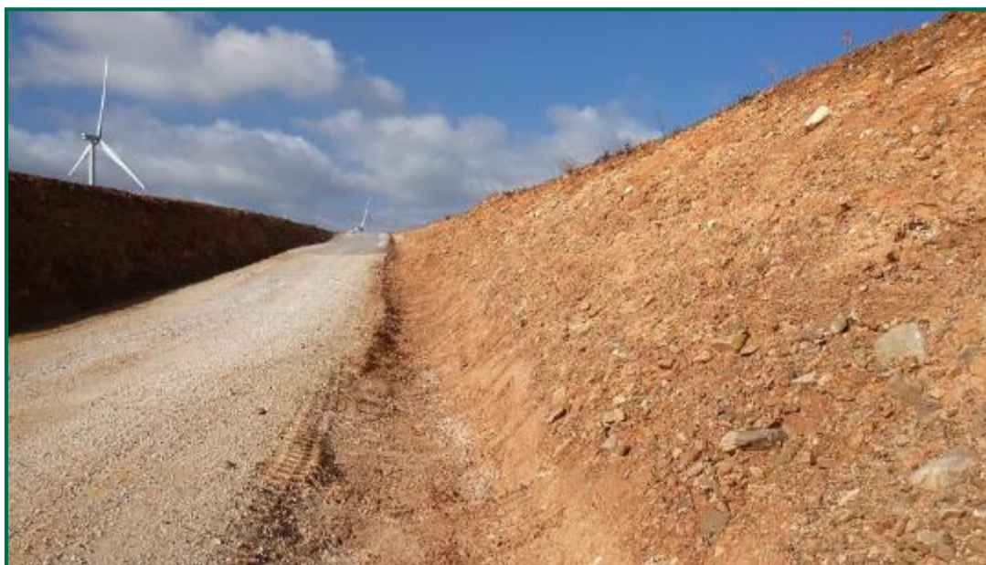
Fotografía 27. Limpieza de las cunetas.
