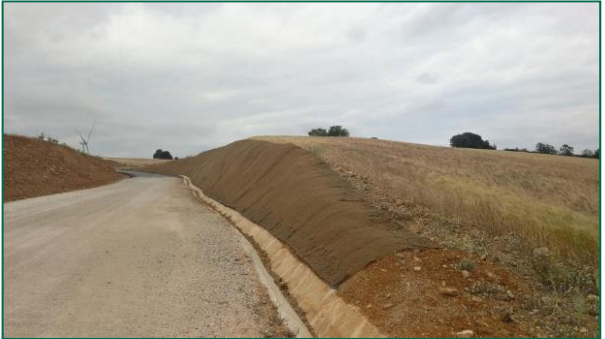
Fotografía 32. Talud cubierto con malla metálica y fibra de coco.
