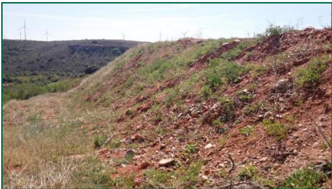
Fotografía 35. Talud en el clúster Aguasvivas.
