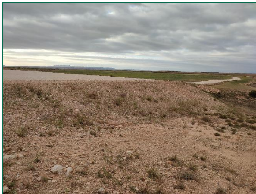
Fotografía 34. Talud en clúster Aguasvivas, aspecto actual.
