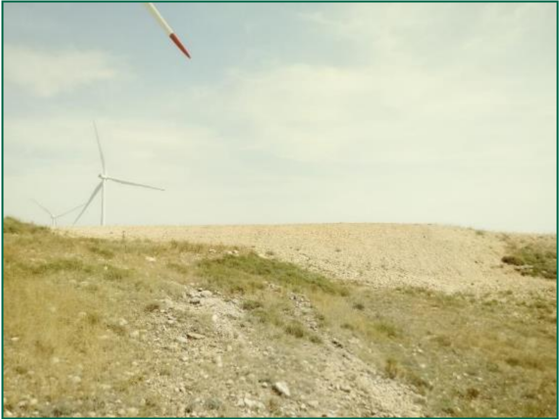
Fotografía 33. Talud en clúster Aguasvivas.
