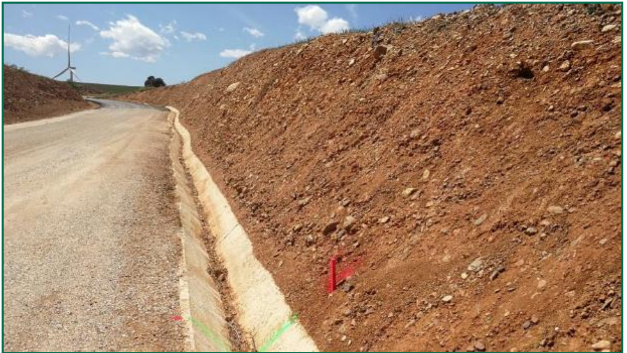
Fotografía 31. Talud en proceso de restauración y protección.
