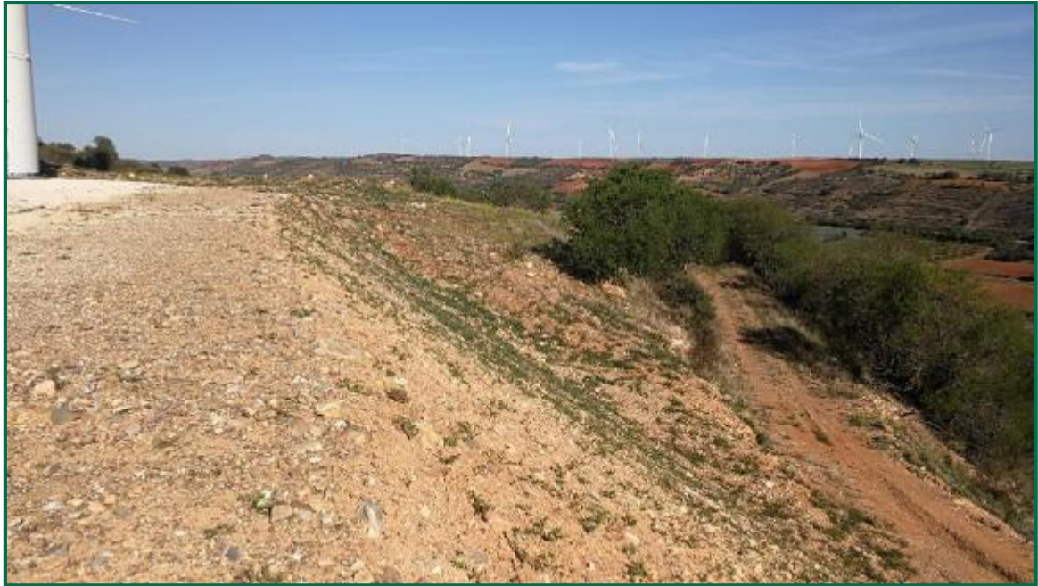
Fotografía 37. Talud en clúster Aguasvivas.
