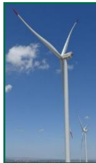
Fotografía 20. Pintado de palas en los aerogeneradores.
