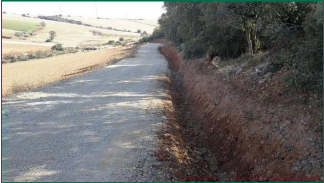
Fotografía 28. Limpieza de las cunetas. (antes)
