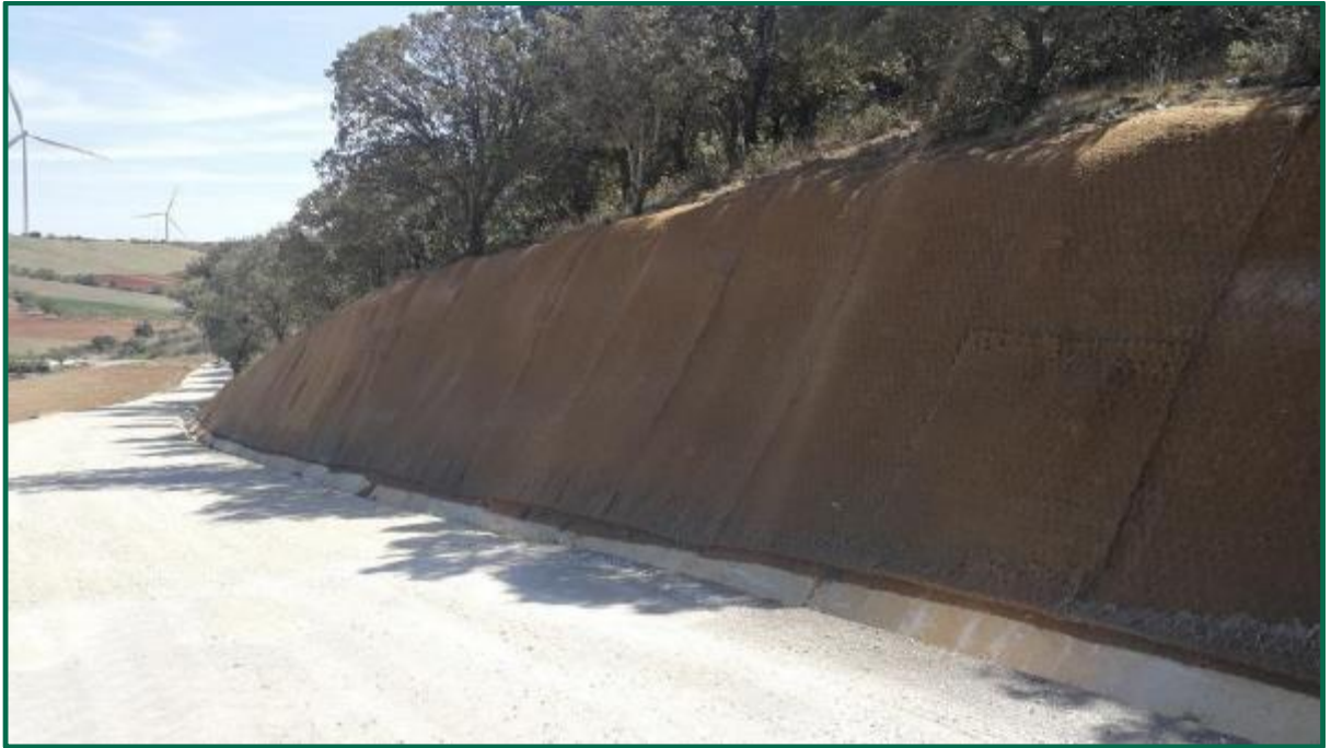
Fotografía 30. Fibra de coco y malla metálica en talud. (después)
