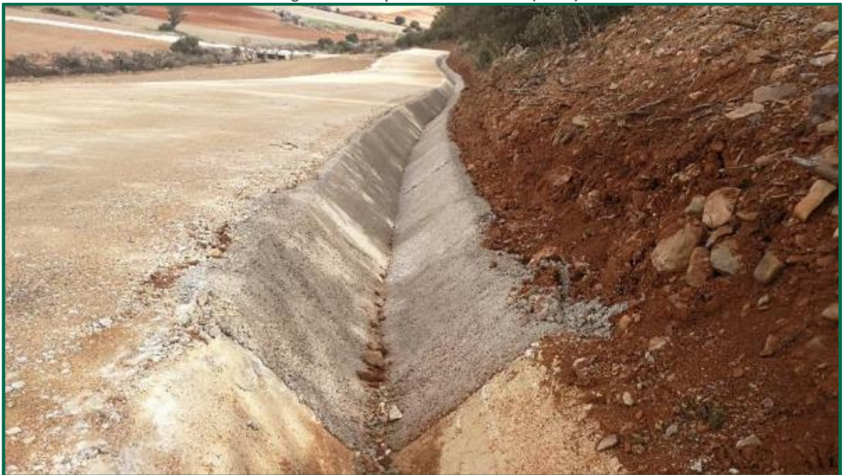
Fotografía 29. Tramo de cuneta hormigonado. (después)
