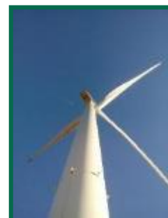
Fotografía 21. Sistemas de detección y disuasión instalado en aerogenerador.
