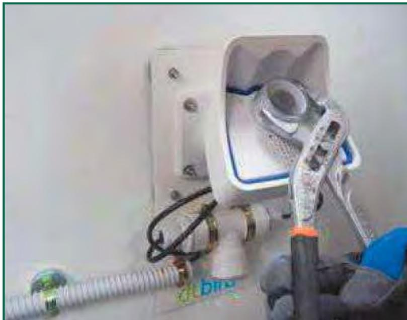
Fotografía 17. Cubrelente acoplado a la nueva cámara.
