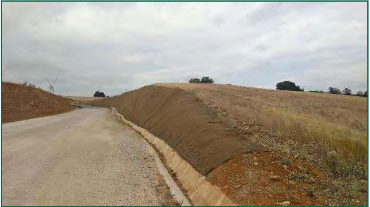
Fotografía 24. Talud cubierto con malla metálica y fibra de coco.
