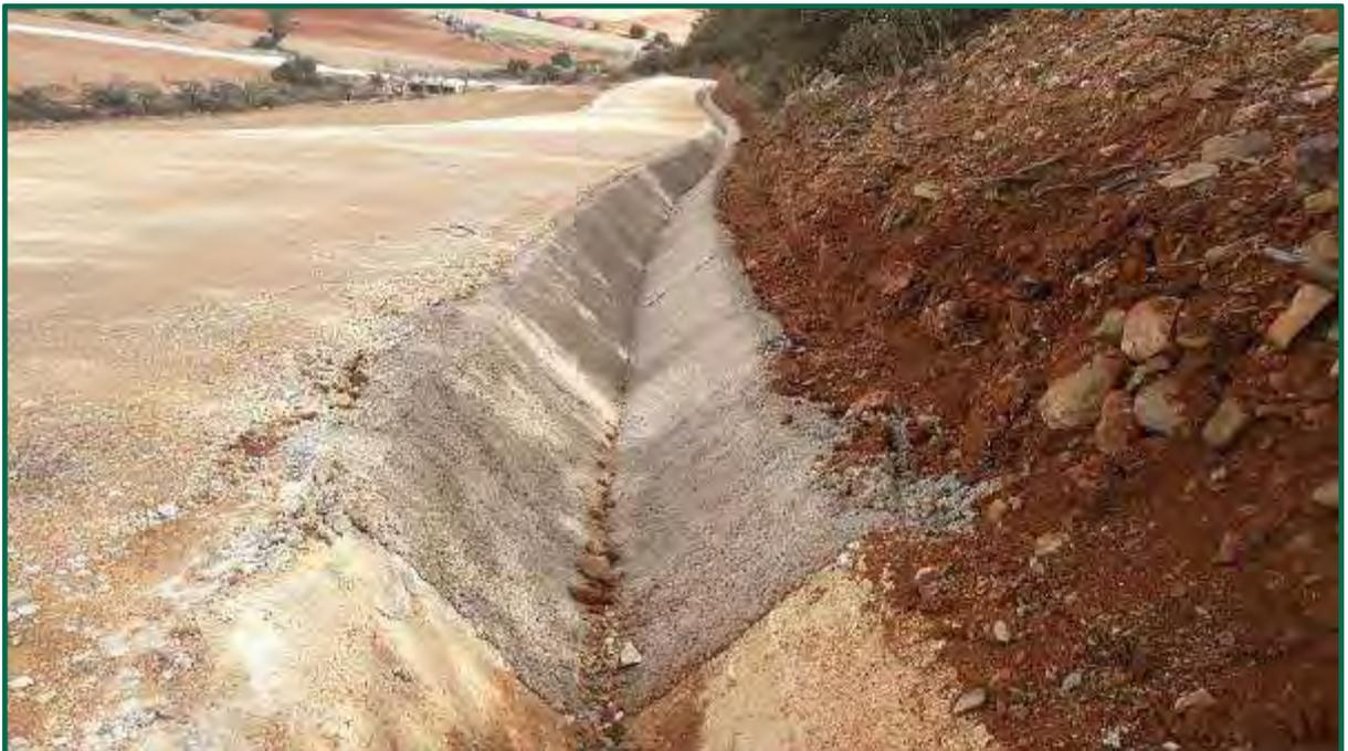
Fotografía 21. Tramo de cuneta hormigonado. (Después)
