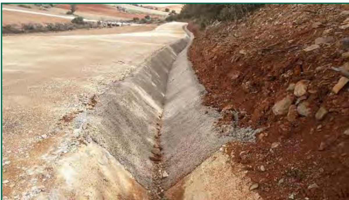
Fotografía 21. Tramo de cuneta hormigonado. (Después)
