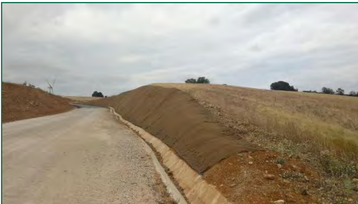
Fotografía 24. Talud cubierto con malla metálica y fibra de coco.
