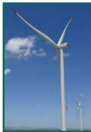
Fotografía 13. Pintado de palas en los aerogeneradores.
