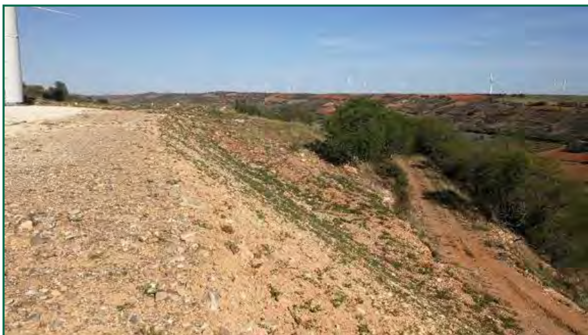
Fotografía 29. Talud en clúster Aguasvivas.
