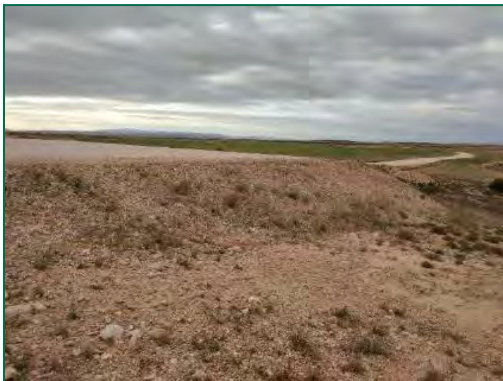
Fotografía 26. Talud en clúster Aguasvivas, aspecto actual.
