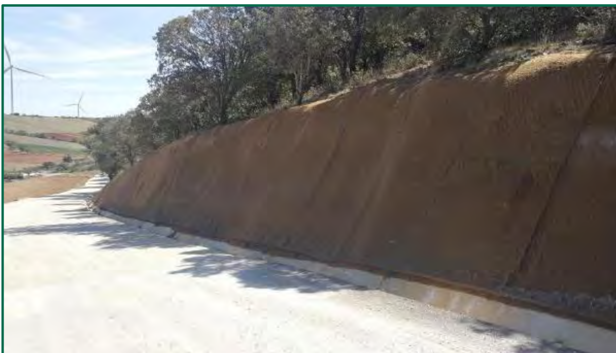
Fotografía 22. Fibra de coco y malla metálica en talud. (Después)
