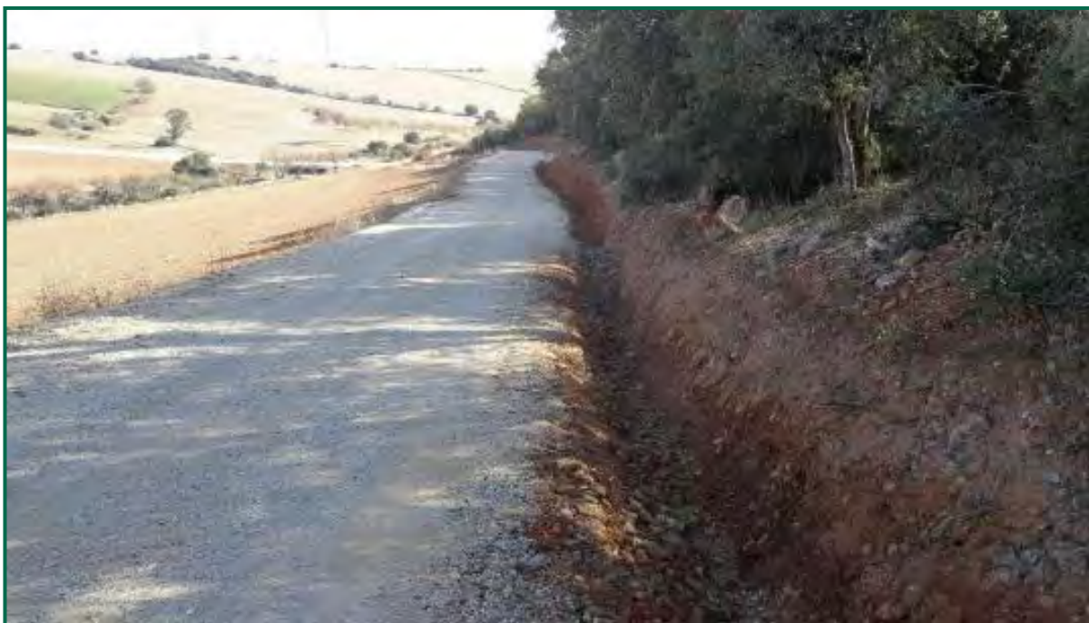
Fotografía 20. Limpieza de las cunetas. (Antes)
