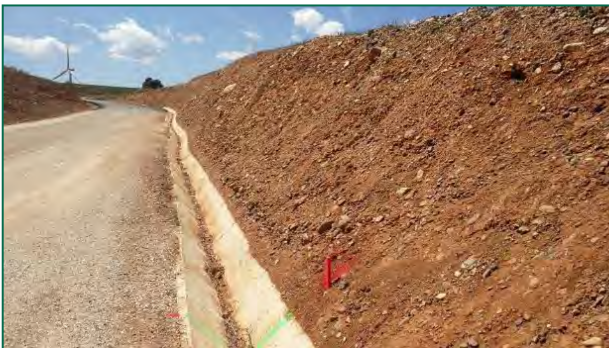
Fotografía 23. Talud en proceso de restauración y protección.
