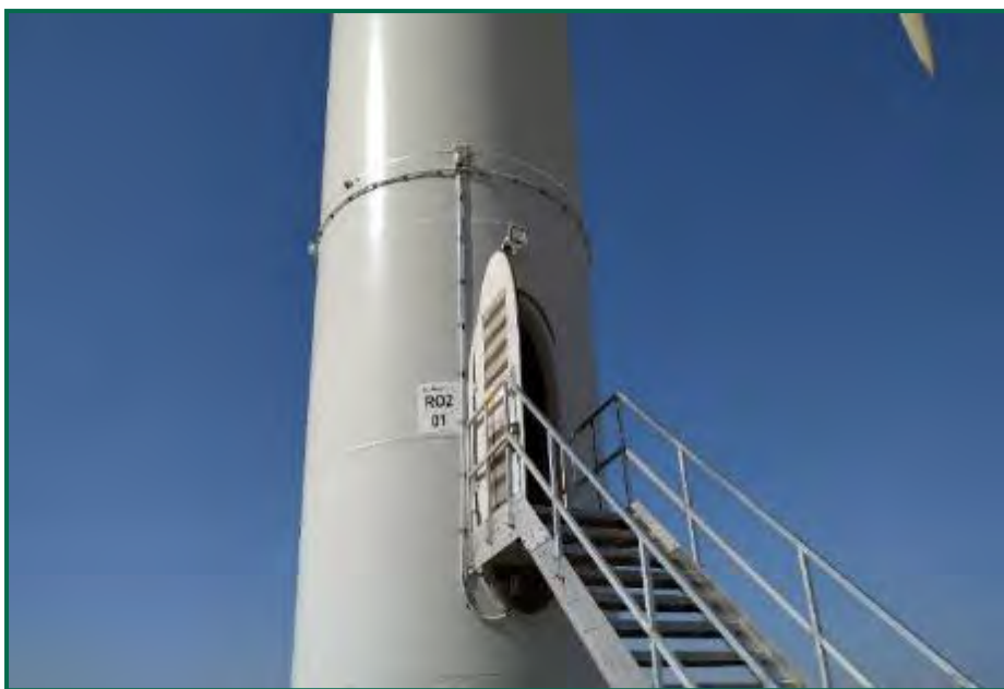
Fotografía 15. Nuevo sistema W4-D10, instalado.
