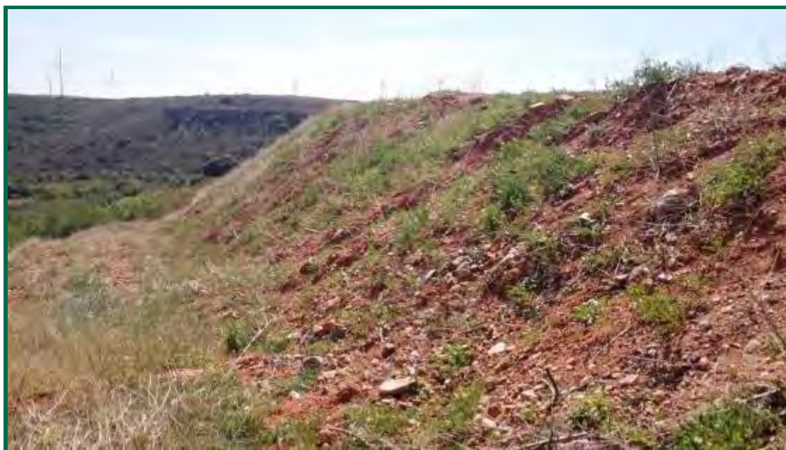
Fotografía 27. Talud en el clúster Aguasvivas.
