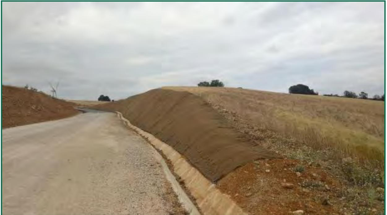
Fotografía 33. Talud cubierto con malla metálica y fibra de coco.
