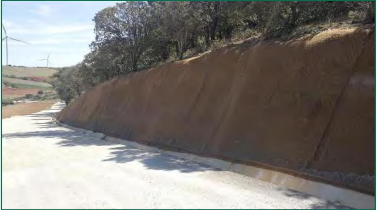
Fotografía 31. Fibra de coco y malla metálica en talud. (Después)
