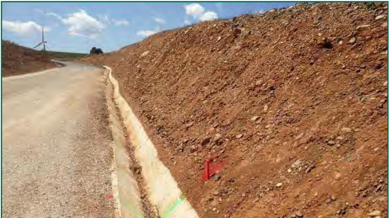
Fotografía 30. Talud en proceso de restauración y protección.
