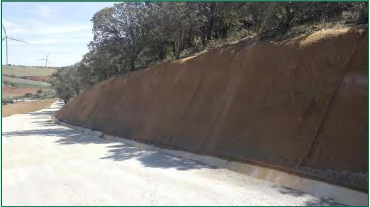
Fotografía 29. Fibra de coco y malla metálica en talud. (Después)
