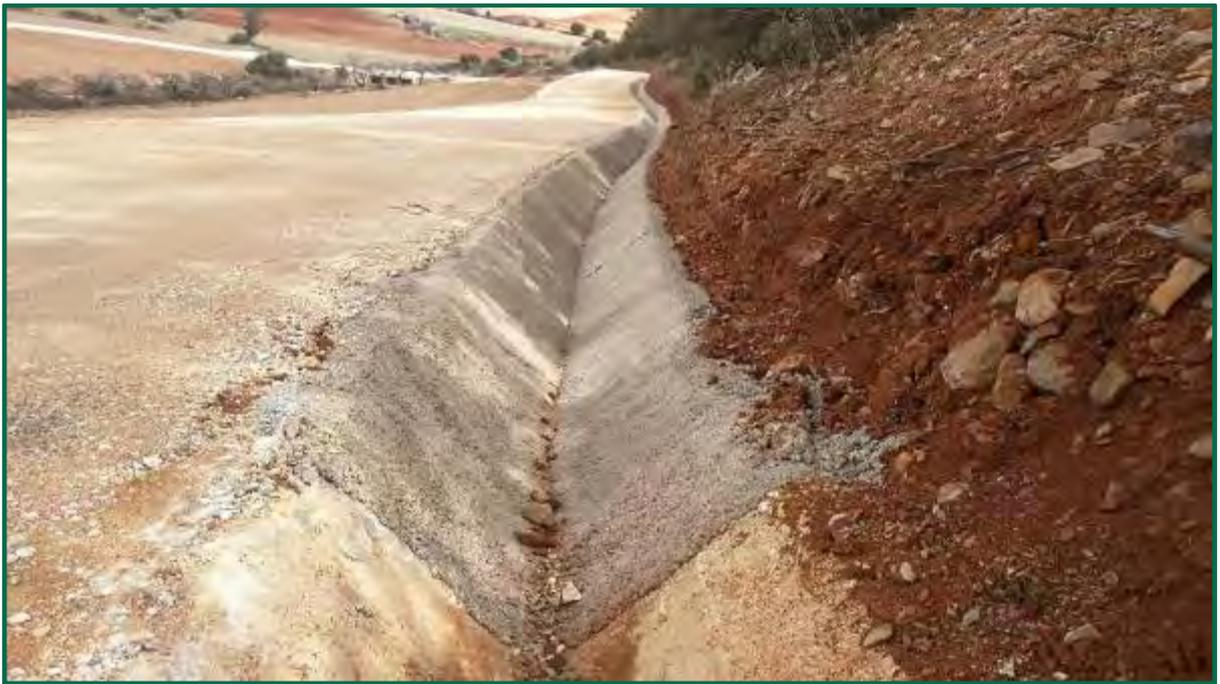
Fotografía 28. Tramo de cuneta hormigonado. (Después)
