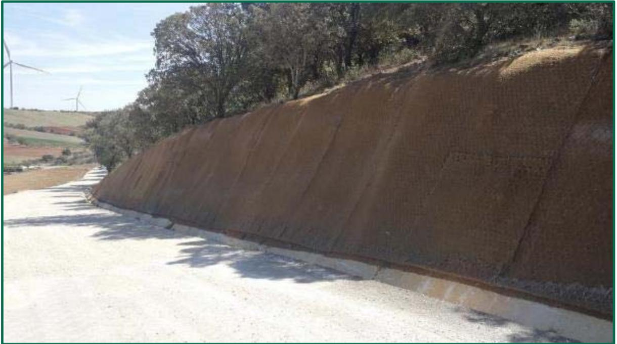
Fotografía 22. Fibra de coco y malla metálica en talud. (Después)
