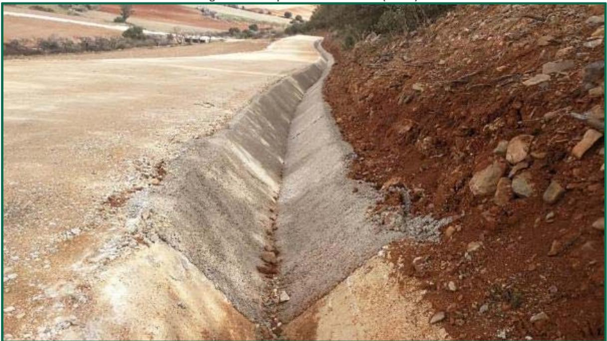
Fotografía 21. Tramo de cuneta hormigonado. (Después)
