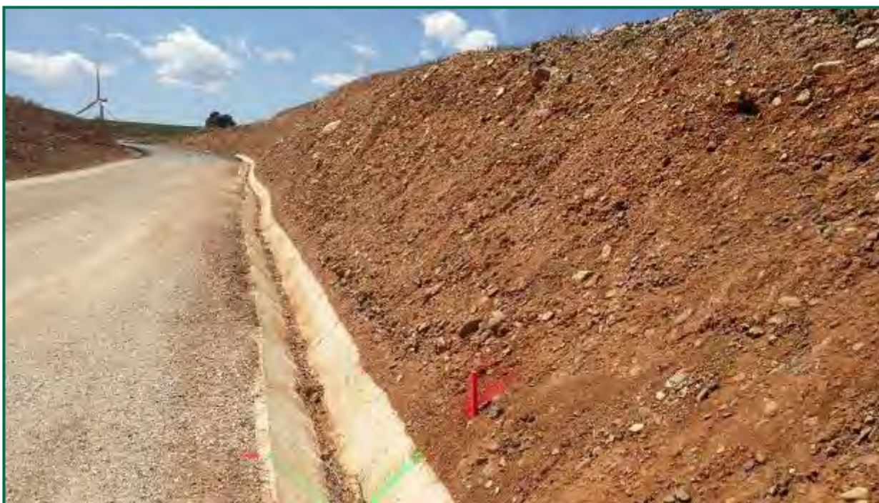
Fotografía 26. Talud en proceso de restauración y protección.
