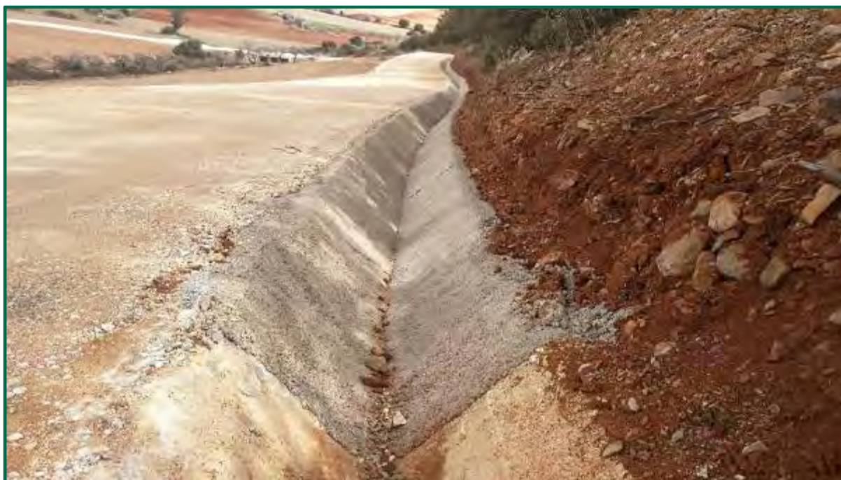
Fotografía 24. Tramo de cuneta hormigonado. (Después)
