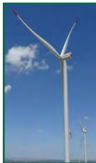
Fotografía 15. Pintado de palas en los aerogeneradores.
