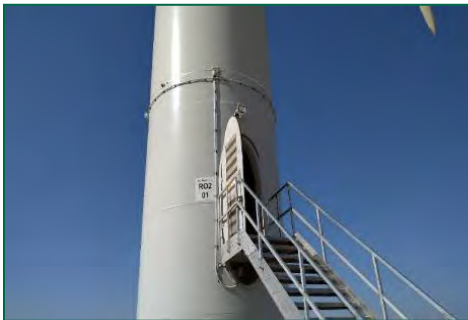
Fotografía 17. Nuevo sistema W4-D10, instalado.
