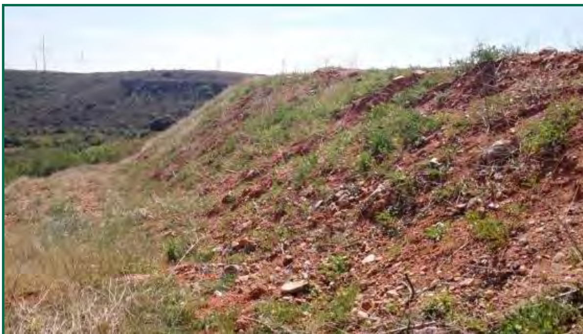
Fotografía 30. Talud en el clúster Aguasvivas.
