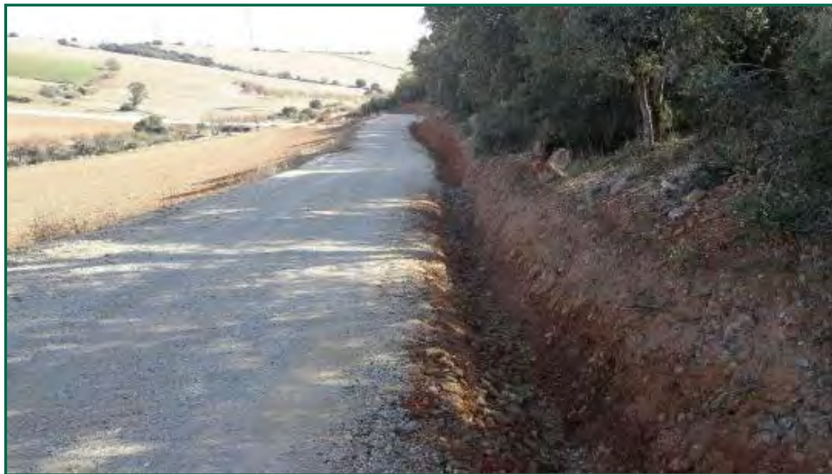
Fotografía 23. Limpieza de las cunetas. (Antes)
