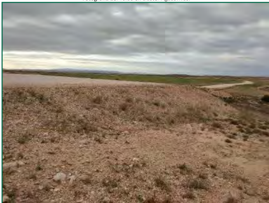
Fotografía 29. Talud en clúster Aguasvivas, aspecto actual.
