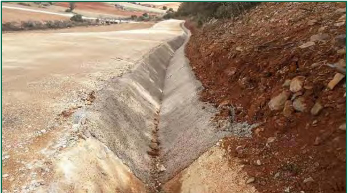
Fotografía 25. Tramo de cuneta hormigonado. (Después)
