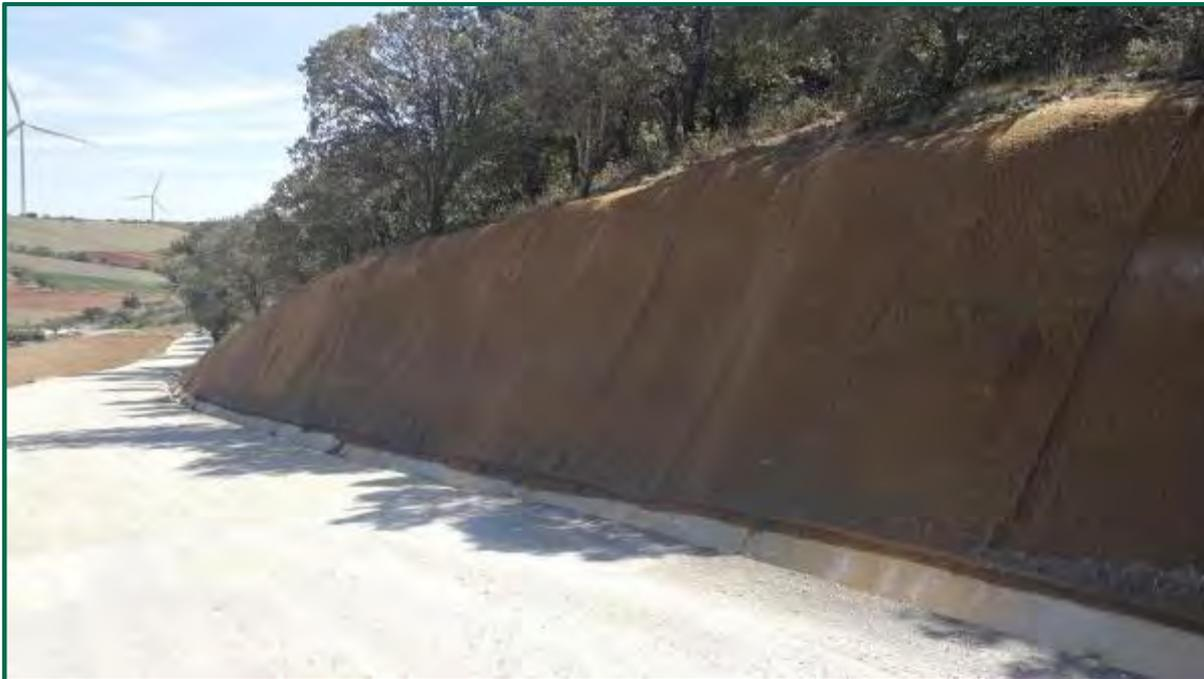
Fotografía 26. Fibra de coco y malla metálica en talud. (Después)
