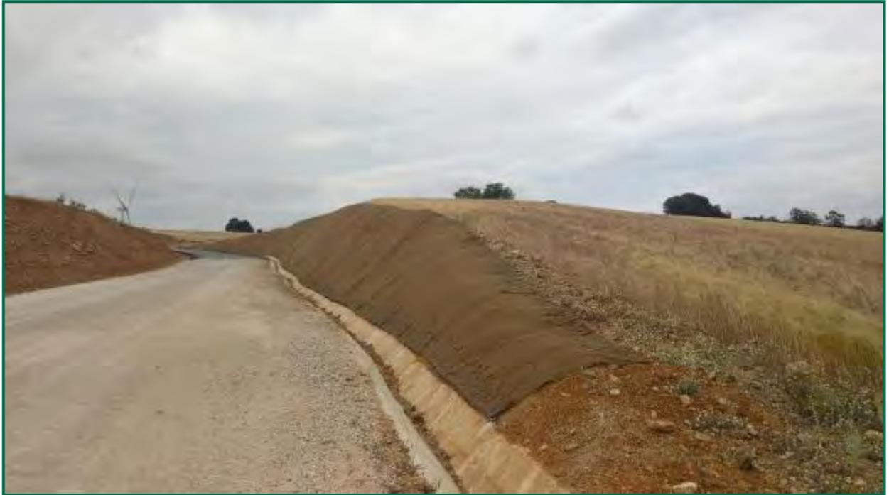
Fotografía 28. Talud cubierto con malla metálica y fibra de coco.
