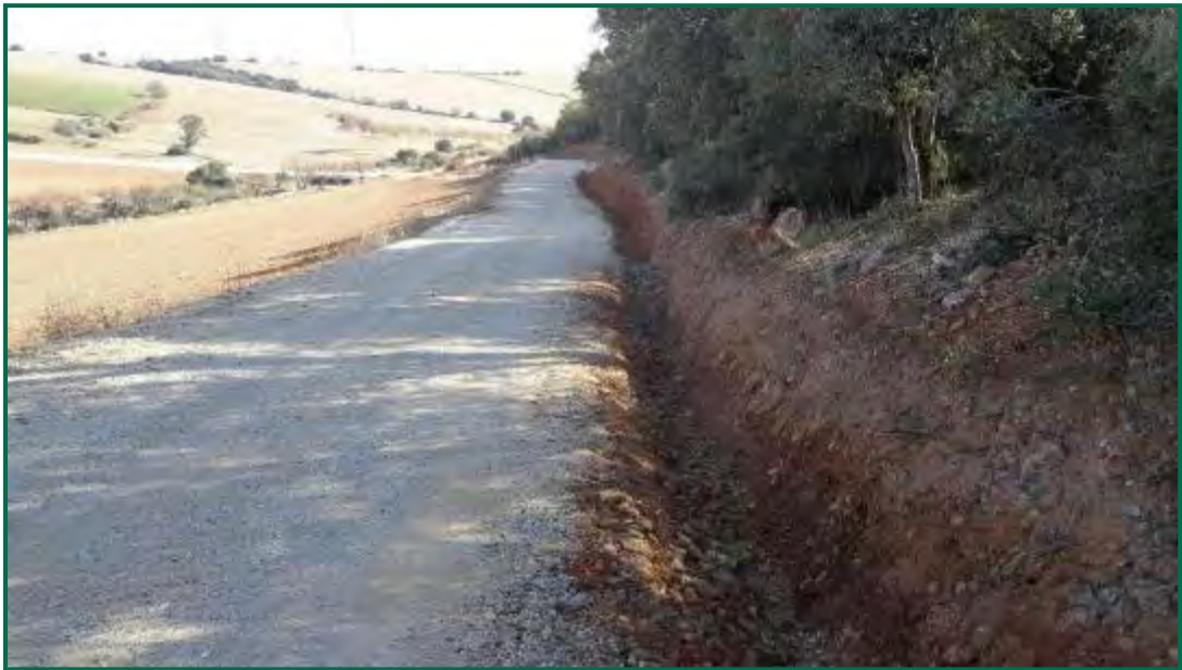
Fotografía 23. Limpieza de las cunetas. (Antes)
