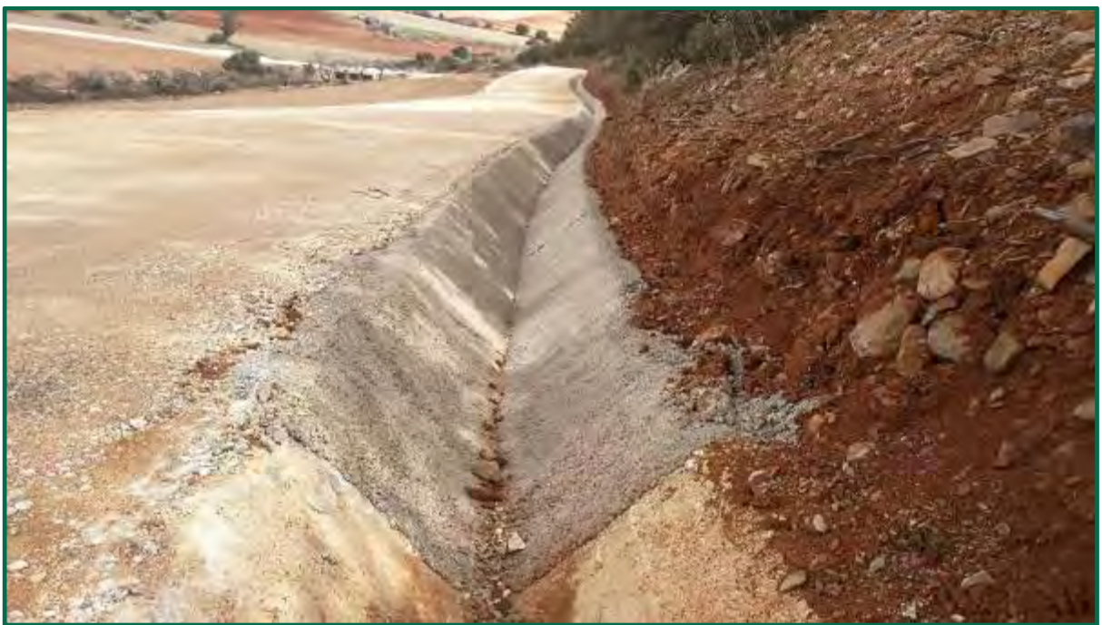
Fotografía 24. Tramo de cuneta hormigonado. (Después)
