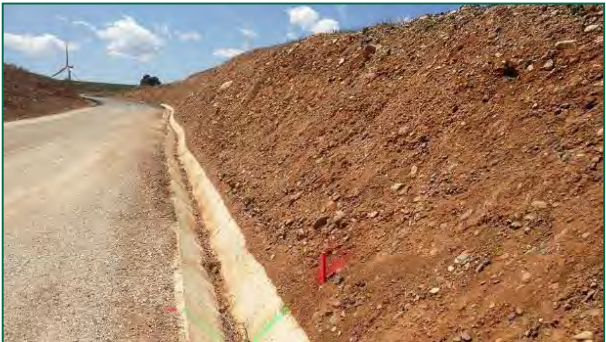
Fotografía 26. Talud en proceso de restauración y protección.
