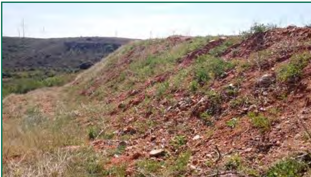
Fotografía 30. Talud en el clúster Aguasvivas.
