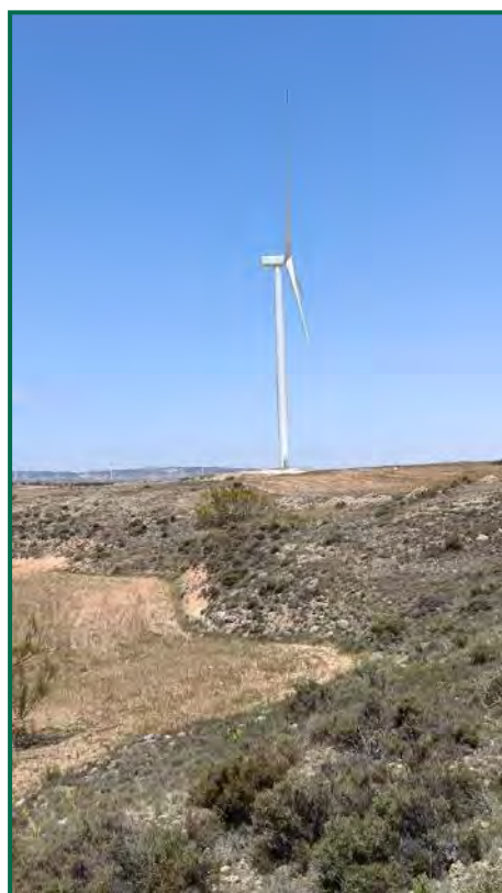
Fotografía 28. Talud en clúster Aguasvivas.
