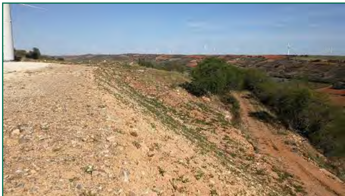
Fotografía 32. Talud en clúster Aguasvivas.
