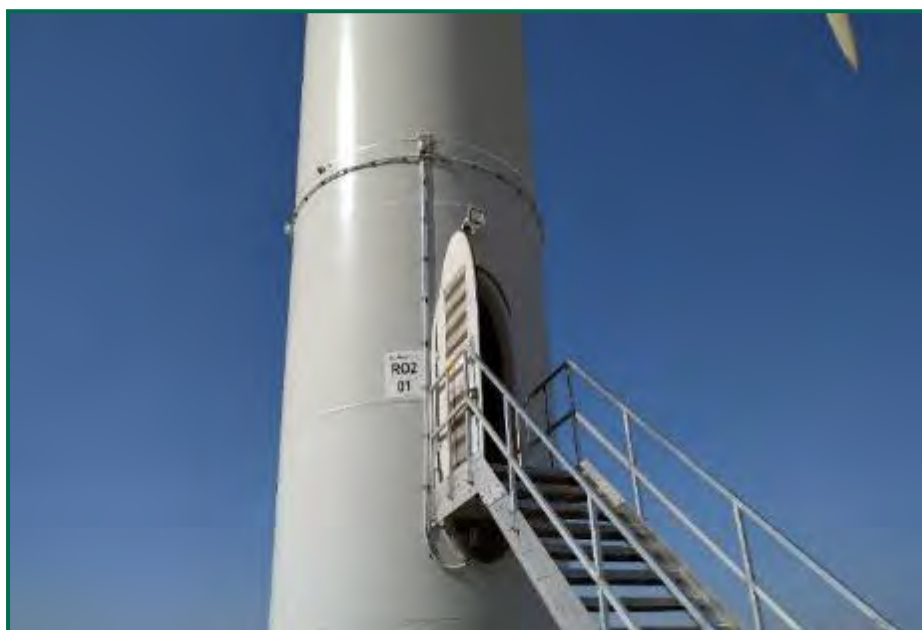
Fotografía 17. Nuevo sistema W4-D10, instalado.
