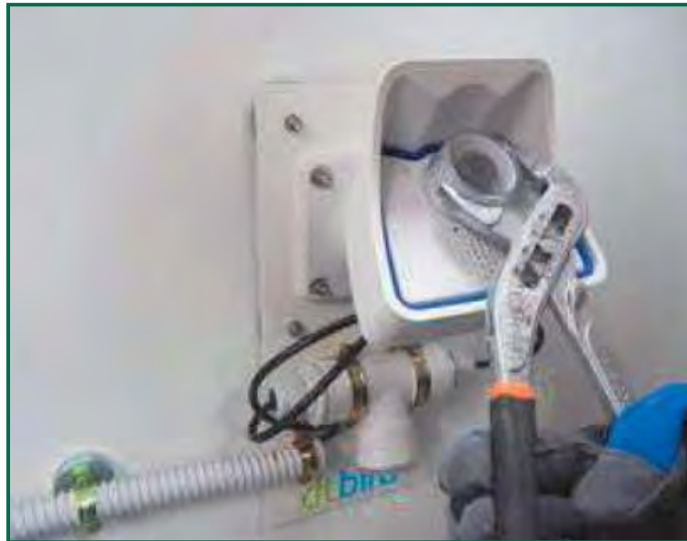
Fotografía 19. Cubrelente acoplado a la nueva cámara.
