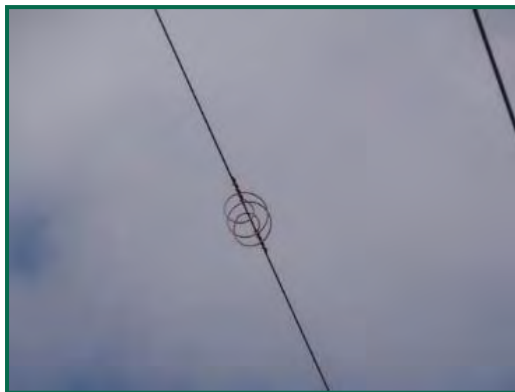
Fotografía 14. Detalle del sistema salvapájaros.
