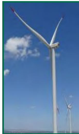
Fotografía 15. Pintado de palas en los aerogeneradores.
