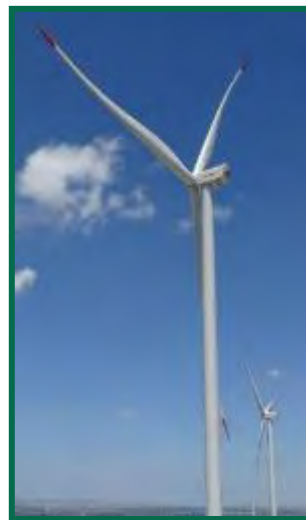
Fotografía 15. Pintado de palas en los aerogeneradores.
