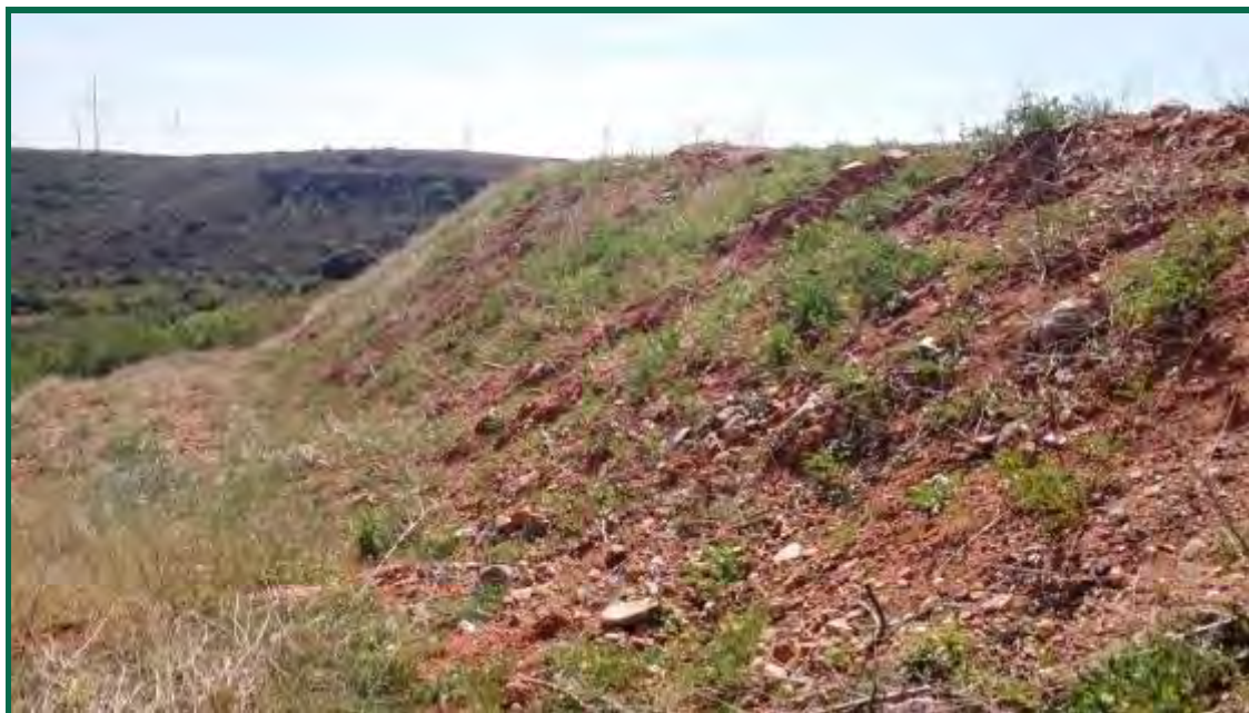
Fotografía 30. Talud en el clúster Aguasvivas.
