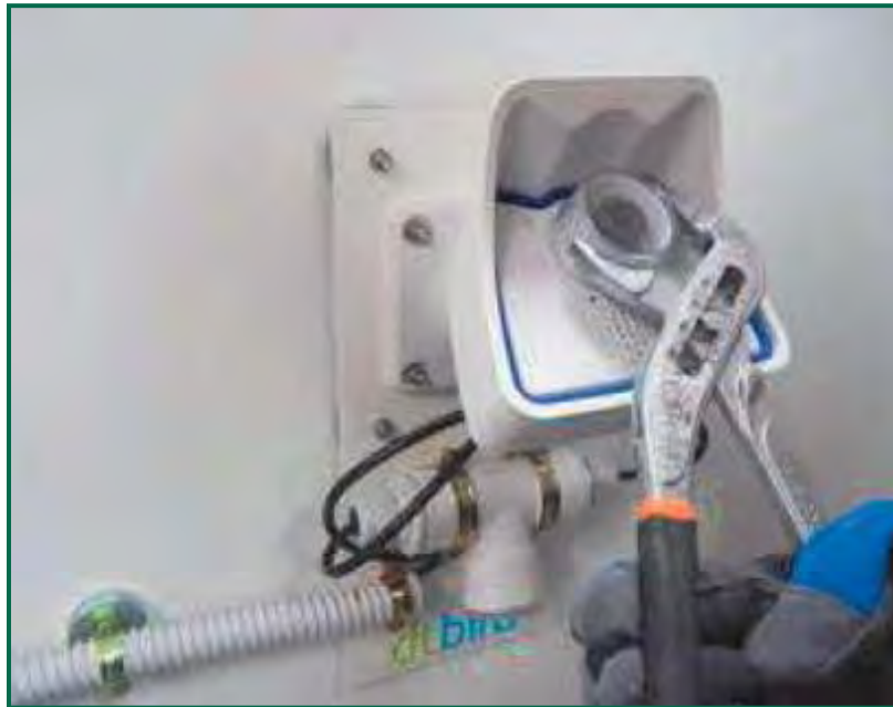
Fotografía 19. Cubrelente acoplado a la nueva cámara.
