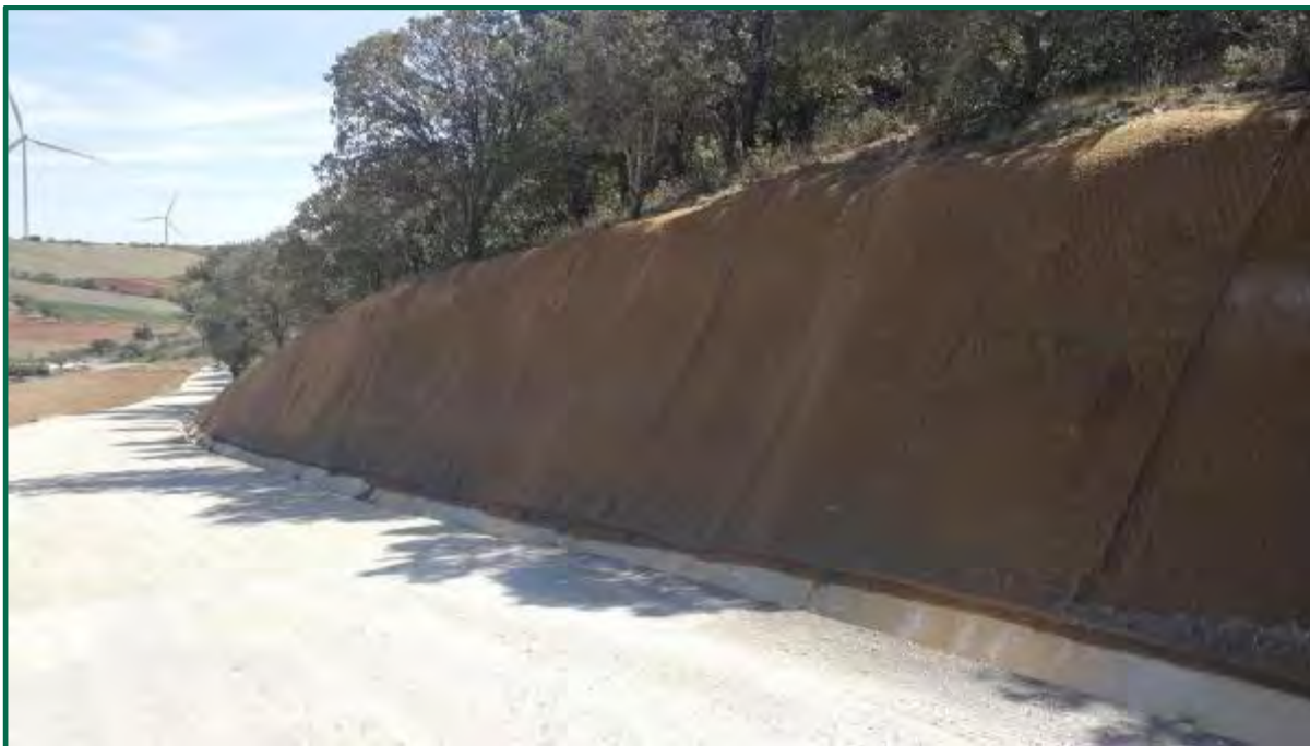
Fotografía 25. Fibra de coco y malla metálica en talud. (Después)
