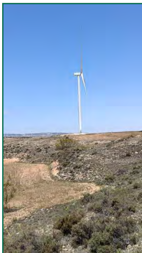
Fotografía 28. Talud en clúster Aguasvivas.
