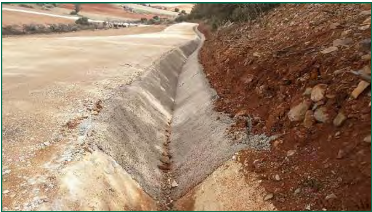
Fotografía 24. Tramo de cuneta hormigonado. (Después)
