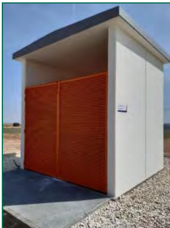
Fotografía 37. Almacén de residuos para gestor autorizado. Fuente: Repsol.
