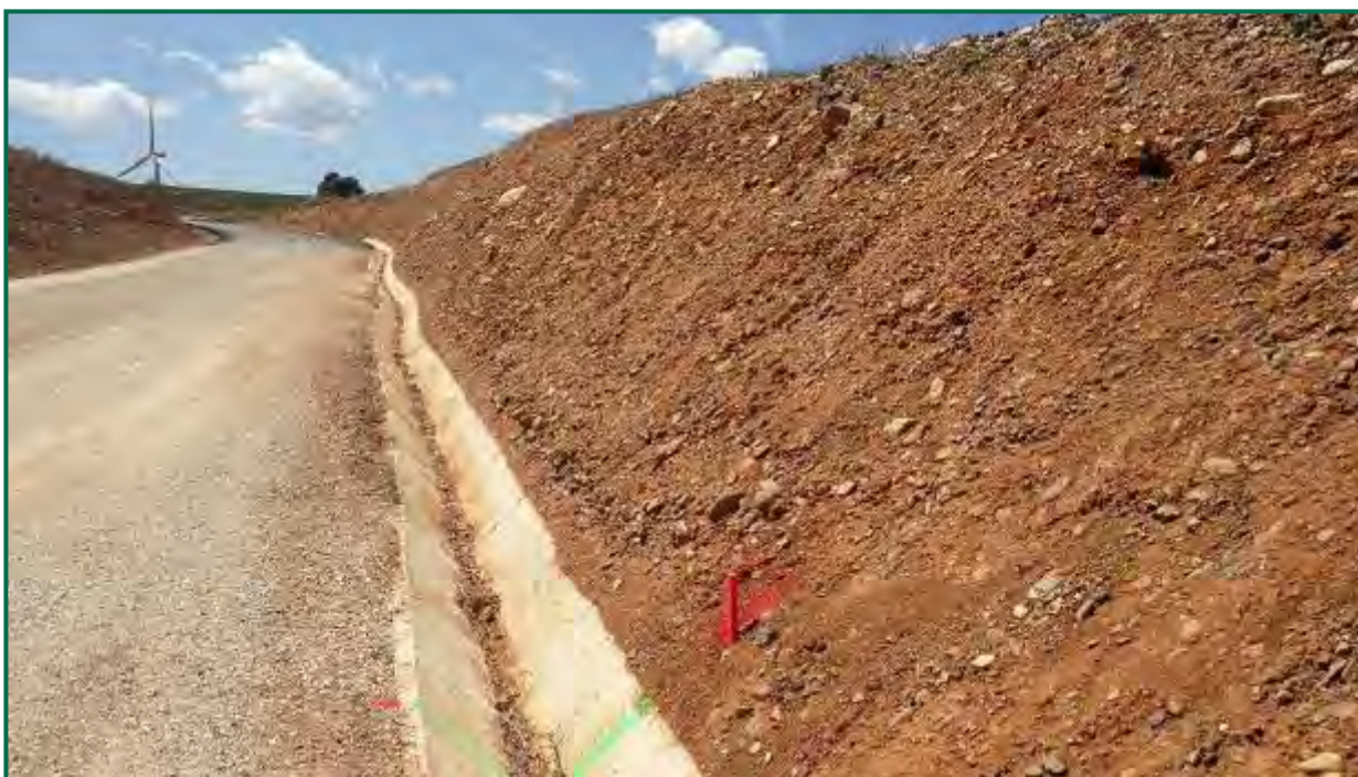
Fotografía 26. Talud en proceso de restauración y protección.
