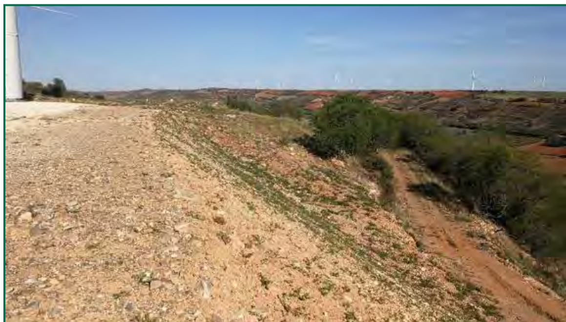
Fotografía 32. Talud en clúster Aguasvivas.
