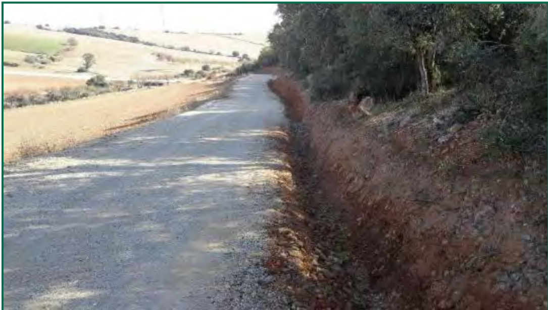
Fotografía 23. Limpieza de las cunetas. (Antes)
