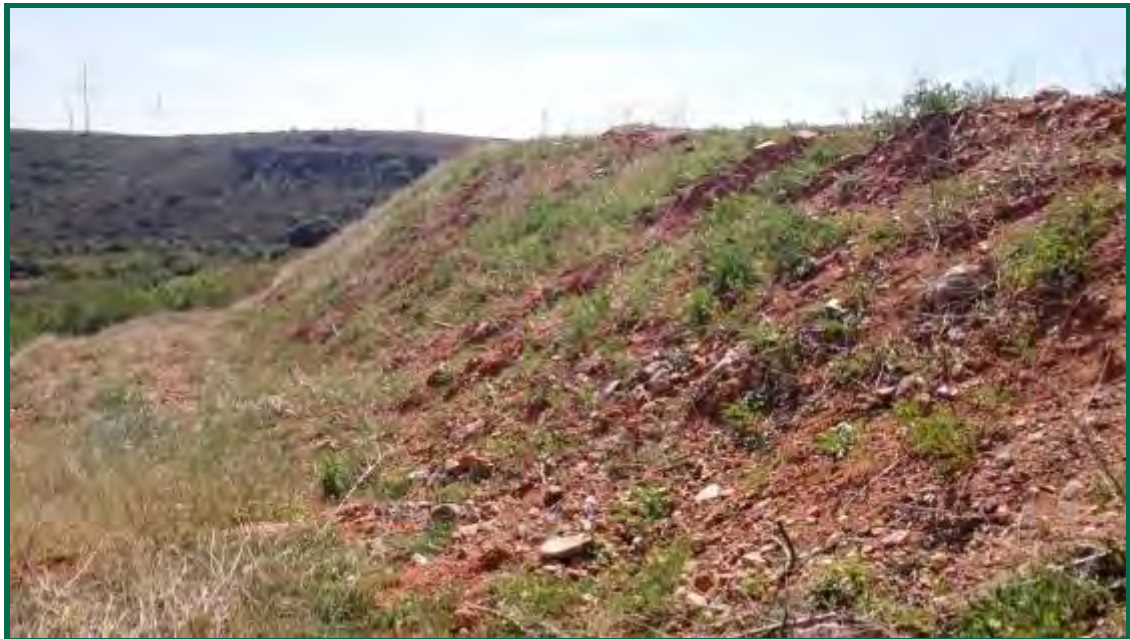
Fotografía 29. Talud en el clúster Aguasvivas.
