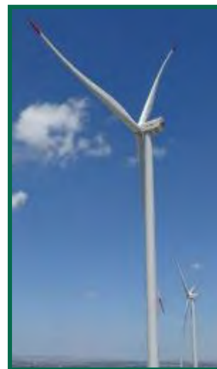
Fotografía 15. Pintado de palas en los aerogeneradores.
