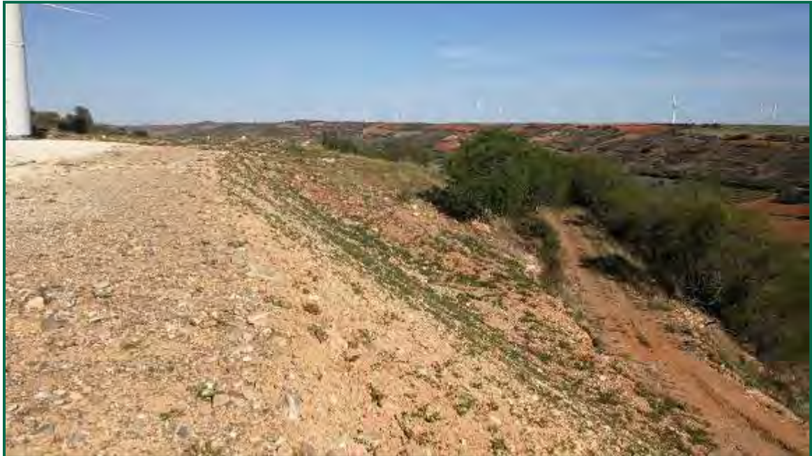
Fotografía 31. Talud en clúster Aguasvivas.
