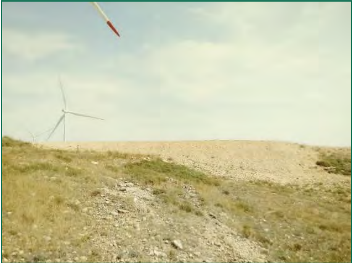
Fotografía 27. Talud en clúster Aguasvivas.
