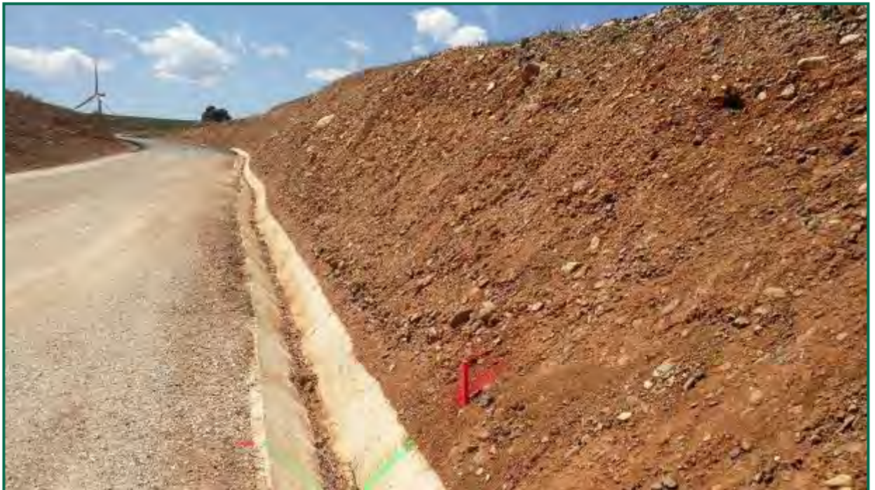
Fotografía 25. Talud en proceso de restauración y protección.
