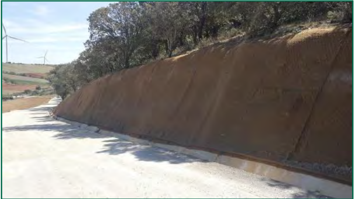
Fotografía 24. Fibra de coco y malla metálica en talud. (Después)
