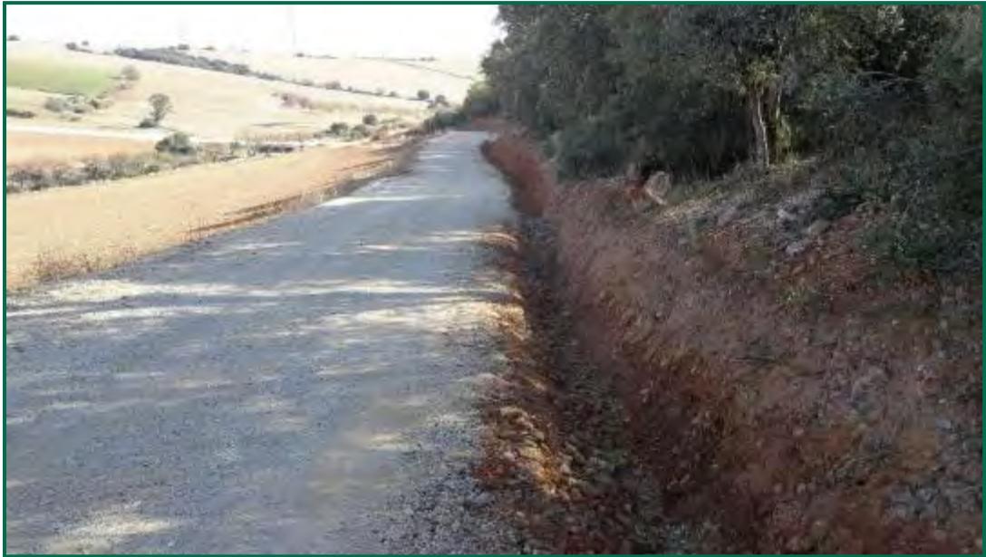
Fotografía 22. Limpieza de las cunetas. (Antes)
