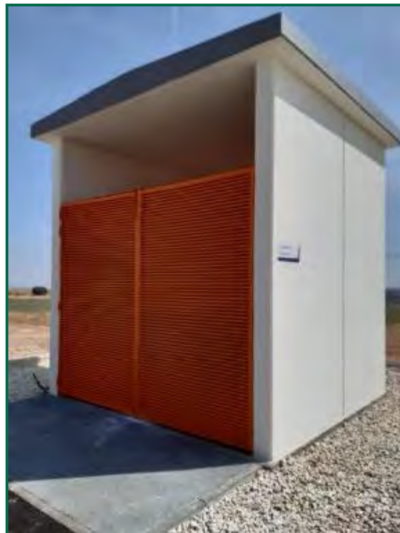
Fotografía 36. Almacén de residuos para gestor autorizado. Fuente: Repsol.
