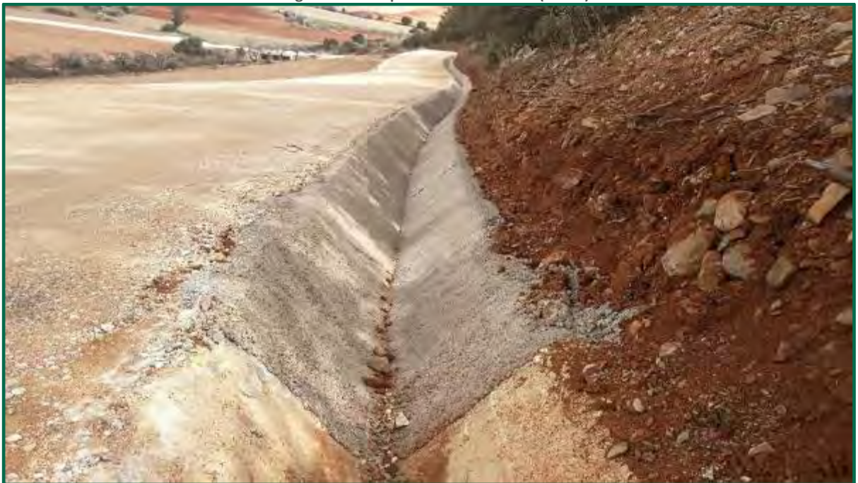
Fotografía 23. Tramo de cuneta hormigonado. (Después)
