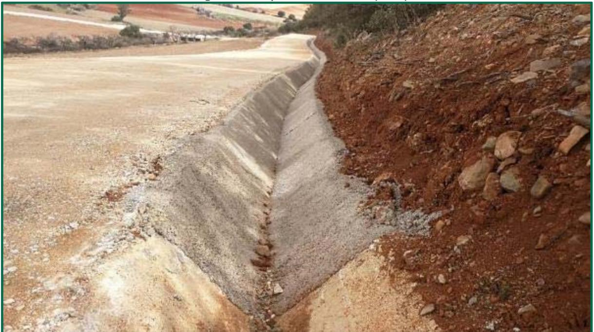
Fotografía 27. Tramo de cuneta hormigonado. (después)
