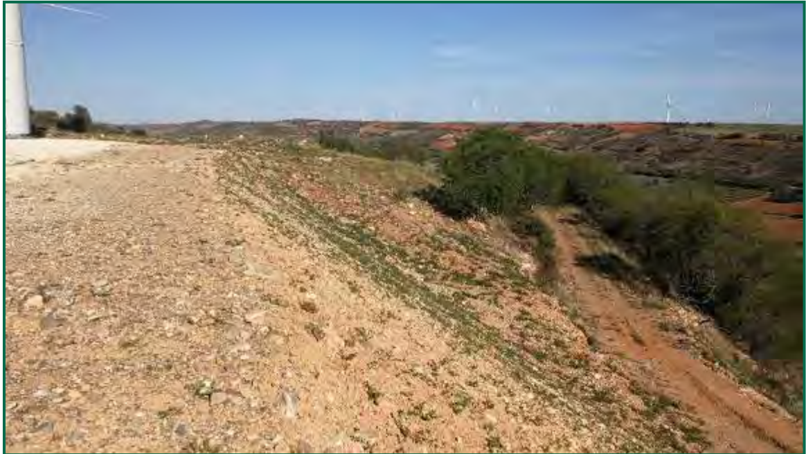
Fotografía 31. Talud en clúster Aguasvivas.
