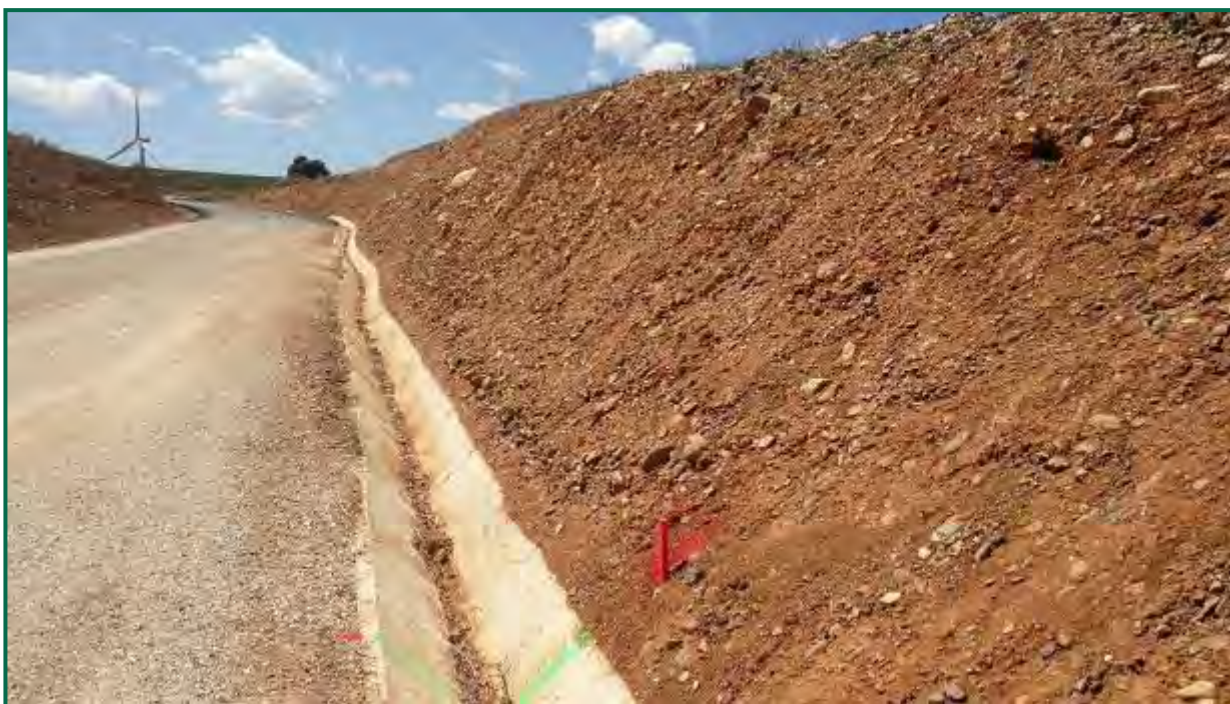
Fotografía 25. Talud en proceso de restauración y protección.
