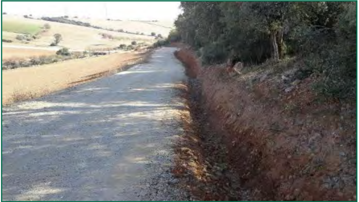
Fotografía 22. Limpieza de las cunetas. (Antes)
