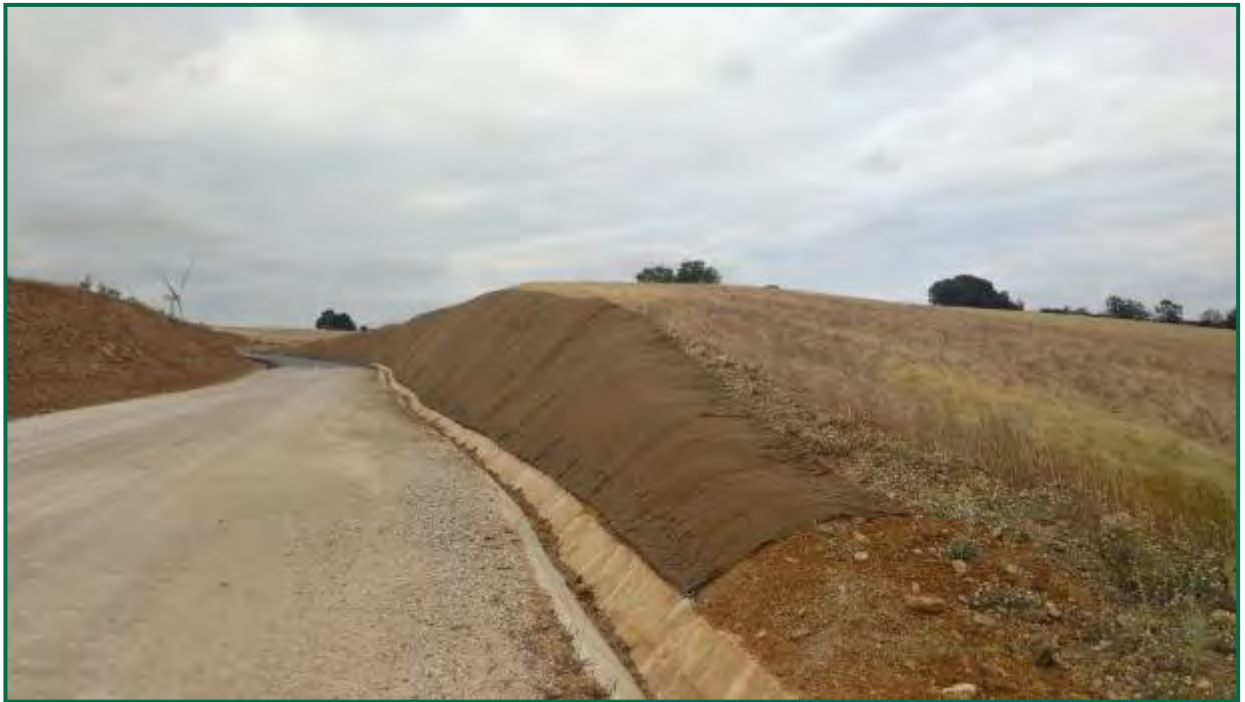
Fotografía 26. Talud cubierto con malla metálica y fibra de coco.
