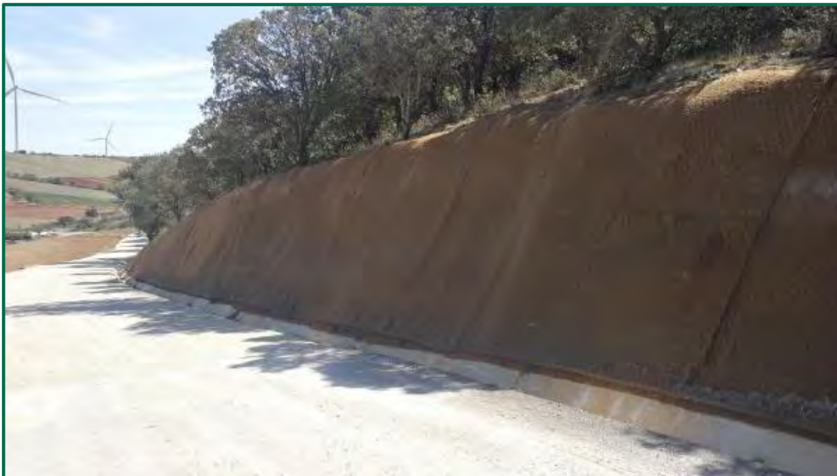
Fotografía 24. Fibra de coco y malla metálica en talud. (Después)
