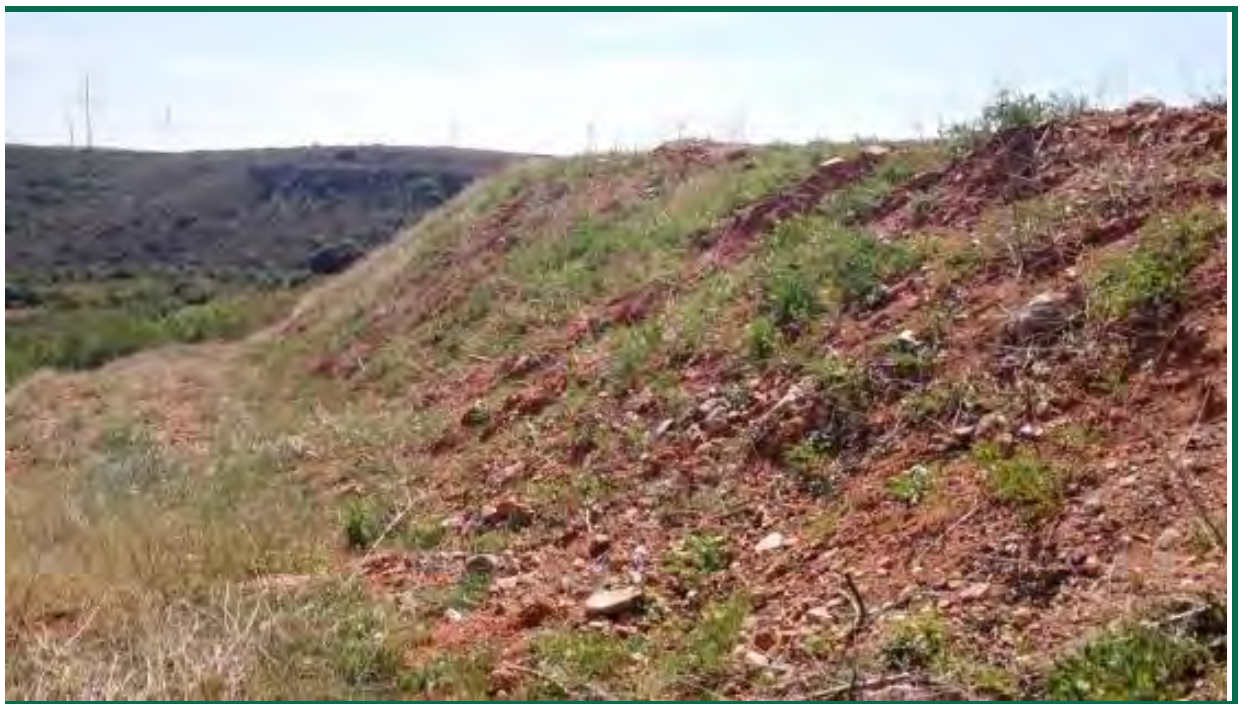
Fotografía 29. Talud en el clúster Aguasvivas.
