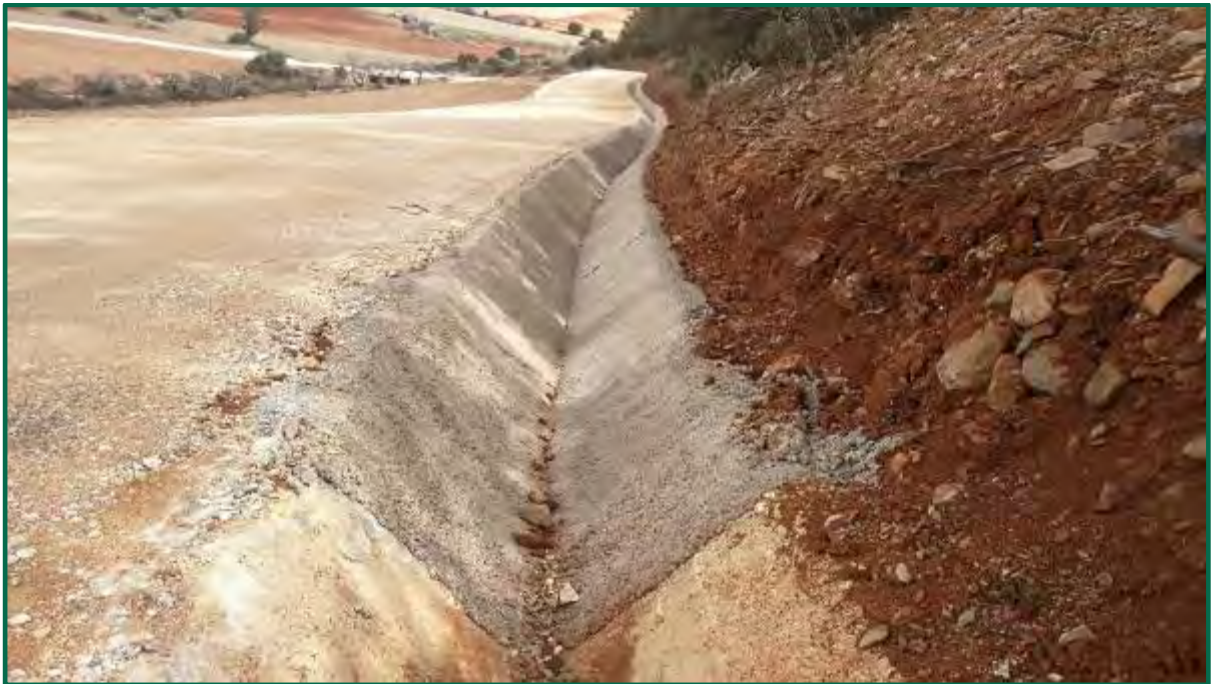
Fotografía 23. Tramo de cuneta hormigonado. (Después)
