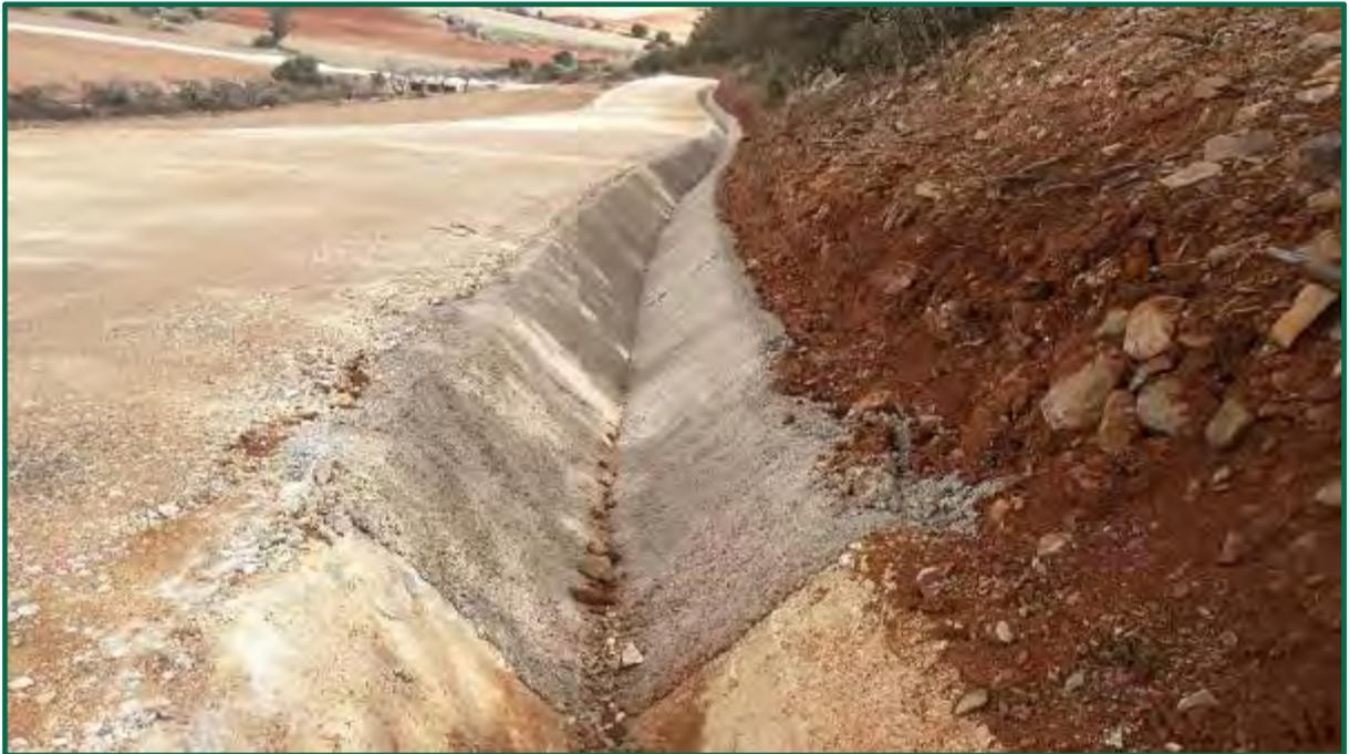
Fotografía 23. Tramo de cuneta hormigonado. (Después)
