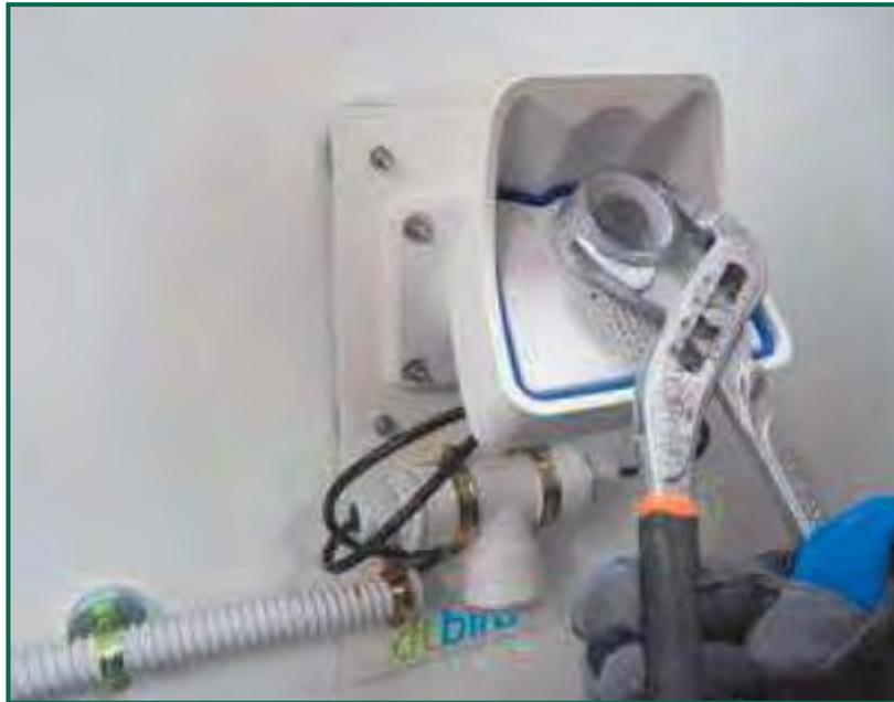
Fotografía 19. Cubre lente acoplado a la nueva cámara.
