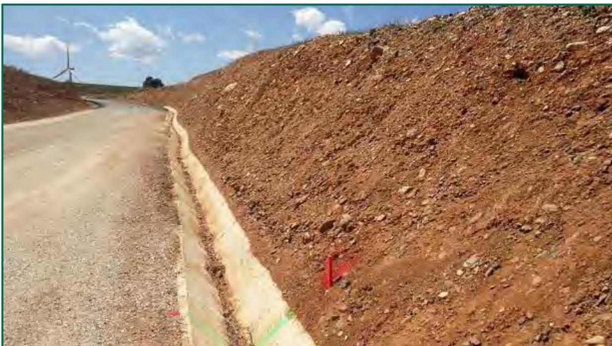
Fotografía 25. Talud en proceso de restauración y protección.
