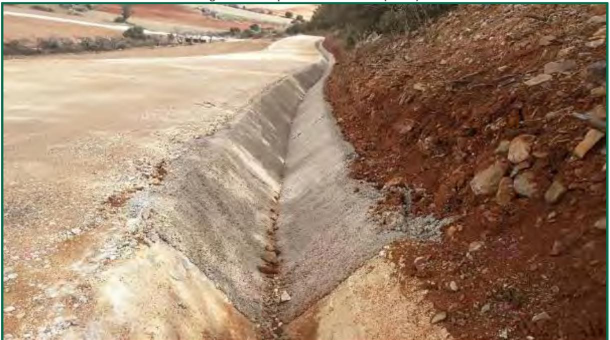
Fotografía 23. Tramo de cuneta hormigonado. (Después)
