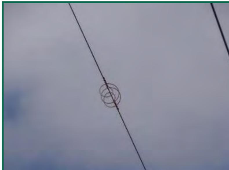
Fotografía 14. Detalle del sistema anti pájaros de la LAAT de evacuación.
