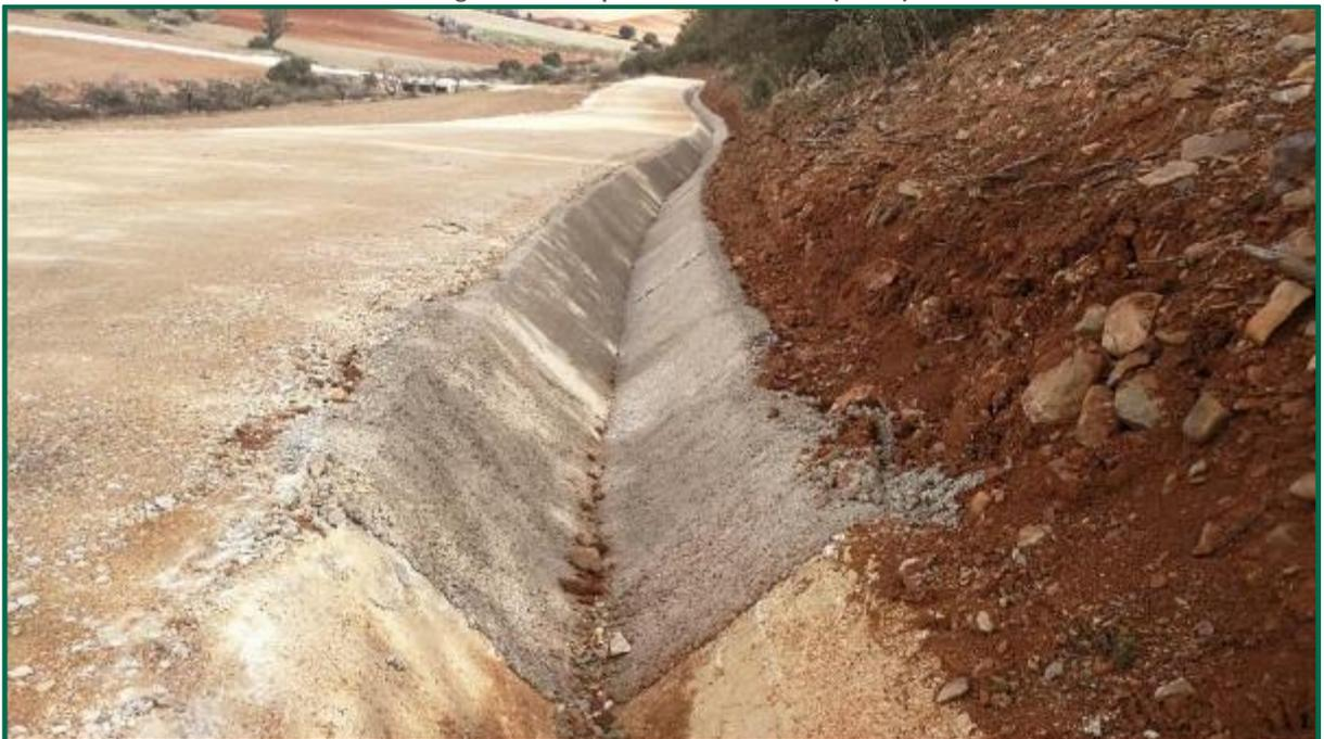
Fotografía 21. Tramo de cuneta hormigonado. (Después)
