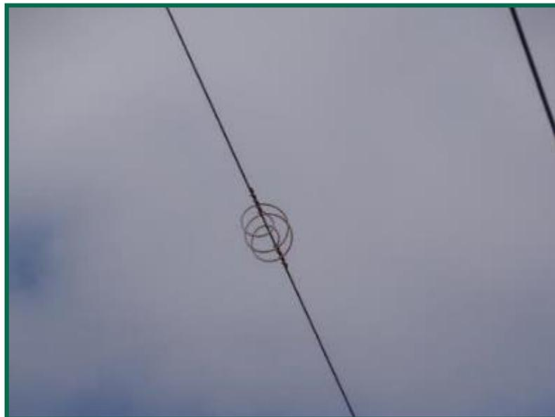
Fotografía 13. Detalle del sistema anti pájaros de la LAAT de evacuación.
