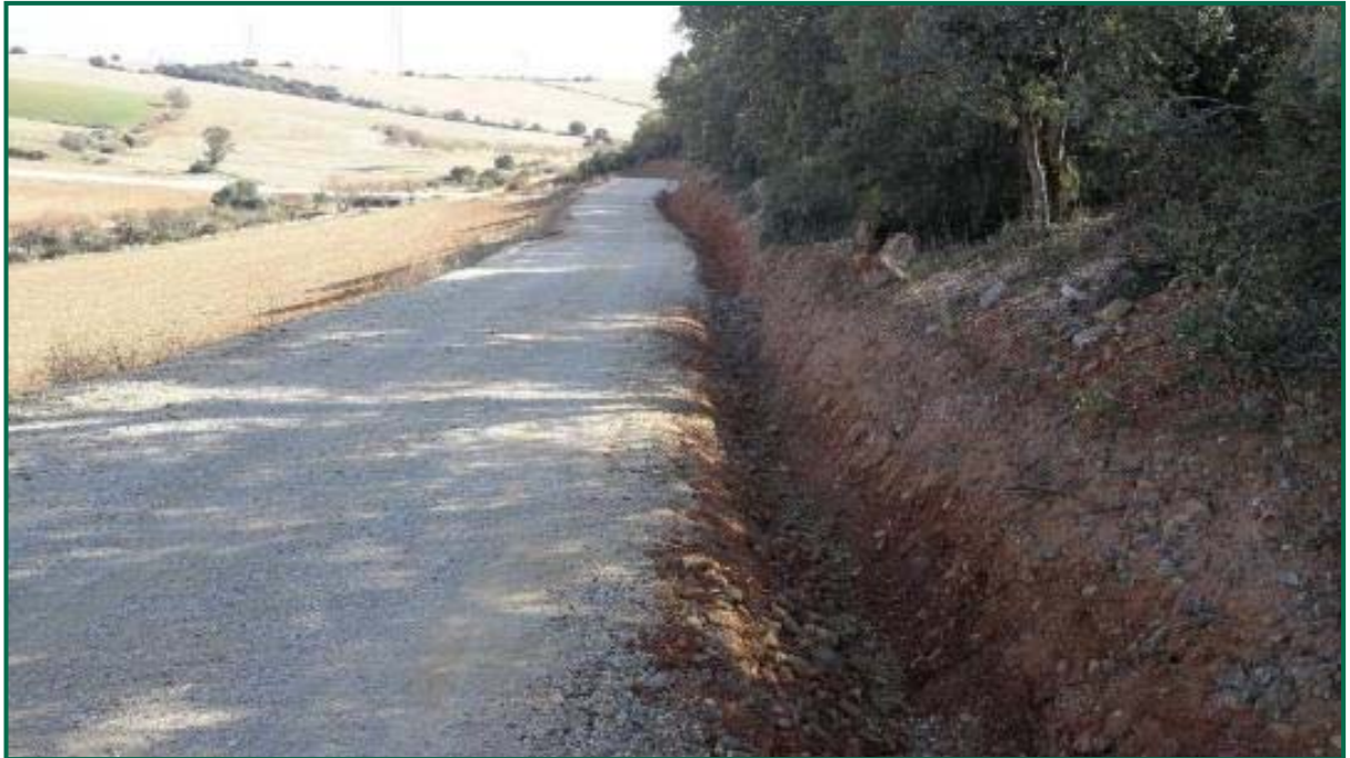
Fotografía 26. Limpieza de las cunetas. (antes)
