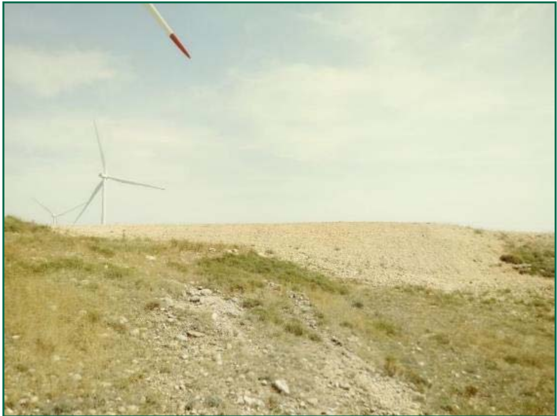
Fotografía 31. Talud en clúster Aguasvivas.
