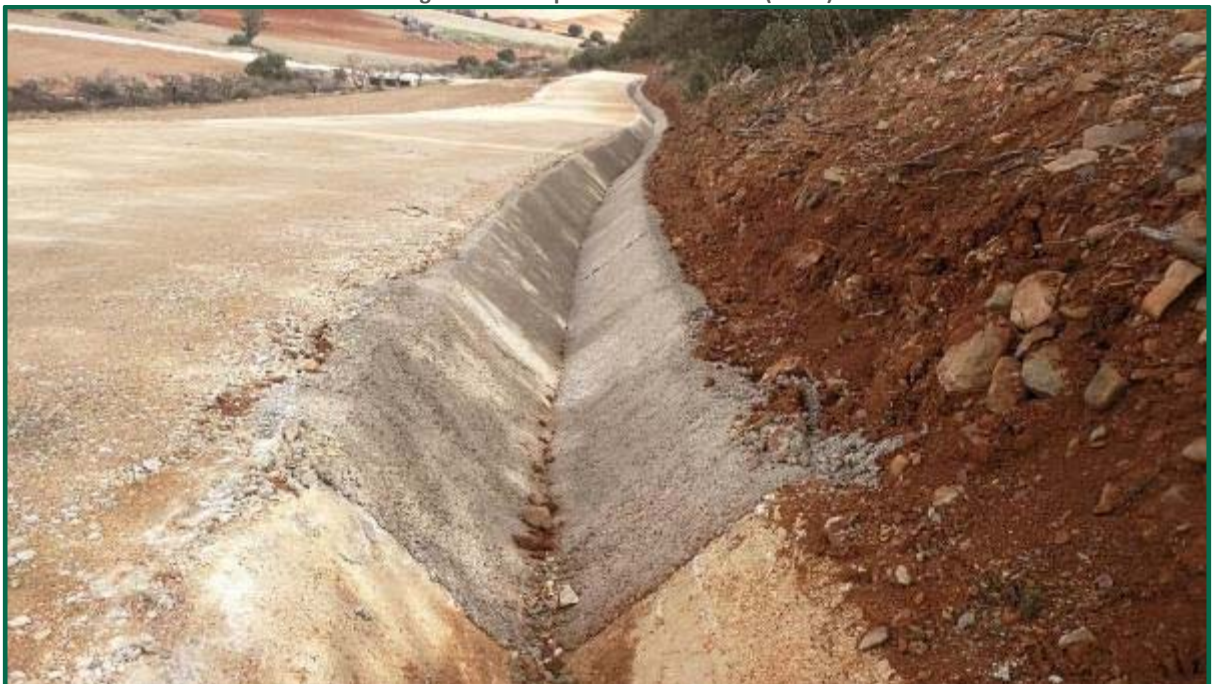
Fotografía 27. Tramo de cuneta hormigonado. (después)
