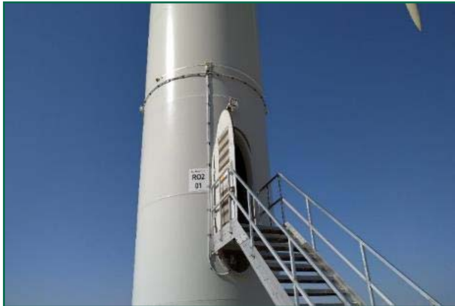
Fotografía 18.. Nuevo sistema W4–D10, instalado en ROII-01.
