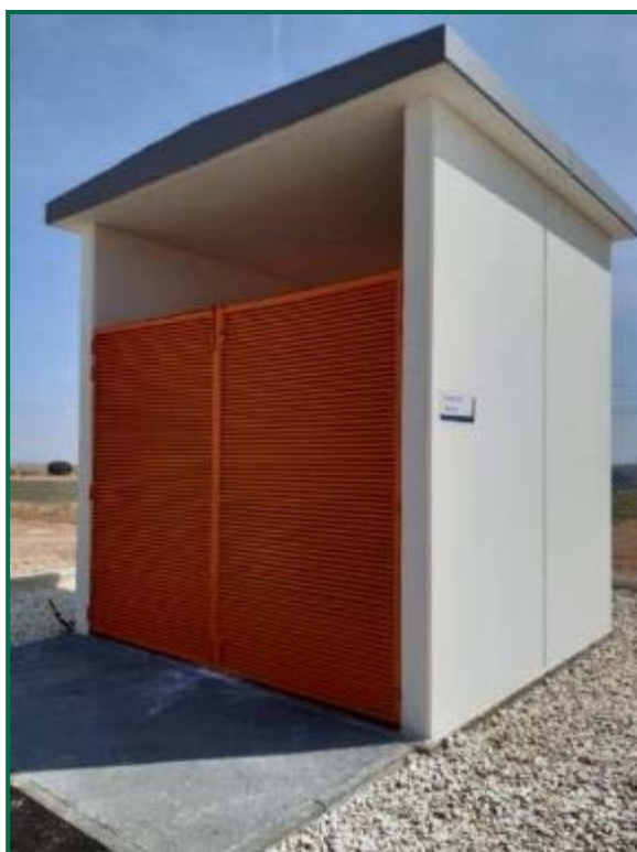
Fotografía 38. Almacén de residuos para gestor autorizado. Fuente: Repsol.
