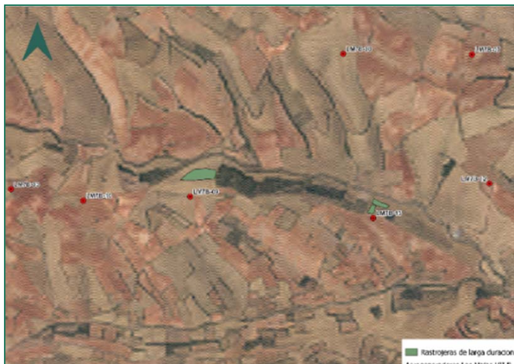
Figura 53. Áreas de cultivo abandonadas; en otro parque eólico del mismo clúster.
