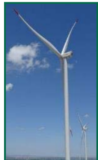
Fotografía 16. Pintado de palas en los aerogeneradores.
