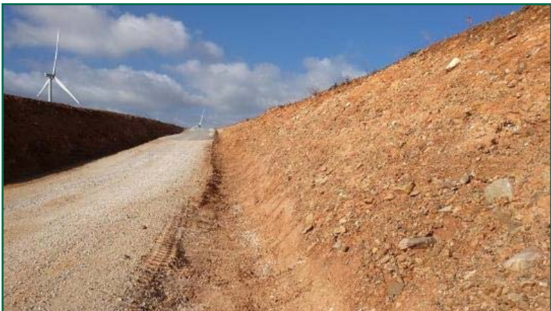
Fotografía 25. Limpieza de las cunetas.
