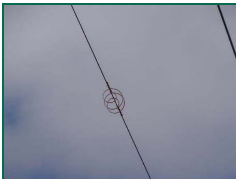
Fotografía 15. Detalle del sistema anti pájaros de la LAAT de evacuación.
