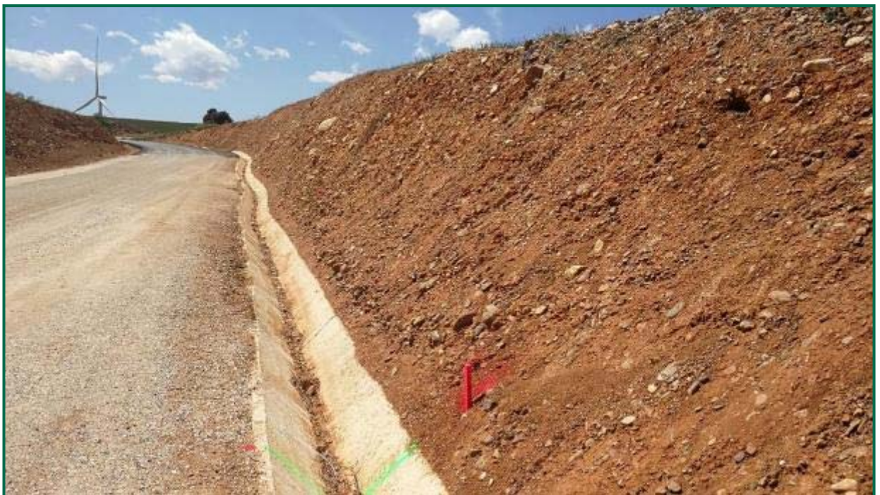
Fotografía 29. Talud en proceso de restauración y protección.
