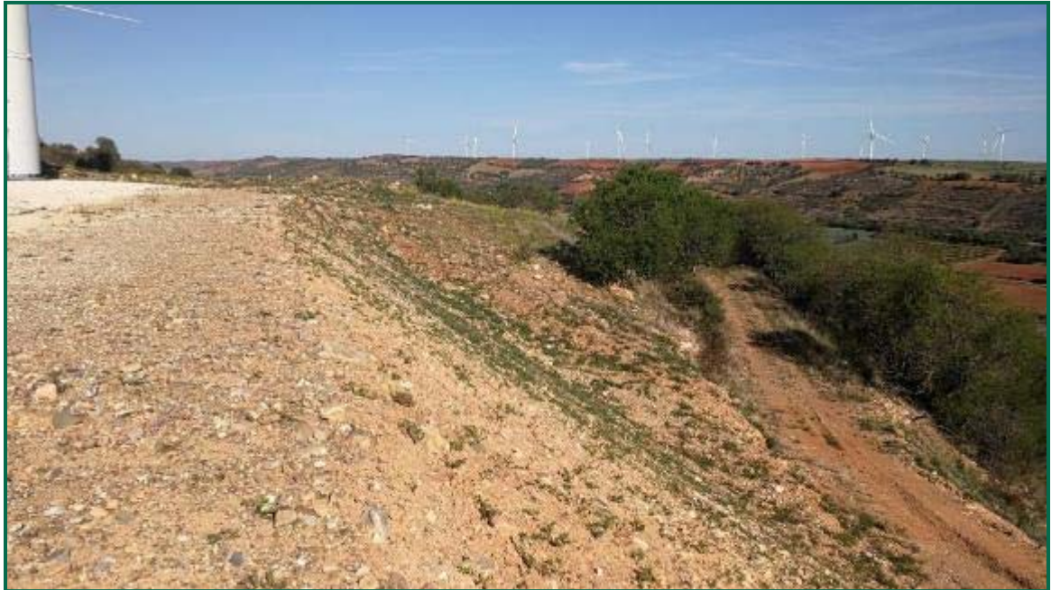
Fotografía 35. Talud en clúster Aguasvivas.
