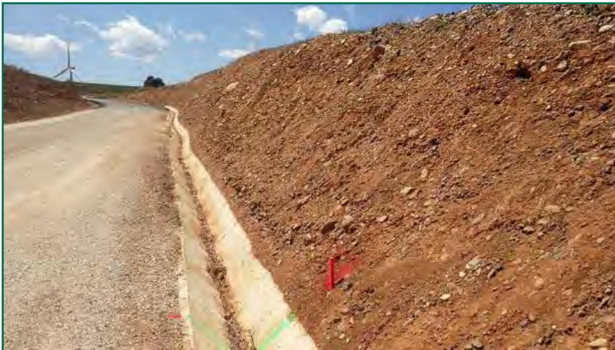
Fotografía 25. Talud en proceso de restauración y protección.
