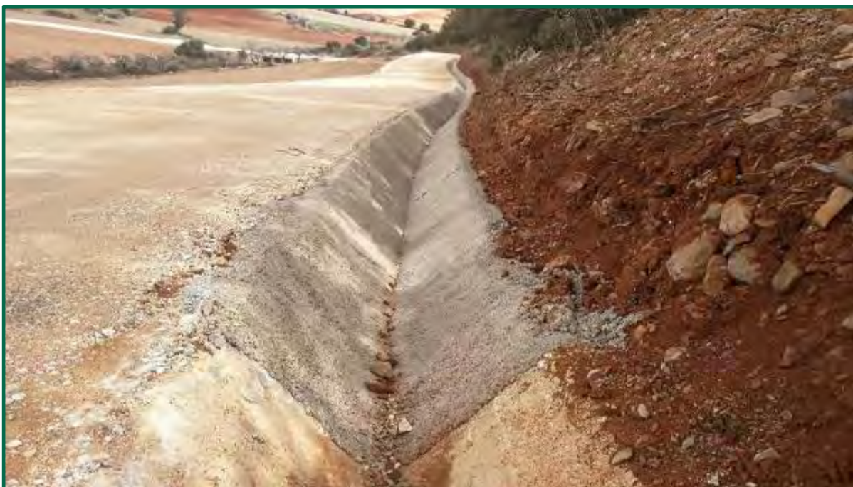
Fotografía 23. Tramo de cuneta hormigonado. (Después)
