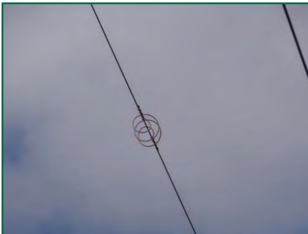
Fotografía 14. Detalle del sistema salvapájaros de la LAAT de evacuación.
