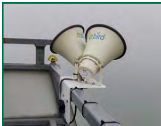
Fotografía 1. Sistema de anclaje de los altavoces.
