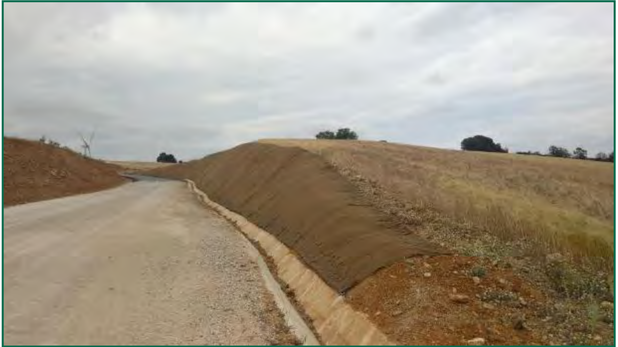
Fotografía 26. Talud cubierto con malla metálica y fibra de coco.
