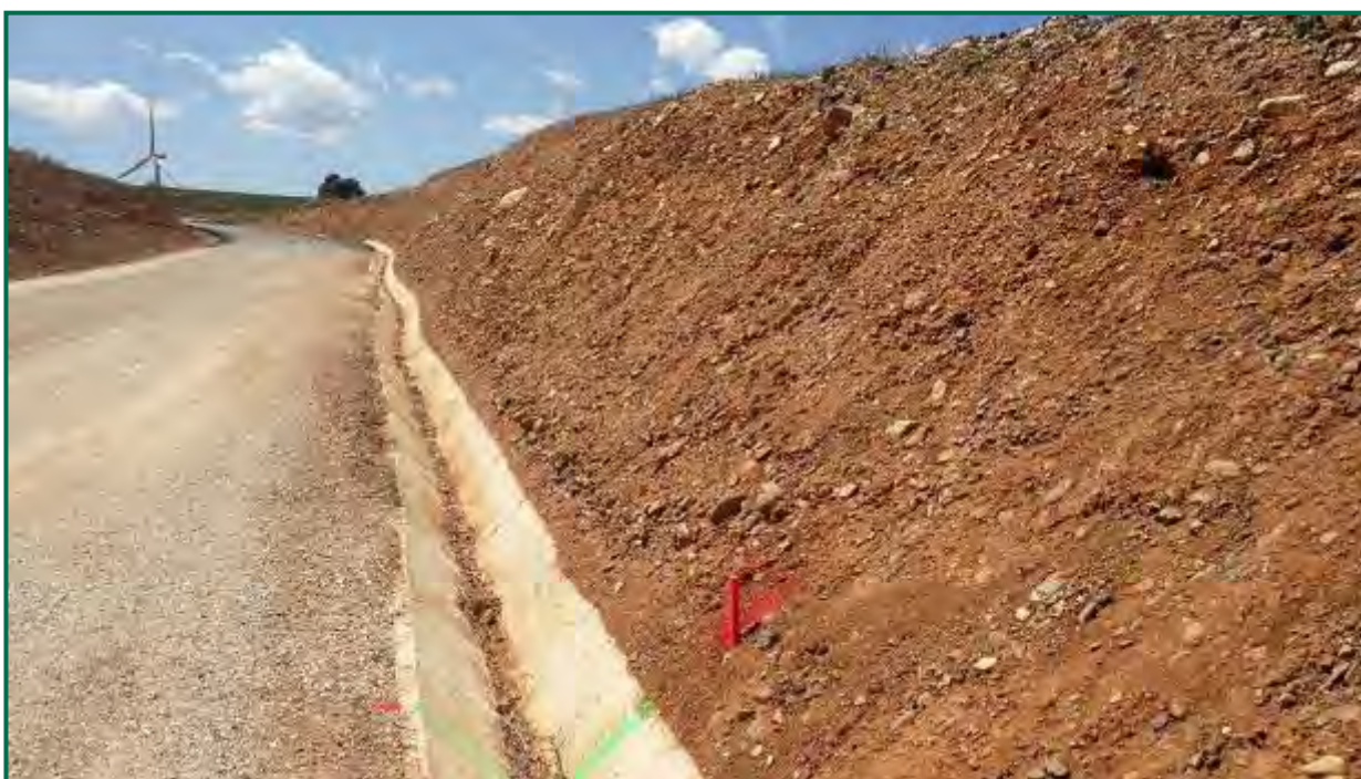
Fotografía 25. Talud en proceso de restauración y protección.
