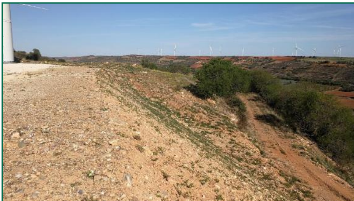
Fotografía 30. Talud en clúster Aguasvivas.
