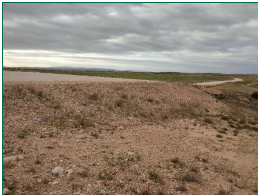
Fotografía 27. Talud en clúster Aguasvivas, aspecto actual.
