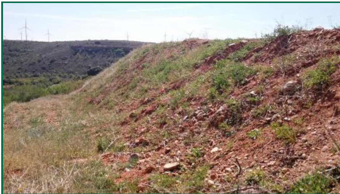
Fotografía 28. Talud en el clúster Aguasvivas.
