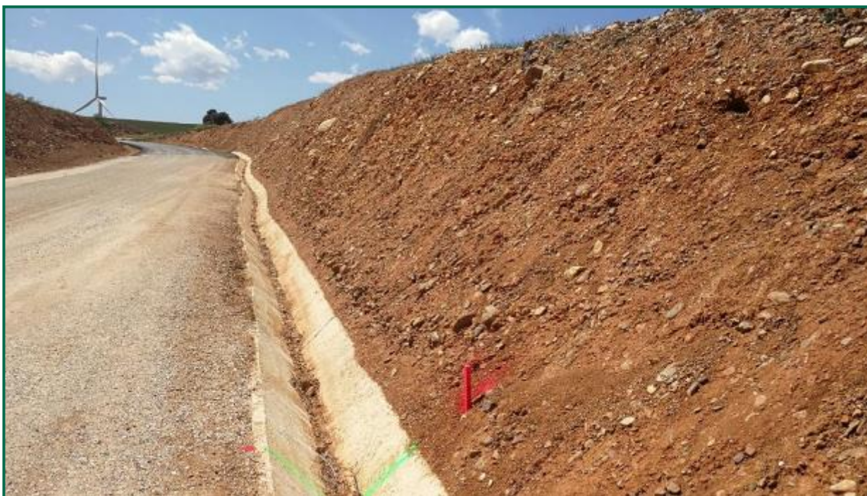
Fotografía 24. Talud en proceso de restauración y protección.
