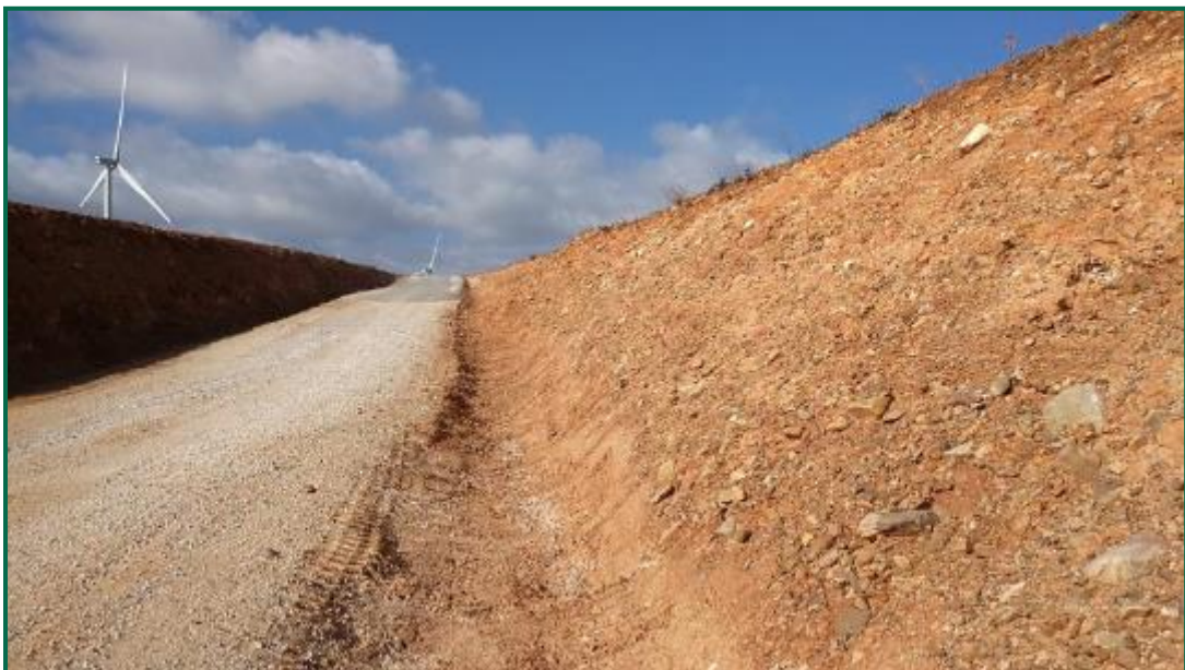
Fotografía 20. Limpieza de las cunetas.
