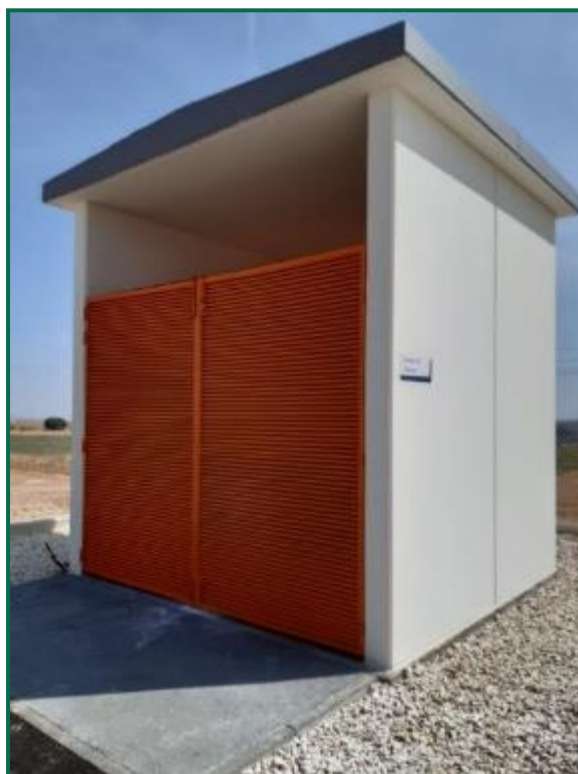
Fotografía 32. Almacén de residuos para gestor autorizado. Fuente: Repsol.
