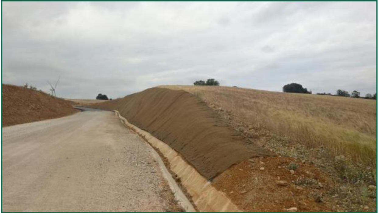
Fotografía 25. Talud cubierto con malla metálica y fibra de coco.
