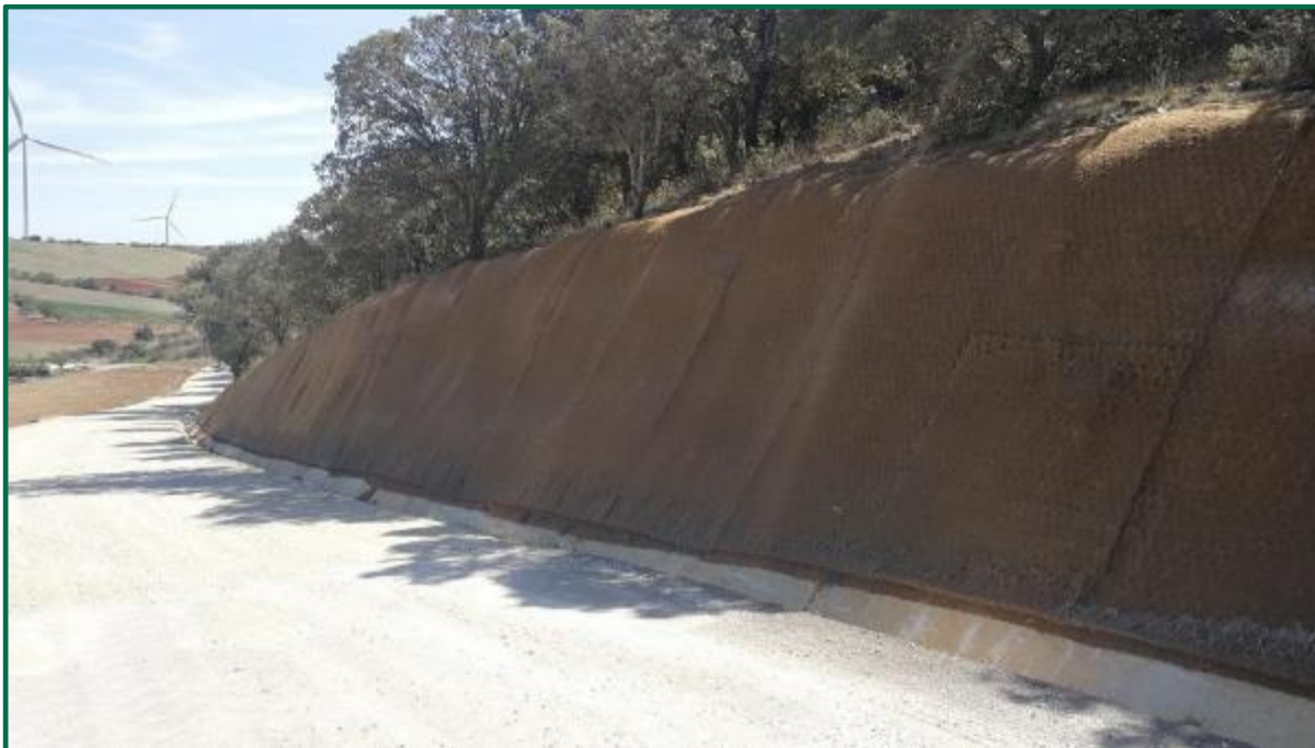
Fotografía 23. Fibra de coco y malla metálica en talud. (Después)
