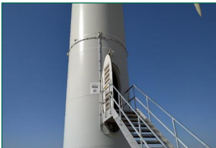
Fotografía 17. Nuevo sistema W4-D10, instalado.
