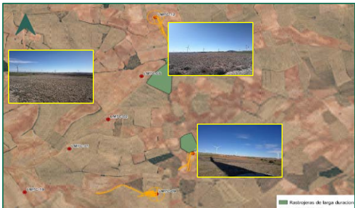
Figura 59. Áreas de cultivo abandonadas; en otro parque eólico del mismo clúster.
