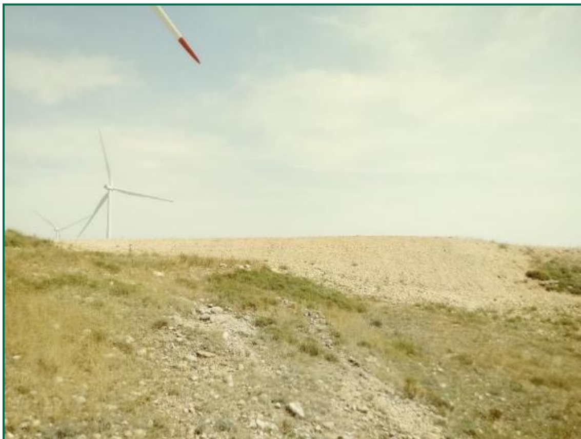
Fotografía 26. Talud en clúster Aguasvivas.
