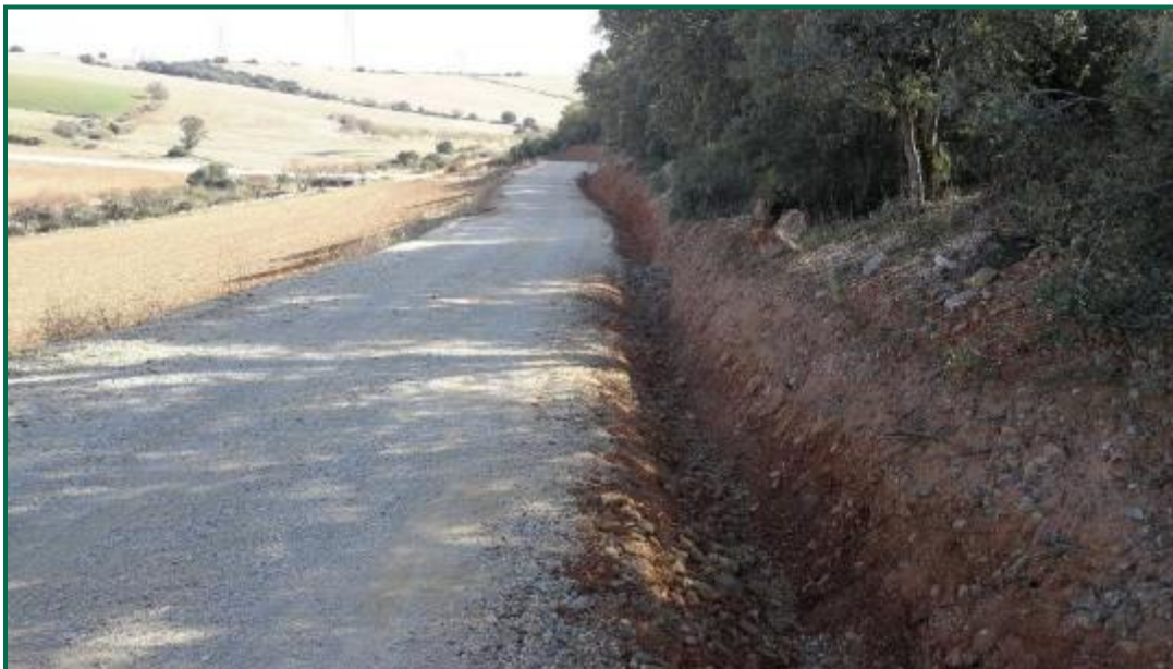
Fotografía 21. Limpieza de las cunetas. (Antes)
