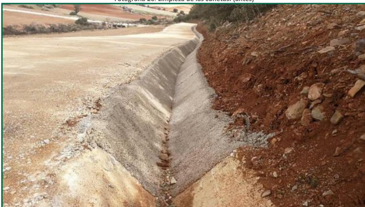
Fotografía 27. Tramo de cuneta hormigonado. (después)
