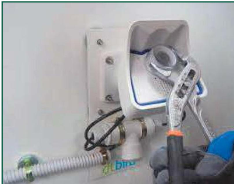
Fotografía 22. Cubrelente acoplado a la nueva cámara.
