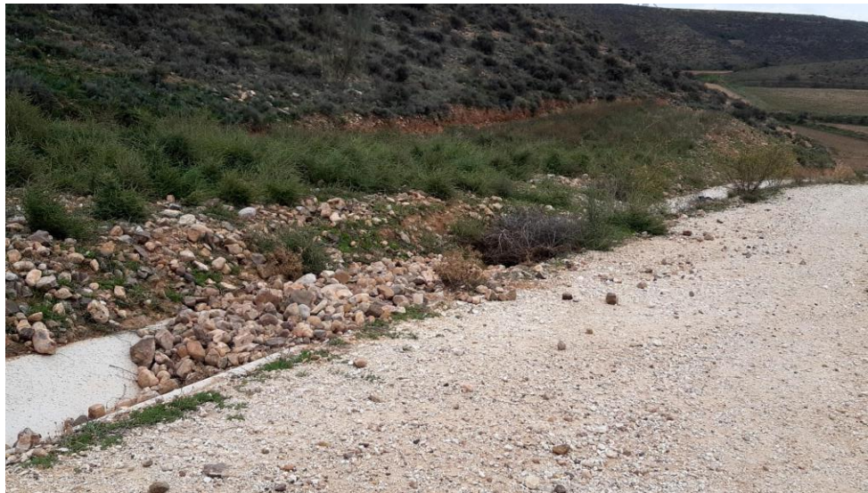
Foto 1. Tubo de drenaje taponado por vegetación arbustiva y piedras en vial de acceso al aero L6D.04.
