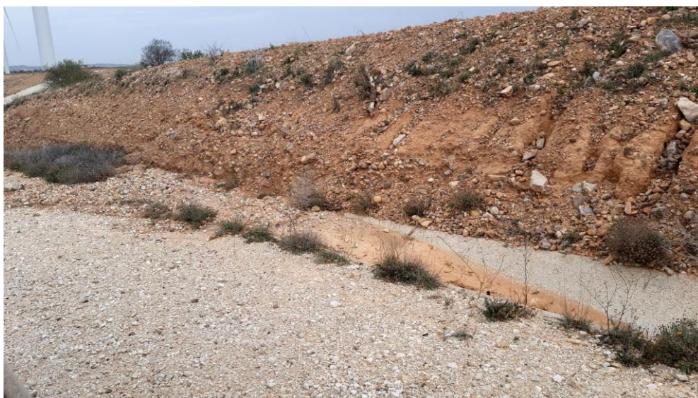
Foto 2. Cuneta llena de sedimentos y vegetación arbustiva en vial de acceso al aero L6D.03.
