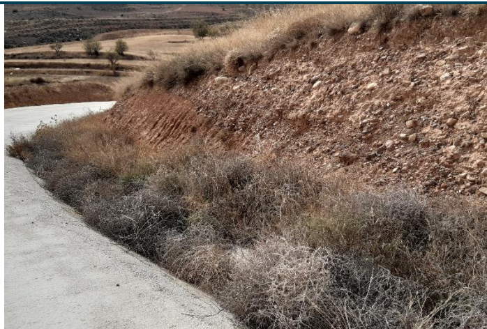
Fig. 2 Cuneta llena de vegetación arbustiva en vial de acceso al aero L6D.02. Sigue toda la cuneta hasta el aero. Fuente: Elaboración propia
