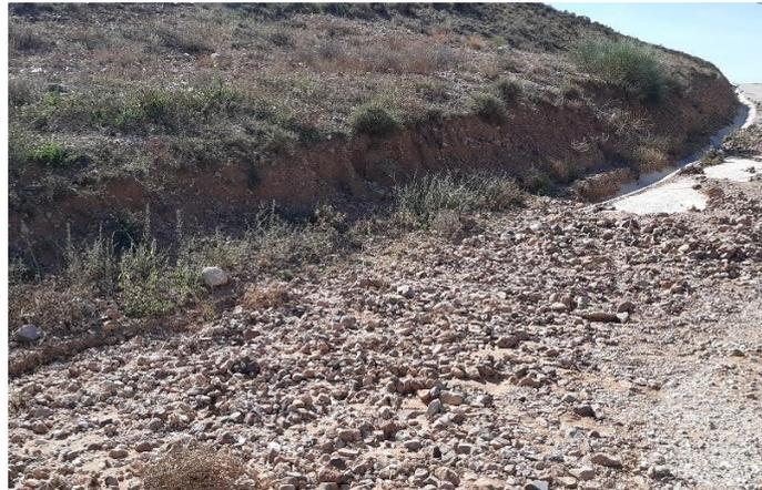
Foto 1. Cuneta llena de sedimentos y rocas en el vial de acceso a LM6C – 12.
