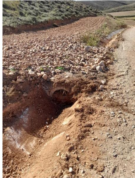
Foto 4. Limpieza de cunetas en mal estado.
