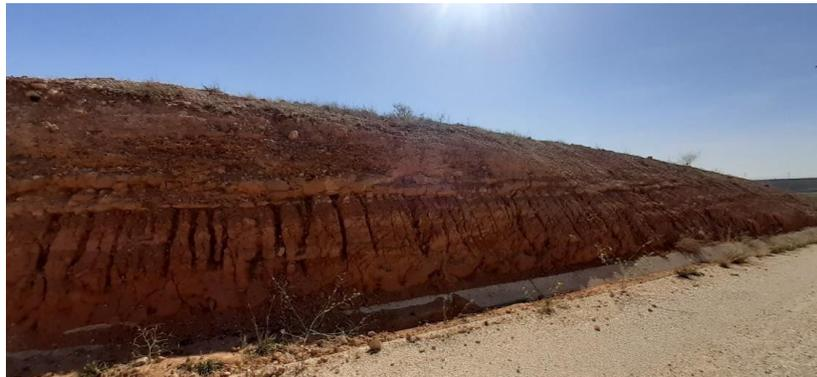
*Foto 6. Erosión hídrica en materiales lutíticos del talud de LM6C – 07.*
