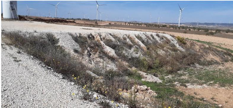
*Foto 5. Erosión hídrica en materiales lutíticos del talud de LM6C – 07.*
