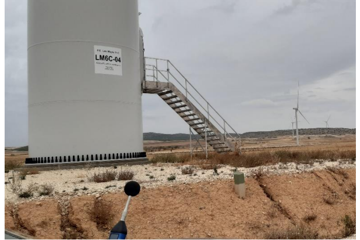
Fig. 2 Medición acústica en L6B.03. Fuente: Elaboración propia
