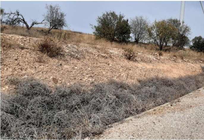
Fig. 3 Cuneta llena de vegetación arbustiva en vial de acceso al aero L6C.10. Tapona ODT. Fuente: Elaboración propia
