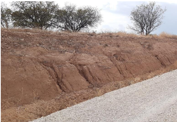
Fig. 3 Erosión hídrica en materiales lutíticos del talud de desmonte del vial de acceso al aero LM6C.06. Fuente: Elaboración propia
