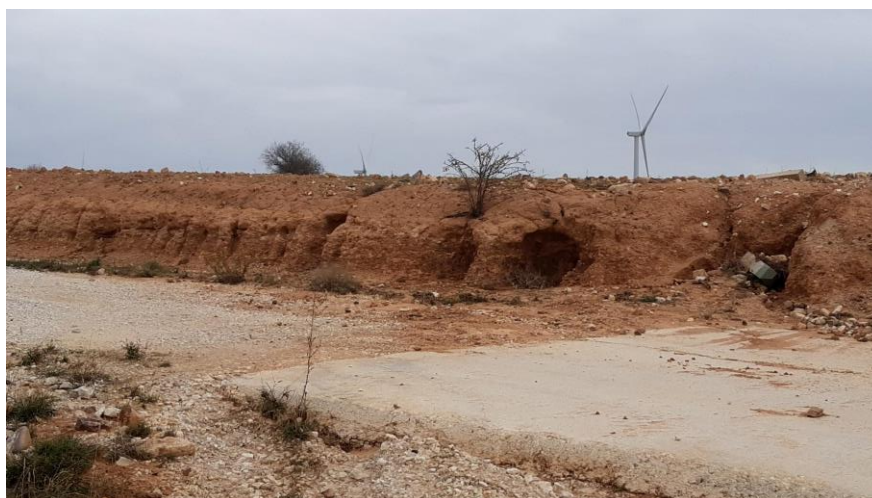
Foto 3. Erosión hídrica en materiales lutíticos del talud de desmonte del vial de acceso al aero L6B.09.
