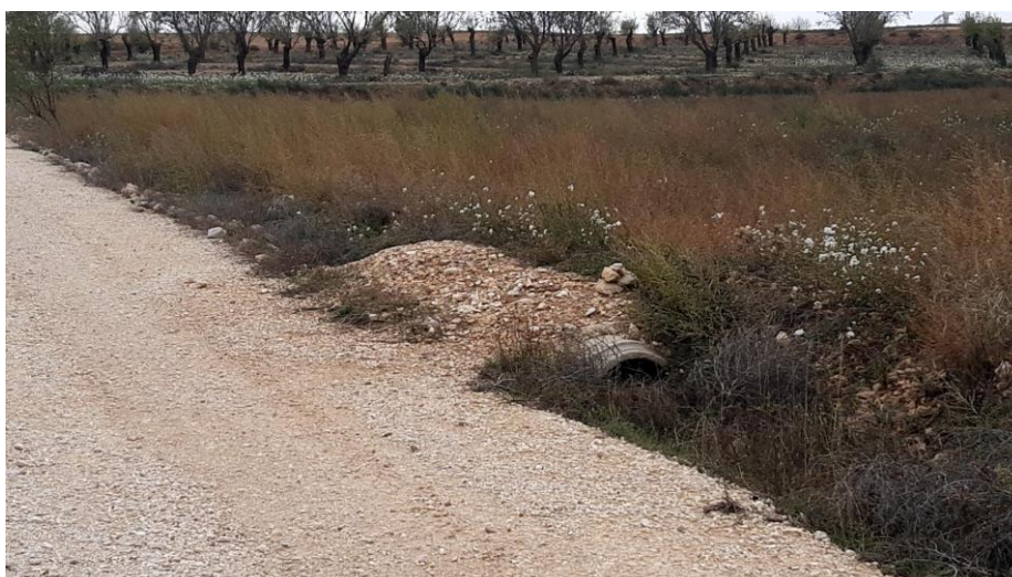
Foto 2. Tubo de drenaje taponado con vegetación arbustiva en vial de acceso al aerogenerador L6B – 06.
