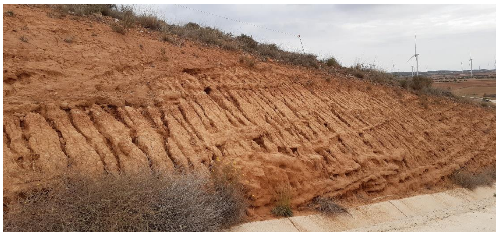
Foto 3. Erosión hídrica en materiales lutíticos del talud de desmonte del vial de acceso al aero L6B – 13.
