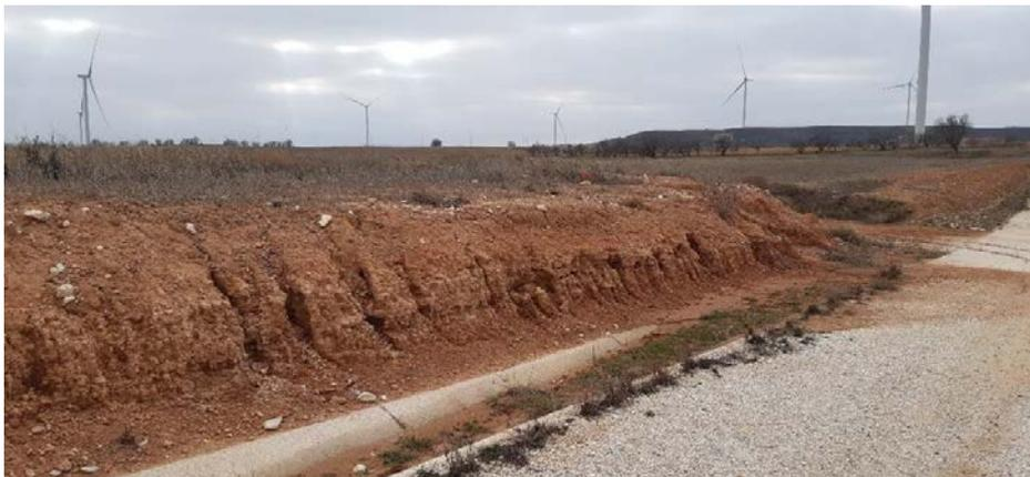
Foto 3. Erosión hídrica en materiales lutíticos del talud de desmonte del vial de acceso a LM6B – 09.
