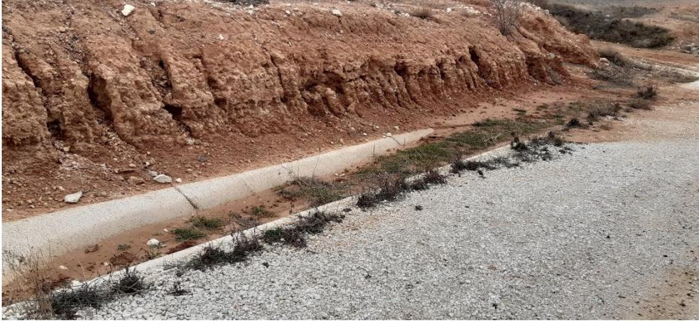
Foto 2. Cuneta llena de sedimentos en vial de acceso al aero L6B – 09.
