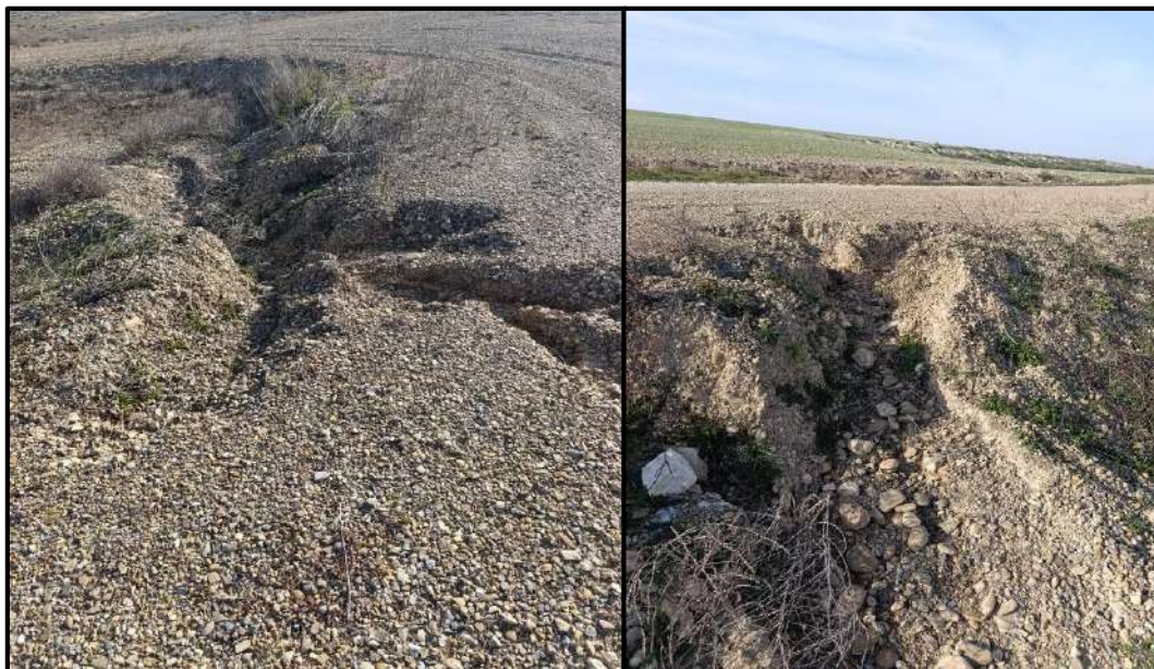
Fotografía 4. Estado actual del proceso erosivo en el vial de acceso a la turbina HE03.
