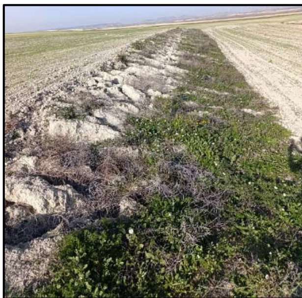
Fotografía 8. Pequeño talud con regueros en el sector superior y vegetación densa en la parte inferior, localizado próximo a la turbina HE03.
