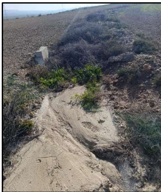
Fotografía 7. Cuneta colmatada por sedimentos finos y paso de agua obstruido por restos de vegetación seca, próximo a la turbina HE03.
