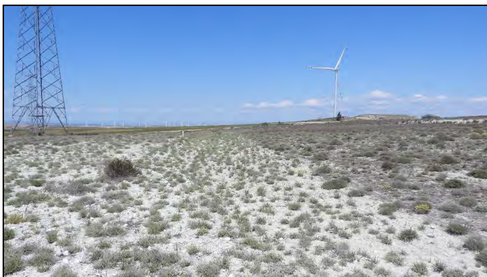
Fotografía 13. Aspecto de la zanja de media tensión entre la turbina HE02 y la carretera
