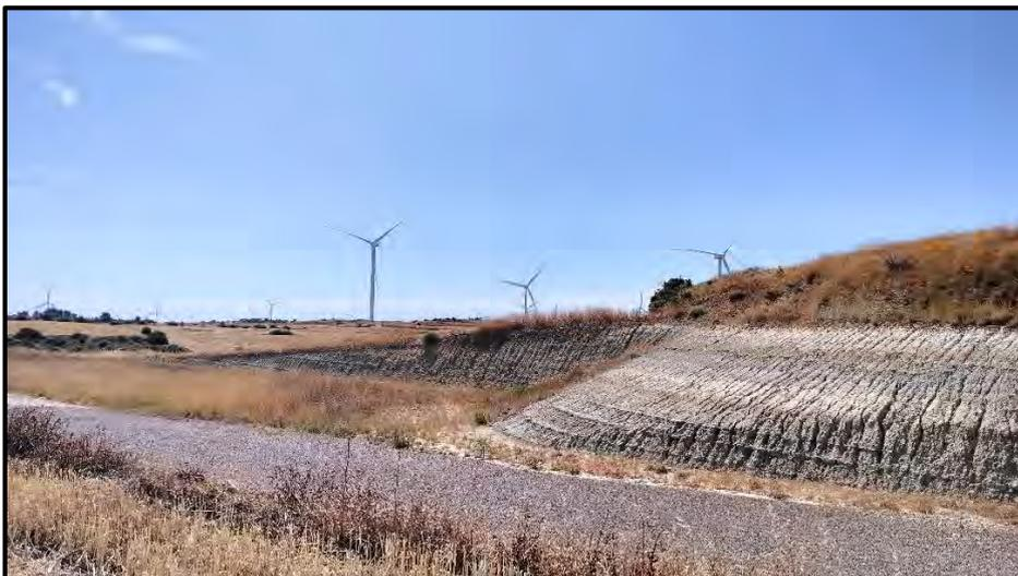
**Fotografía 4.** Desmonte con procesos erosivos al suroeste de la turbina LP03
