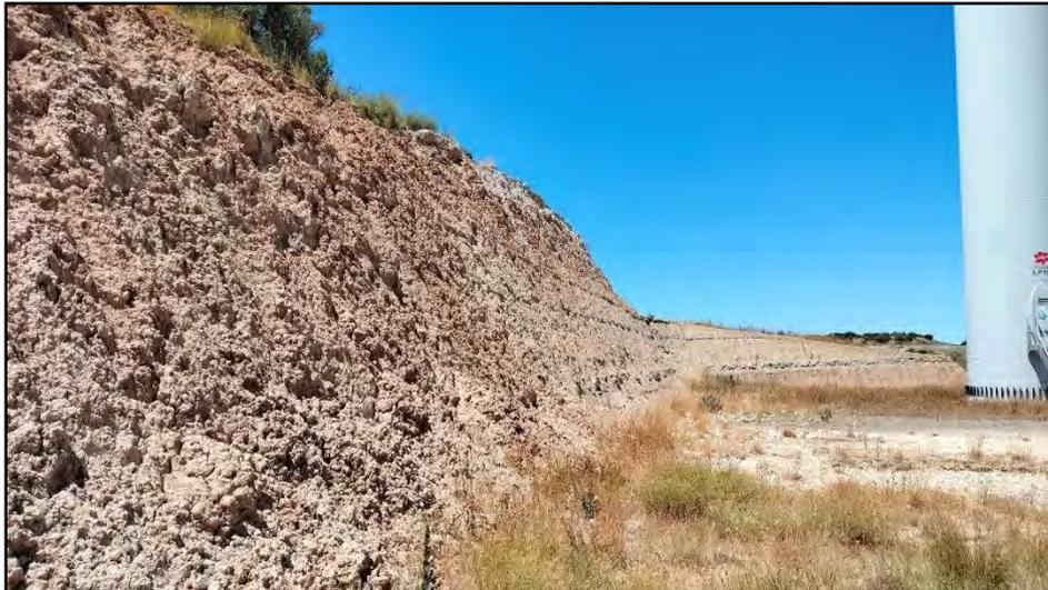
**Fotografía 10.** Talud con peligro de desprendimiento en la plataforma de la turbina LP10
