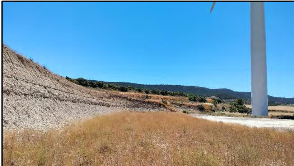
**Fotografía 5.** *Desmante en la turbina LP04 con regueros y siembra exitosa a sus pies*
