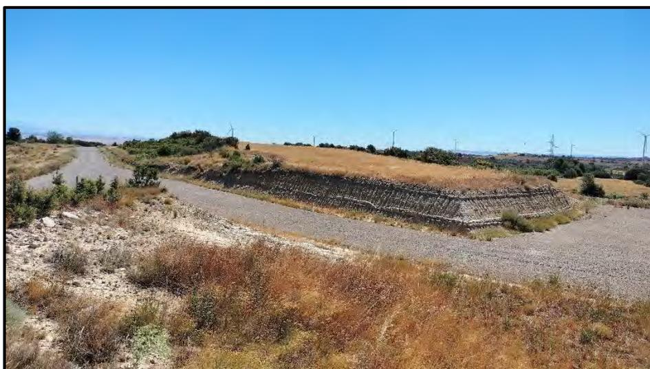
**Fotografía 7.** *Desmante de escasa altura con procesos erosivos activos en las inmediaciones de la turbina LP08*
