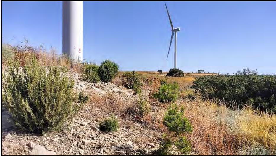
**Fotografía 2.** Siembra exitosa en el talud de la plataforma del aerogenerador LP02
